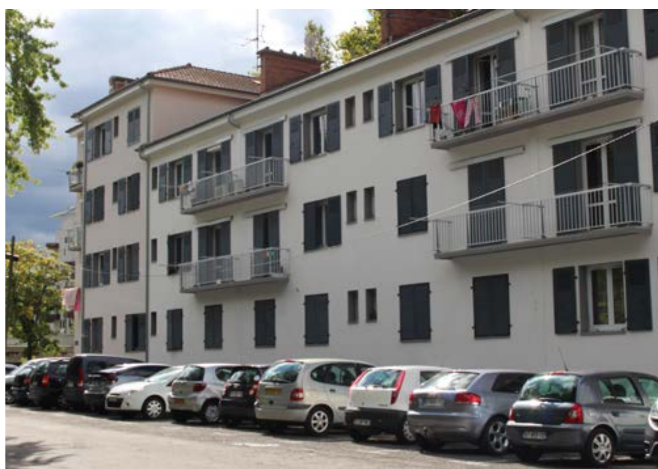
Hadbi, R. (2021). Bâtiment rénové de la cité Jean Macé originelle (1936), Grenoble.
