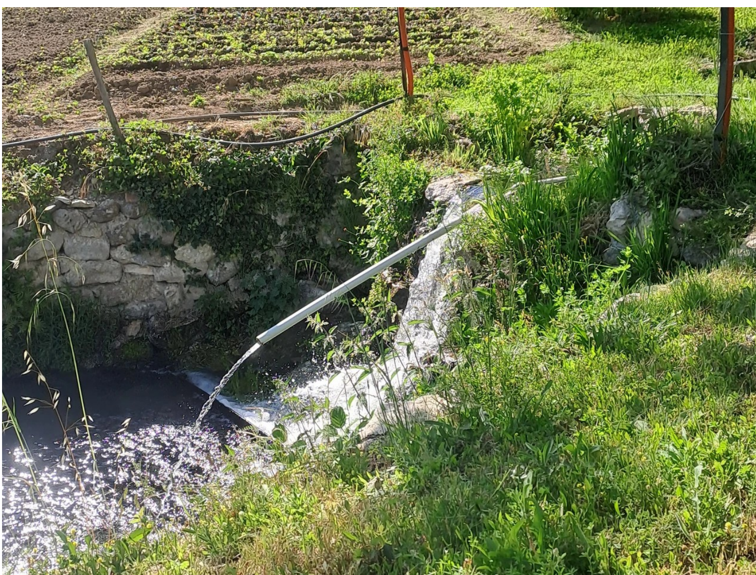
Conduites en PVC et culture d'oignon doux : le nouveau visage du terroir de Mandagout
