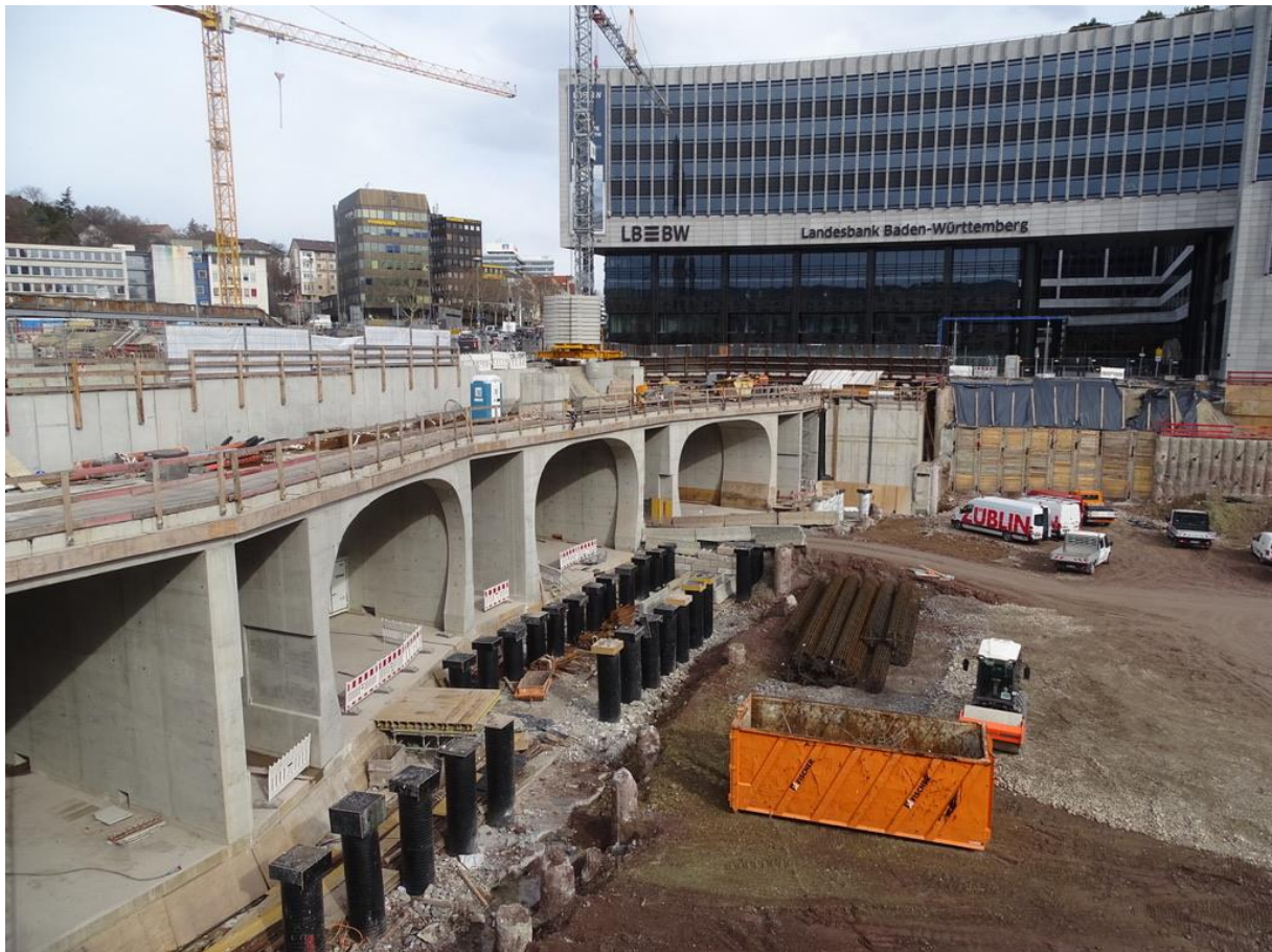
Photo. 7 - Chantier et coupe de la gare de Stuttgart en 2019, indiquant les 4 grandes galeries qui seront toutes dotées de 2 voies traversantes (Cliché : J-P. Wolff).
