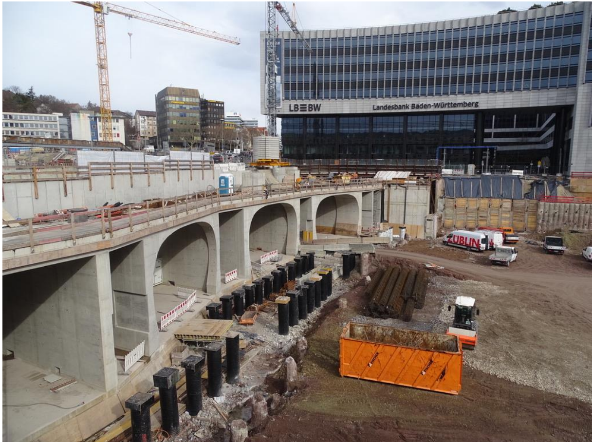
Photo. 7 - Chantier et coupe de la gare de Stuttgart en 2019, indiquant les 4 grandes galeries qui seront toutes dotées de 2 voies traversantes (Cliché : J-P. Wolff).
