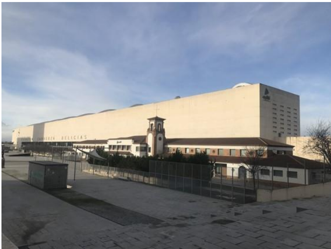
Photo. 4 - La gare monumentale de Zaragoza Delicias (2003) surplombant l'ancienne gare (1932), (Cliché : N. Quilez Aznar)
