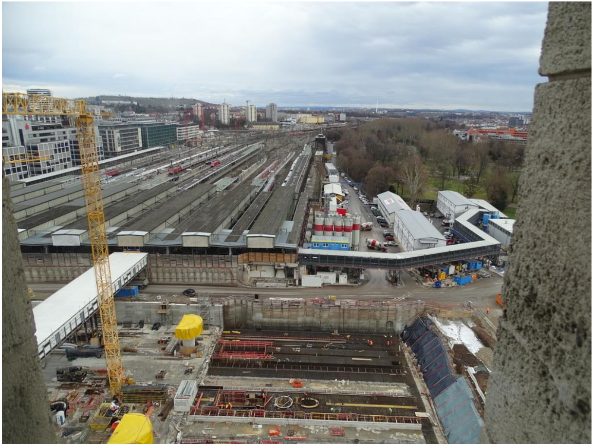
Photo. 6 - Chantier de la gare de Stuttgart en 2019 avec le recul des quais et au premier plan les travaux d'excavation de la future gare souterraine (Cliché : J-P. Wolff).
