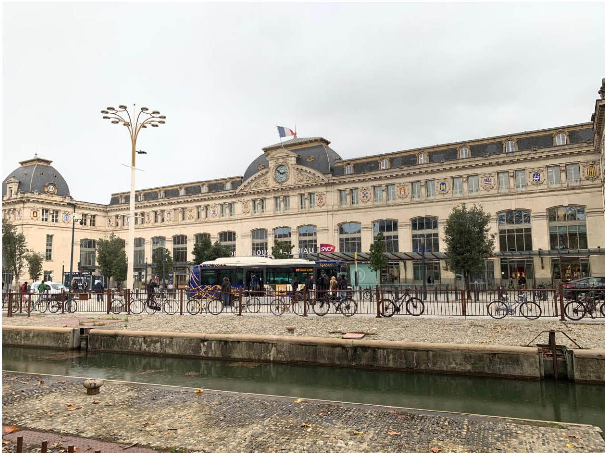
Photo. 3 -Vue du bâtiment historique de la gare de Toulouse Matabiau en 2023 (Cliché J-P. Wolff)
