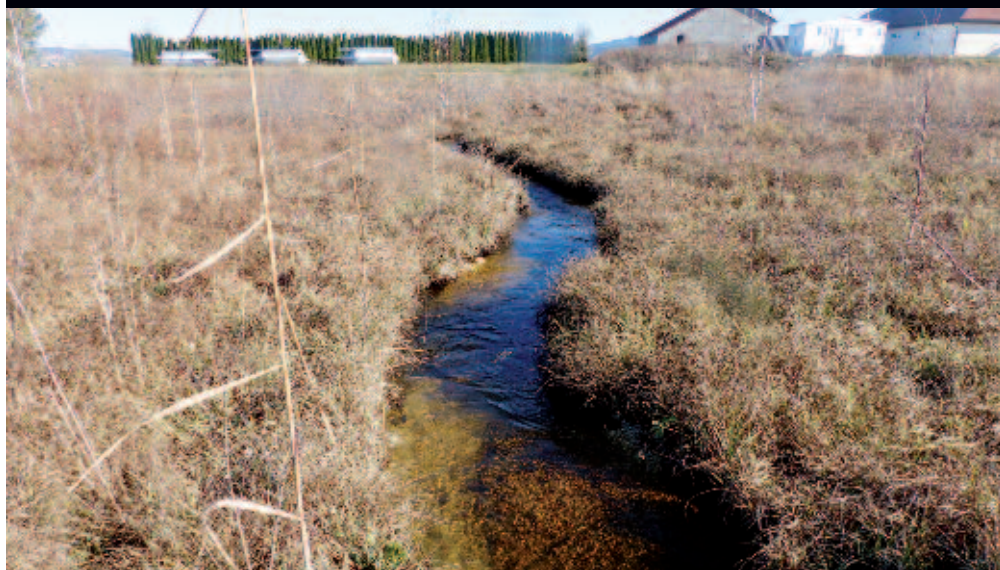
Marais du Gouterot à Bannans, après travaux, novembre 2020.
