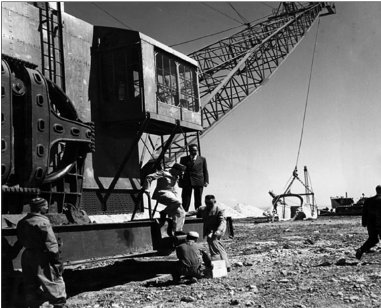
Figure 2. Le chantier de Sidi Daoui, avec utilisation de draglines géants (1952). © Archives photographiques de l'OCP.
