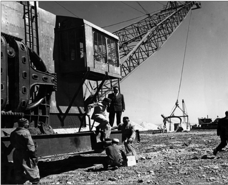
Figure 2. Le chantier de Sidi Daoui, avec utilisation de draglines géants (1952).
