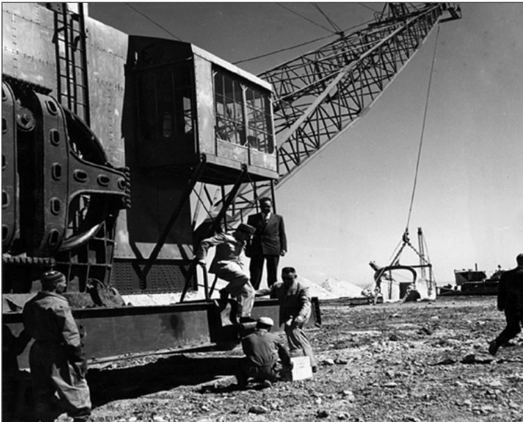
Figure 2. Le chantier de Sidi Daoui, avec utilisation de draglines géants (1952). © Archives photographiques de l'OCP.
