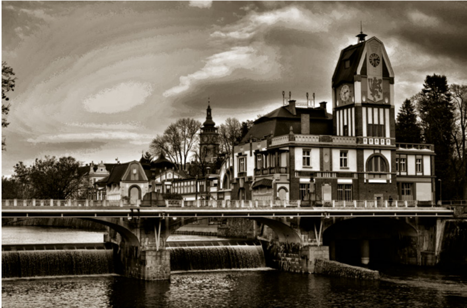
Figure 9. Hydrocentrale sur l'Elbe, Hučák. (© Marcela Efmertová, 2019)
