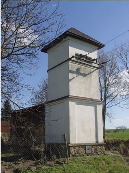
Figure 12. Transformateur, Alberovice. (© Marcela Efmertová, 2019)
