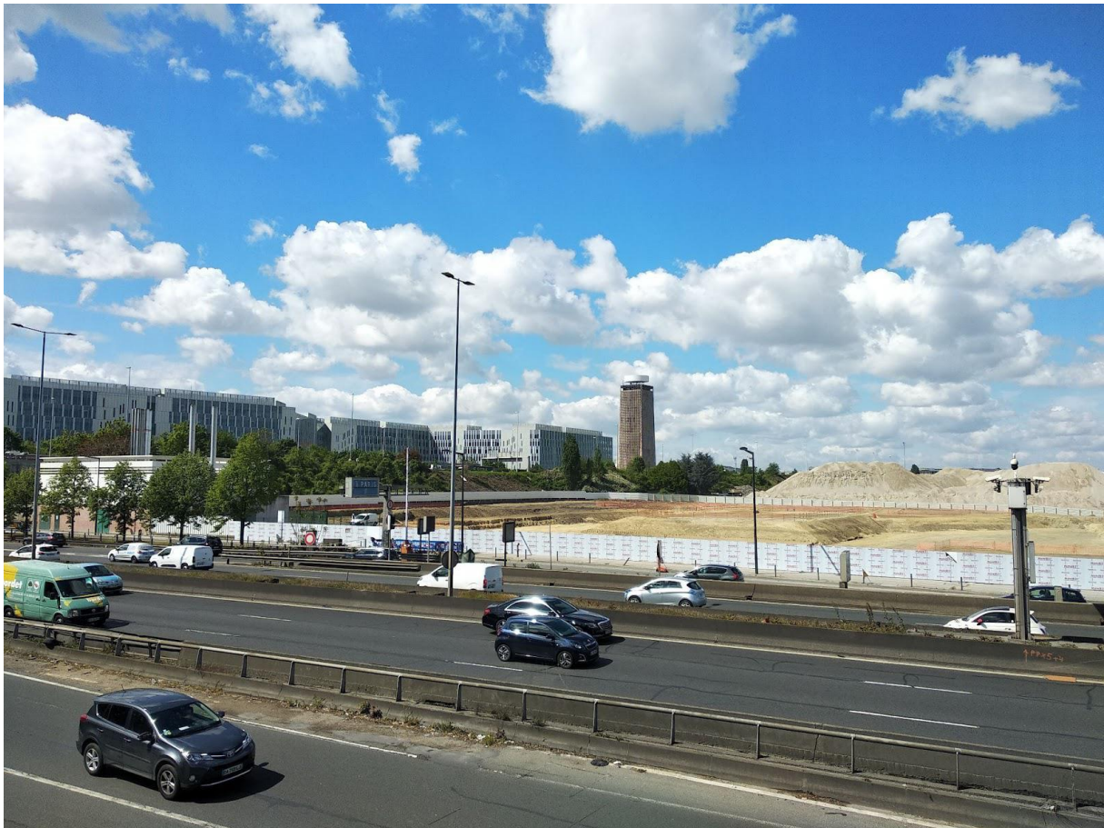
Photographie 3 : Vue depuis la dalle du Stade de France du chantier du centre aquatique olympique de Saint-Denis, avec la Tour Pleyel en arrière-plan, qui s'accompagnera d'un franchissement piéton de l'A1, A. Faure, mai 2021.
