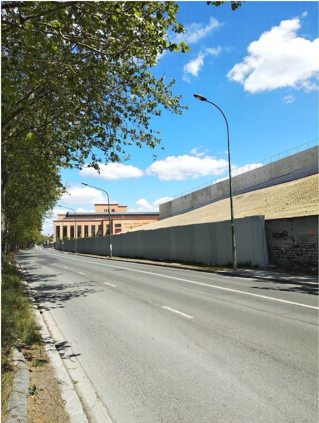
Photographie 4 : Chantier du Village olympique depuis la route surplombant la Seine, située à gauche des arbres, A. Faure, mai 2021.
