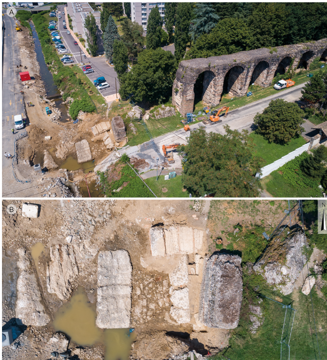
Fig. 2 – Le pont de Beaunant à Sainte-Foy-lès-Lyon : A , vue vers le nord-est de l'emprise de la fouille et de la moitié orientale du pont ; B , vue sommitale de l'emprise de fouille (clichés : Actuadrone).
