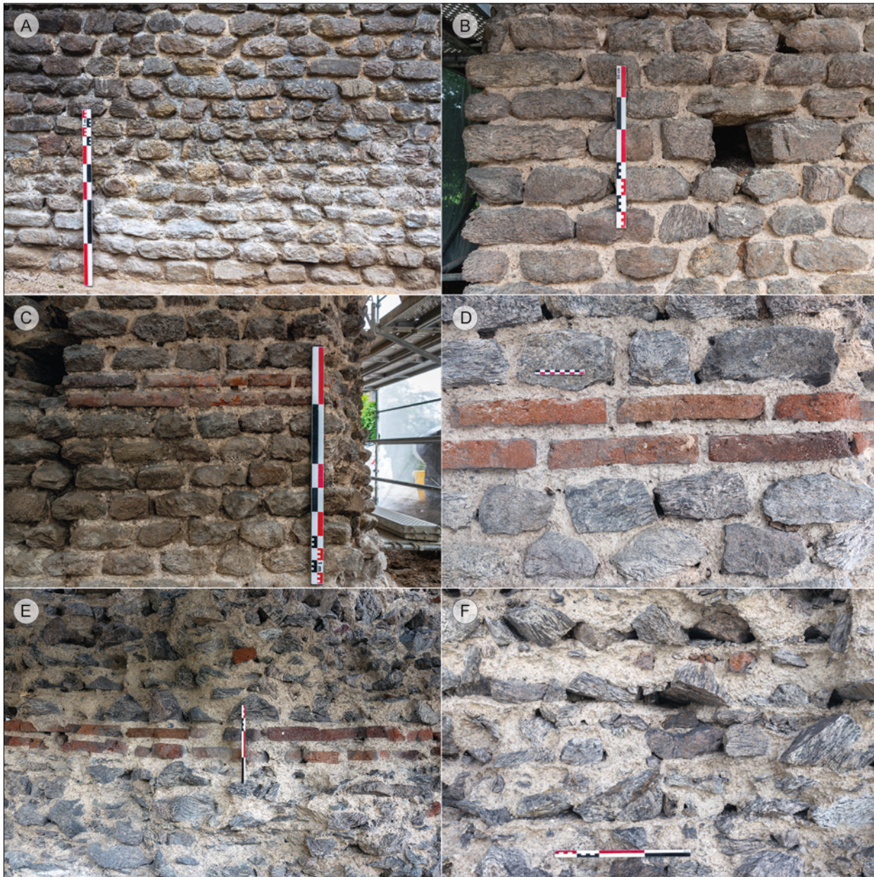
Fig. 10 – Les élévations des piles du double rampant des Tourillons à Craponne : A , parement de la face sud de la pile ouest ; B , chaînage d'angle et trou de boulin sur la face sud de la pile ouest ; C et D , vues de la double arase de briques sur la face est de la pile est ; E , vue de la double arase de briques dans la fourrure de la pile est du côté nord ; F , vue de détail de la fourrure de la pile est (clichés A , B et C : D. Baldassari ; clichés D , E et F : E. Bouticourt ).
