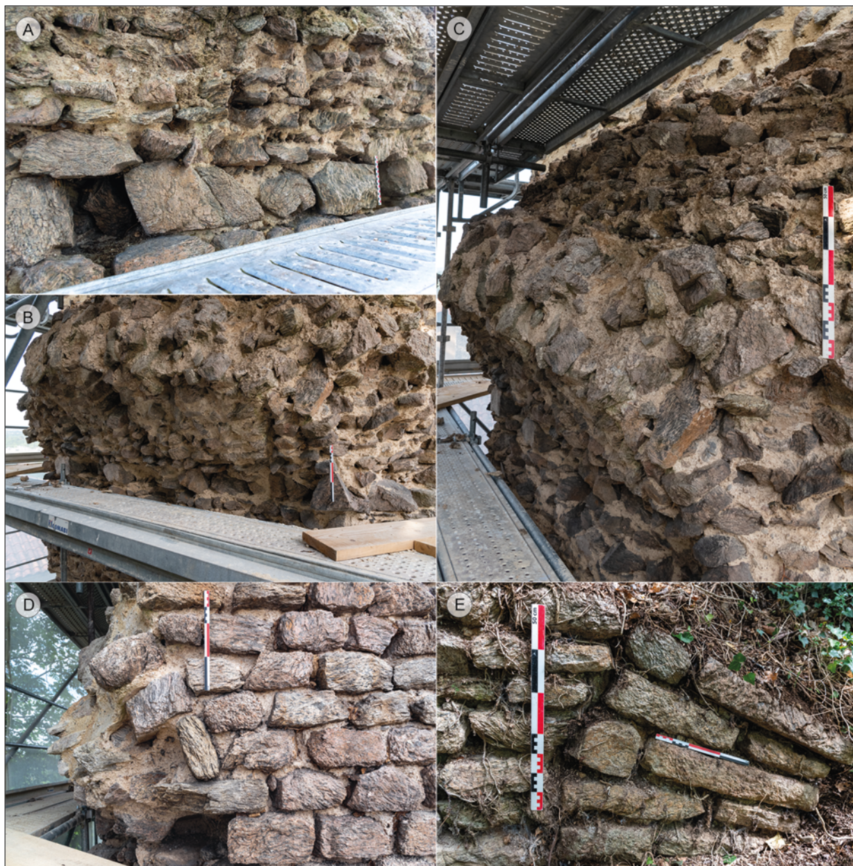
Fig. 11 – Voûtes de la pile ouest du double rampant des Tourillons à Craponne: A , vue du plan de naissance de la voûte sur le côté ouest de la pile ouest; B , départ de la voûte sur le côté est de la pile ouest, vue du nord-est; C , voûte et charge de maçonnerie établie au-dessus sur le côté est de la pile ouest, vue du nord; D , parement de l'arc de tête de la voûte du côté ouest de la pile ouest, vue du sud; E , parement de l'arc de tête d'un départ de voûte situé vers l'extrémité du rampant aval à l'est, vue vers le nord (clichés: D. Baldassari).
