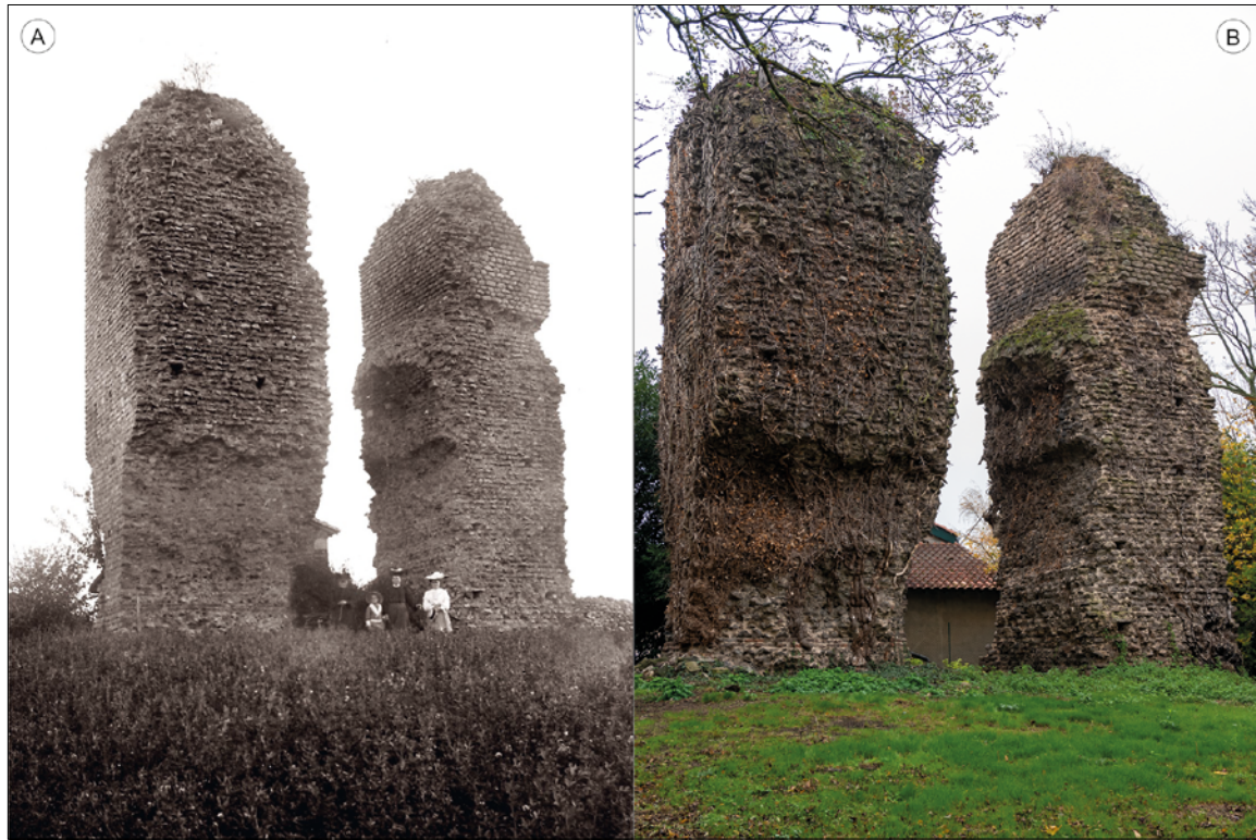
Fig. 2 – Les vestiges des piles des Tourillons à Craponne vus depuis le nord: A, vue ancienne; B, vue actuelle (cliché A: s.d., auteur inconnu; cliché B: E. Bouticourt, Archeodunum).
