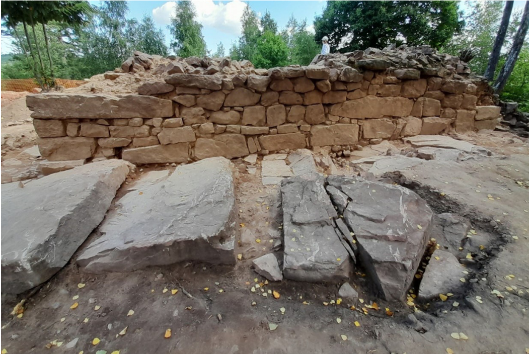
Fig. 17. Gros bancs à pendage ouest au sud du bâtiment sommital. Cliché : P. Elsass
