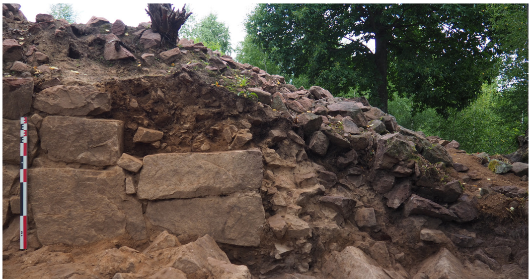
Fig. 33. Vue en coupe du cône d'éboulis (US 1022) reposant contre l'angle sud-est du bâtiment BAT1001. Cliché : F. Minot
