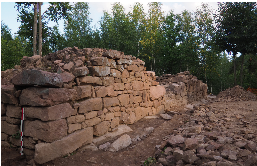
Fig. 28. Vue générale du mur ouest du bâtiment BAT1001 depuis le nord-ouest. Cliché : F. Minot
