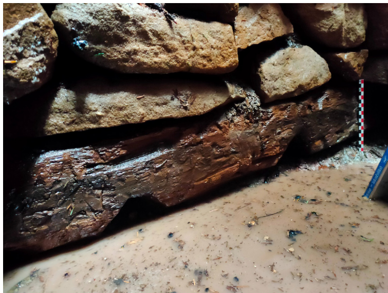
Fig. 45. Vue du puits en cours de vidange depuis son ouverture. Cliché : F. Minot Fig. 46. Vue d'une des faces du radier de fondation. Cliché : F. Minot
