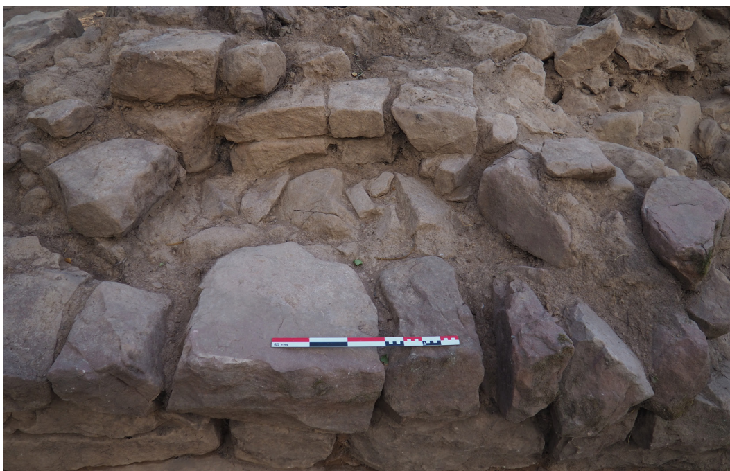
Fig. 31. Vue depuis l'est de la niche NI1031 dans l'épaisseur du mur MR1001 ouest. Cliché : F. Minot
