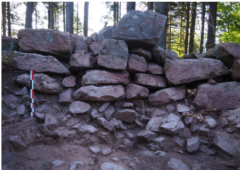
Fig. 40. Le parement interne et la fondation du mur d'enceinte ENC2000 vus depuis l'ouest au niveau du sondage 1. Cliché : F. Minot
