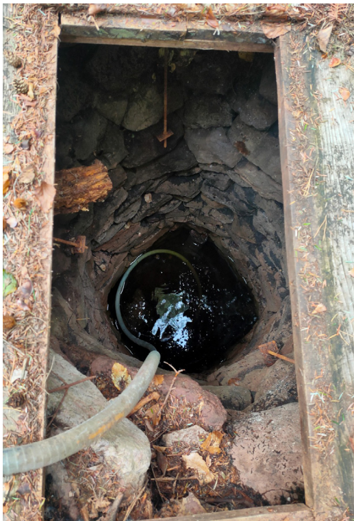
Fig. 45. Vue du puits en cours de vidange depuis son ouverture. Cliché : F. Minot Fig. 46. Vue d'une des faces du radier de fondation. Cliché : F. Minot
