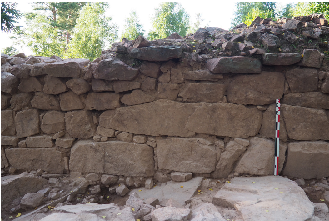
Fig. 30. Vue de détail du mur MR1001 sud depuis le sud et du calage de la première assise. Cliché : F. Minot
