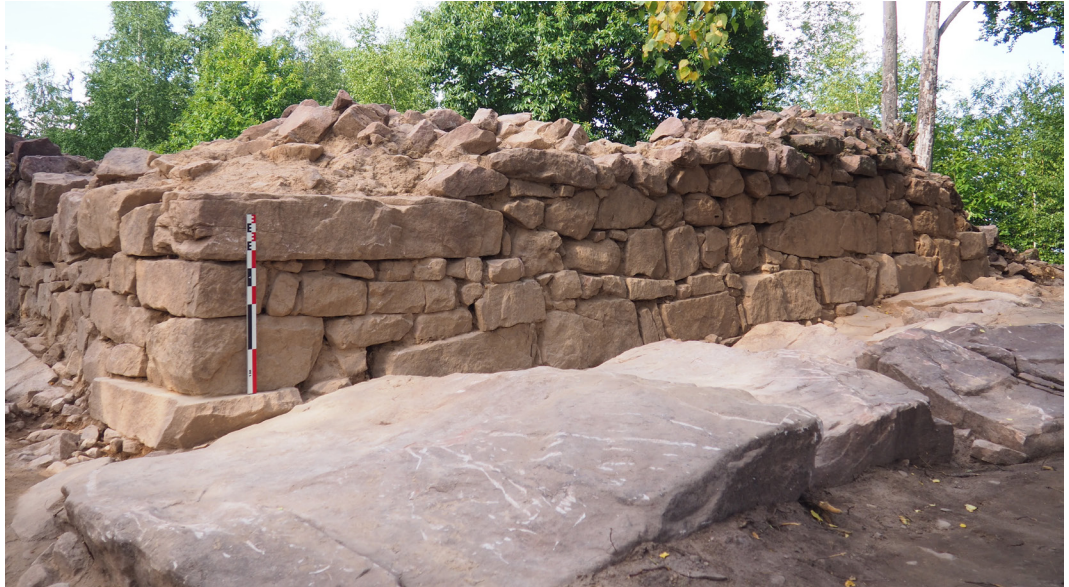
Fig. 29. Vue générale du mur sud du bâtiment BAT1001 depuis le sud-ouest. Cliché : F. Minot
