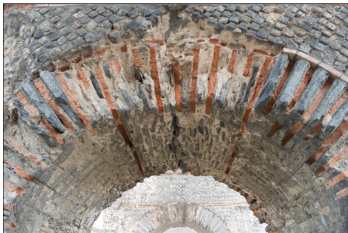
Fig. 5 – Détail de l'arc transversal de la pile 5 du pont de Beaunant sur l'aqueduc du Gier à Sainte-Foy-lès-Lyon. L'érosion de son arc de tête ouest, au premier plan, laisse voir les deux méthodes employées pour lier arcs de tête et arc central (DAO: K. Blanc).
