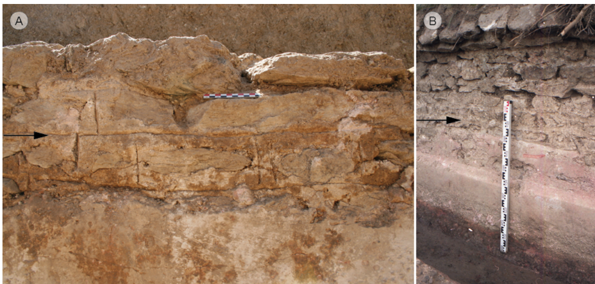
Fig. 4 – Joints tirés au fer sur l'aqueduc de la Brévenne : A , au 51bis impasse du Guéret à Lentilly (Rhône) ; B , aux Thus à Saint-Pierre-la-Palud (Rhône) (cliché A : Coquidé dir. 2014, fig. 17 ; cliché B : base de données Patriarche, DVD Rouger 1995, nega 057).
