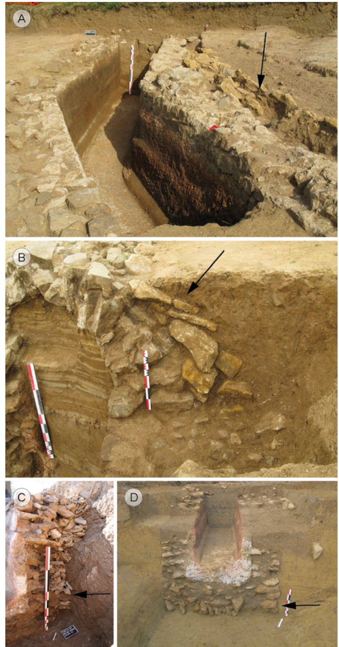
Fig. 5 – Le drain (fig. 2, VIII) de l'aqueduc de la Brèvenne : A et B, visible au Bachely à Dardilly ; C, ajusté à la tranchée d'installation au 51bis impasse du Guéret à Saint-Pierre-la-Palud ; D, absent en terrain plat à la ZAC des Bruyères à Limonest (Métropole de Lyon) (clichés A et B : Motte 2011, fig. 21 ; cliché C : Coquidé dir. 2014, fig. 14 ; cliché D : Monin 2011, pl. 19).
