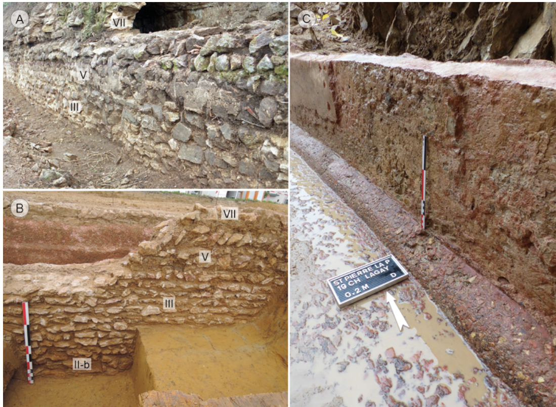
Fig. 11 – Étapes et césures de pose à différents étages de la construction de l’aqueduc de la Brévenne : A , vues externes des maçonneries aux Thus à Saint-Pierre-la-Palud ; B , à la ZAC des Bruyères à Limonest ; C , traces de banchage du cuvelage (fig. 2, IV) au chemin de Lagay à Saint-Pierre-la-Palud (cliché A : base de données Patriarche, DVD Rouger 1995, neg. 006 ; cliché B : SAVL ; cliché C : C. Coquidé, Inrap).
