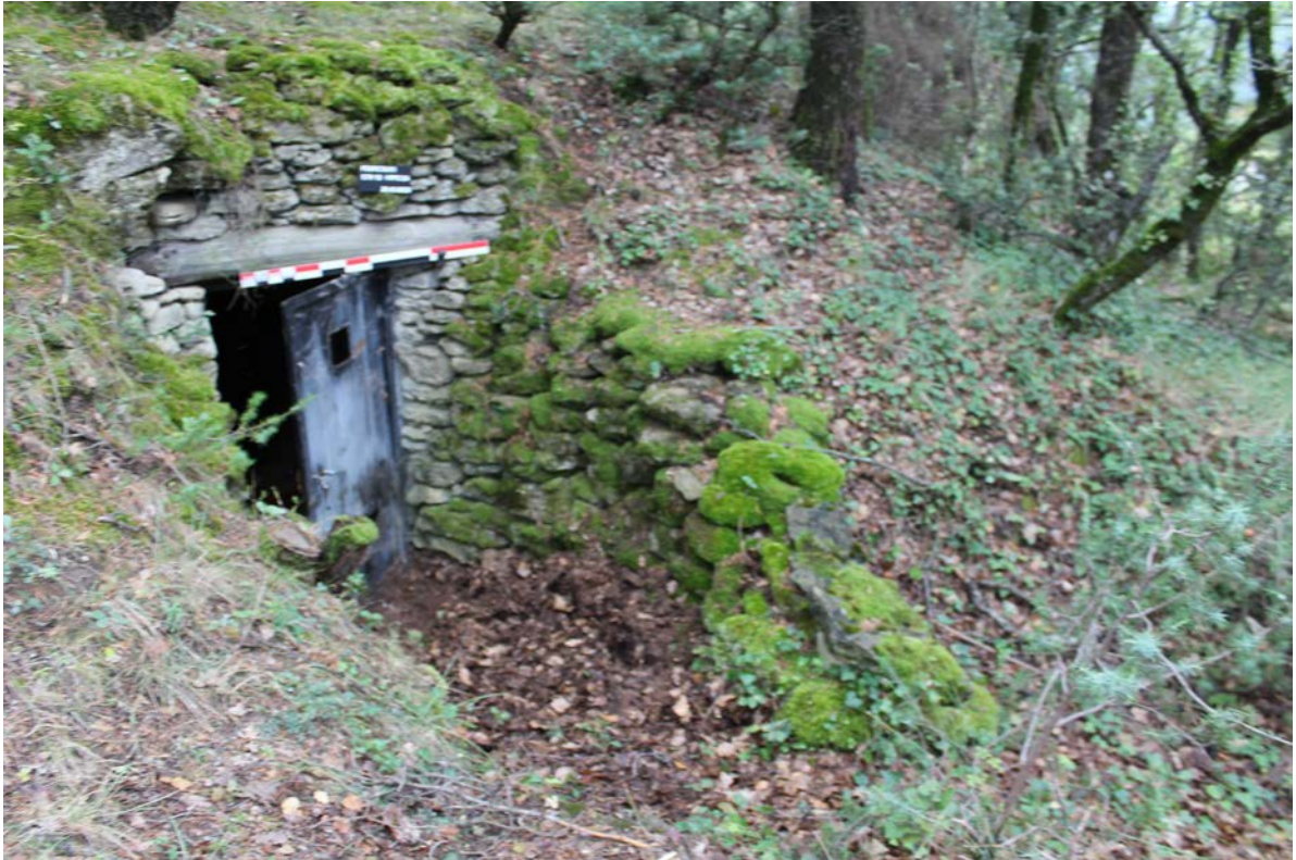
Figure 38 : Entrée de la cavité n°24. Couloir et murs à l'entrée créés par les propriétaires actuels entre 1970 et 1971. Photographie : M.-É. Porqueddu.
