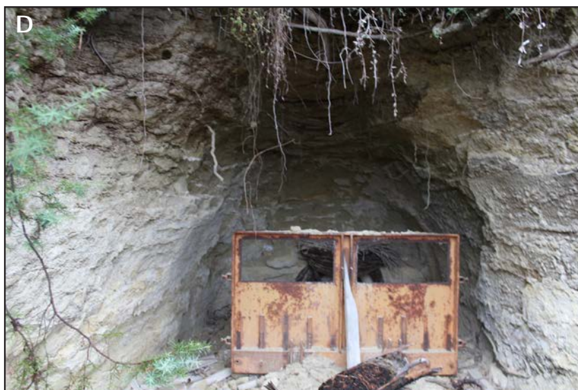
Figure 50 : Cavité n°20 de la Vouronnade. Élaboration : M.-É. Porqueddu et L. Viel.
