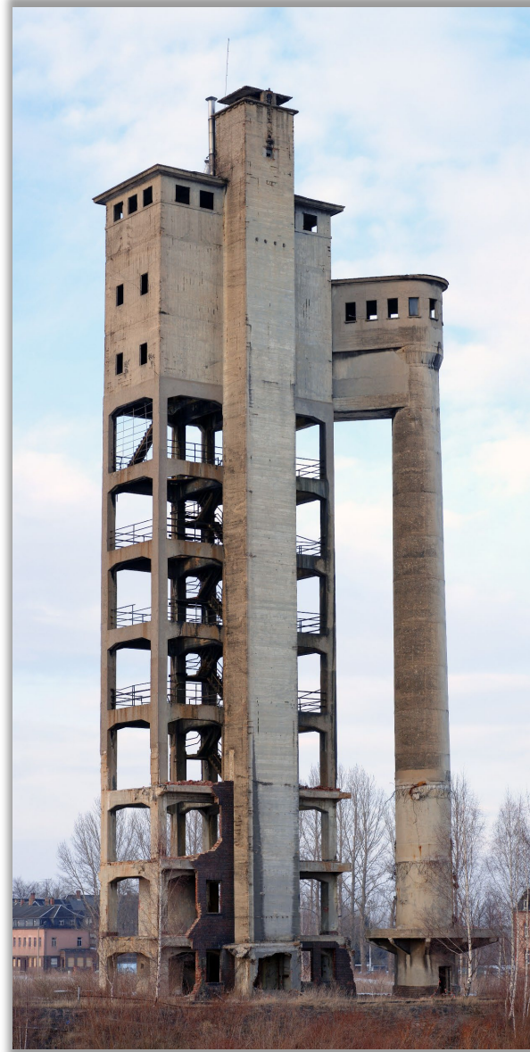
Tour à acide, usine de Crossen, Zwickau, Allemagne (Cl. André Karwath, 2006)
