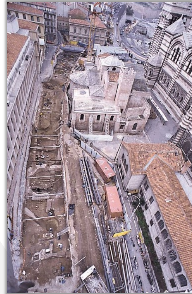
Fouille du Tunnel de la Major (Scherrer et al. , 2011)
