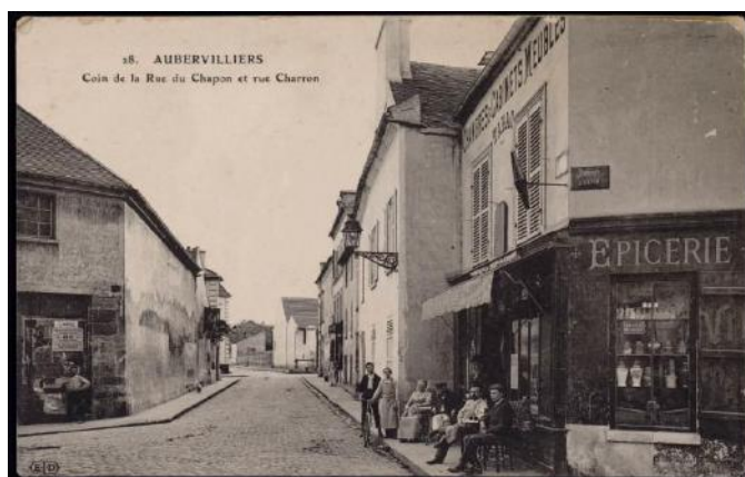
La rue Chapon à Aubervilliers à la fin du XIX e siècle (Archives municipales d'Aubervilliers, 4Fi0343)
