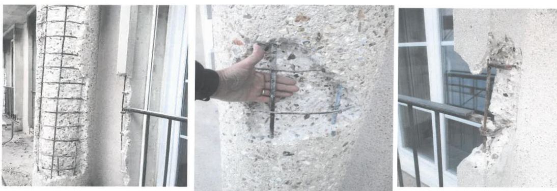
FIGURE 7. Photos des travaux de purge sur poteaux et encadrements saillants des baies vitrées, une spécificité de l'Architecture Perret (Photos PBI)
