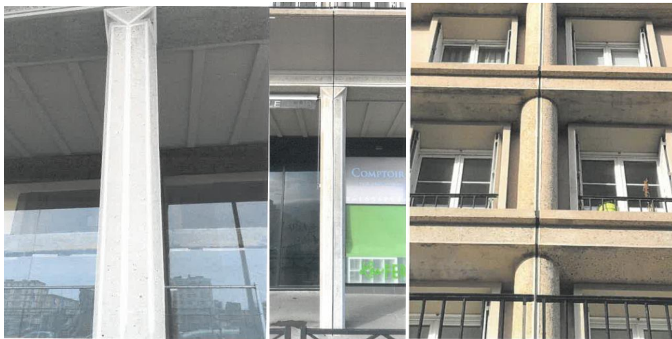
FIGURE 9. Le traitement des poteaux intermédiaires et des poteaux avec joints de dilatation (Photos PBI)
