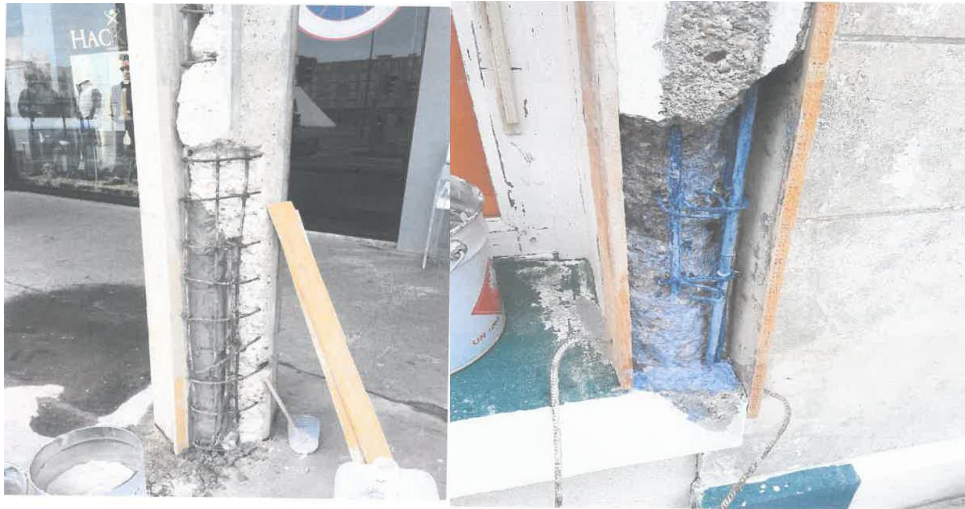
FIGURE 8. Traitement des armatures par passivation sur poteaux et encadrements (Photos PBI)
