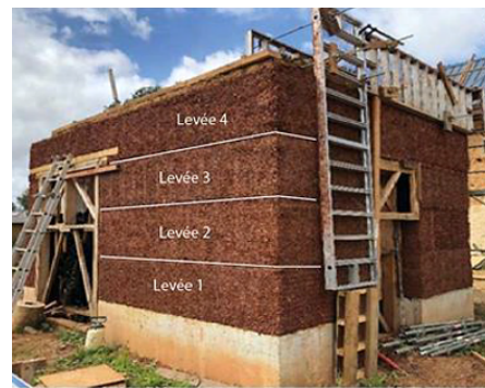
FIGURE 6. Bâtiment prototype en construction (Azil, 2022)
