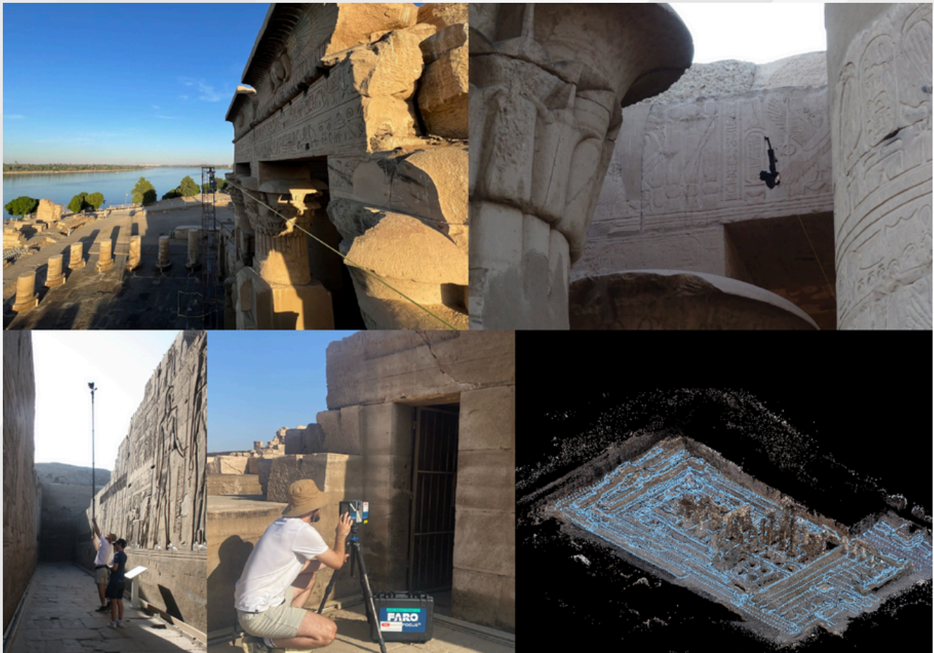
Fig. 3 : Relevé photographique avec tyrolienne et perche, laser scanner et étape d'alignement des clichés sur Metashape (©Uzuffy et A. Terrier )
