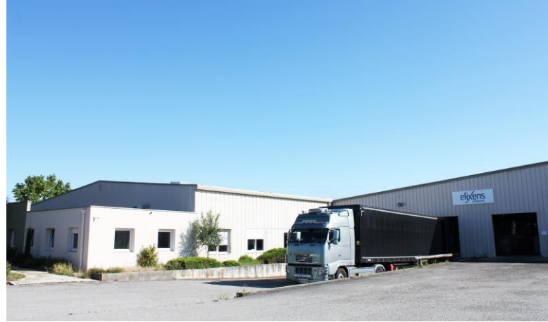
↑ Bâtiments d'Elixens France implantés en bas de vallée (Eurre) © Photo : Elixens France
