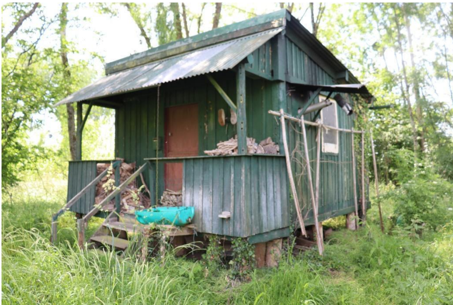
Fig. 53 : construction en bois sur pilotis à proximité des rives de l'Indre, utilisée à nos jours comme cabane de pêche.
