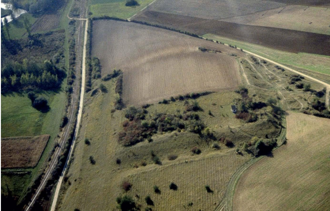
Fig. 7 – On distingue nettement les limites du camp. Au premier plan, le côté Est avec le rempart précédé d'un large fossé qui barre l'éperon. Au fond, face ouest, la trace blanche du rempart arasé. Le rempart nord (à droite) et le talus abrupt qui domine la voie ferrée côté sud (à gauche) sont bien visibles. En haut, à gauche, on voit le cours de l'Indre. Cliché Jean Holmgren pris en 1988.
