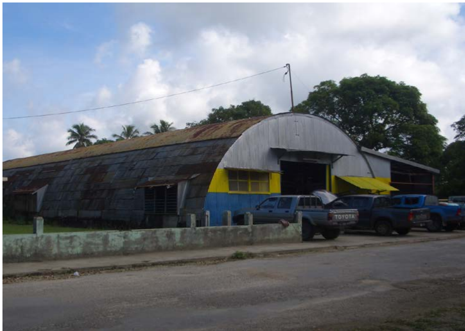
Illustration 26. – Un vestige de la base américaine à Santo qui a survécu jusqu'à nos jours et qui, avec quelques modifications, servait encore d'entrepôt et d'atelier de mécanique en 2012
