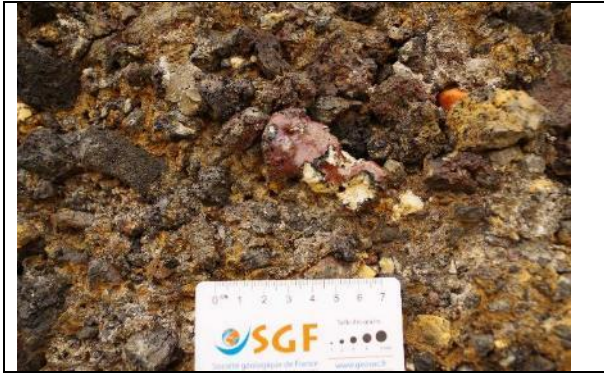
Figure 10. Mur historique dans le quartier des fonderies de Brioude, réalisé en scories, et détail des éléments qu'il contient. © V. Thiéry, avril 2022.
