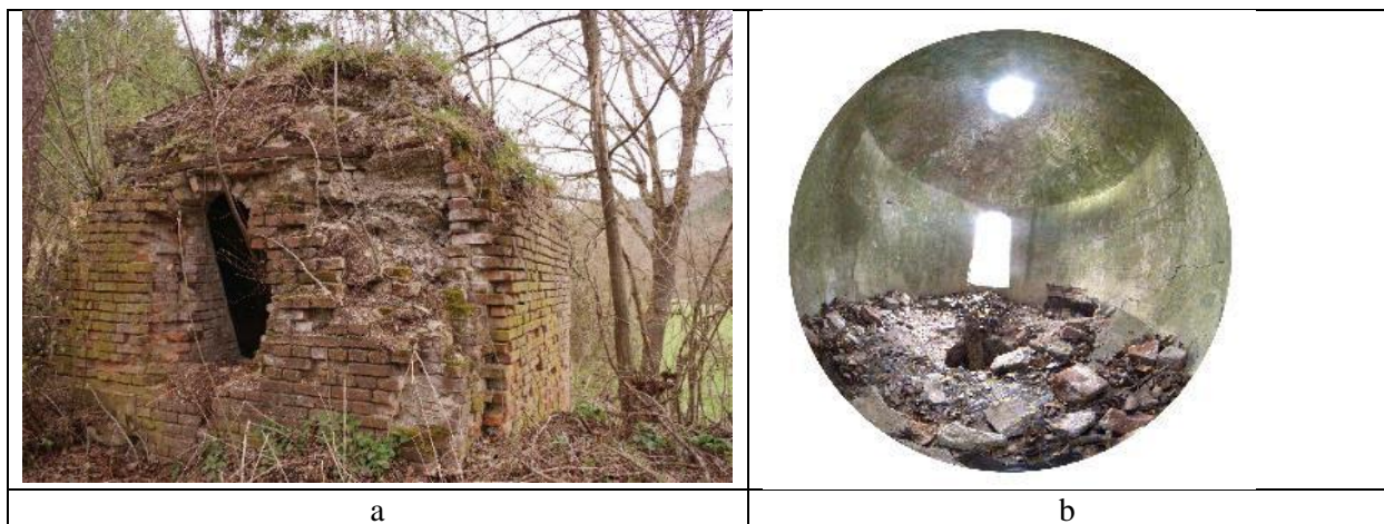
Figure 13 a : le four de Terret. © V. Thiéry, avril 2022. b : intérieur du four de Terret. © V. Thiéry, avril 2022.
