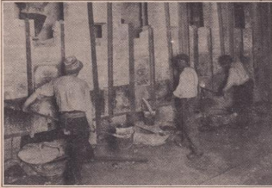
La coulée du métal.
