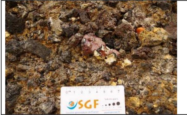
Figure 10. Mur historique dans le quartier des fonderies de Brioude, réalisé en scories, et détail des éléments qu'il contient.
