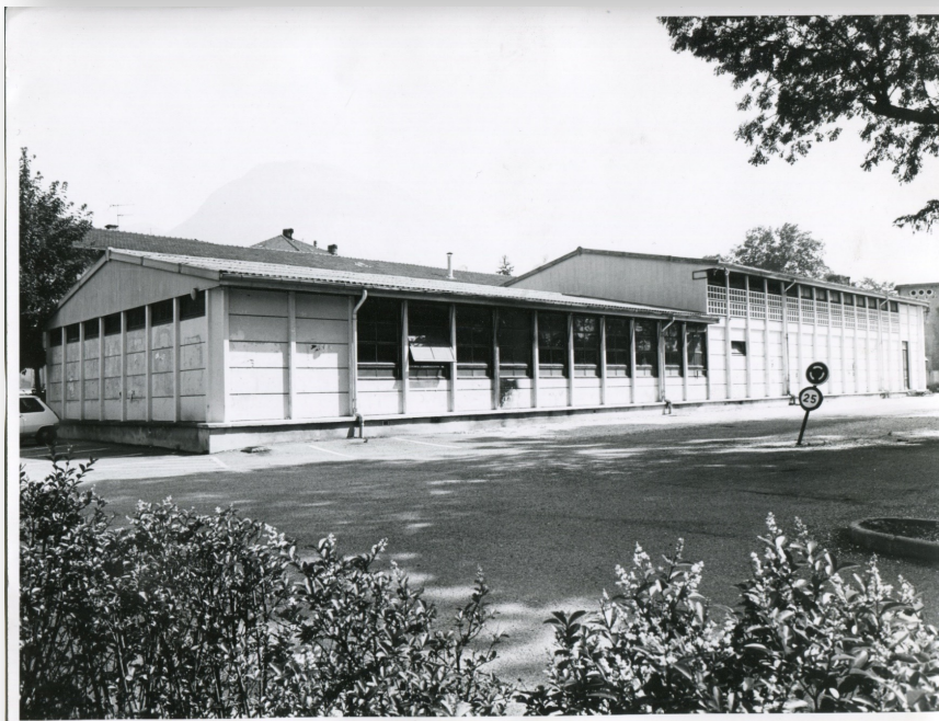
Amphithéâtre Préfabriqué et bureaux de la Direction de la Faculté de Pharmacie (détruit en 1999)
