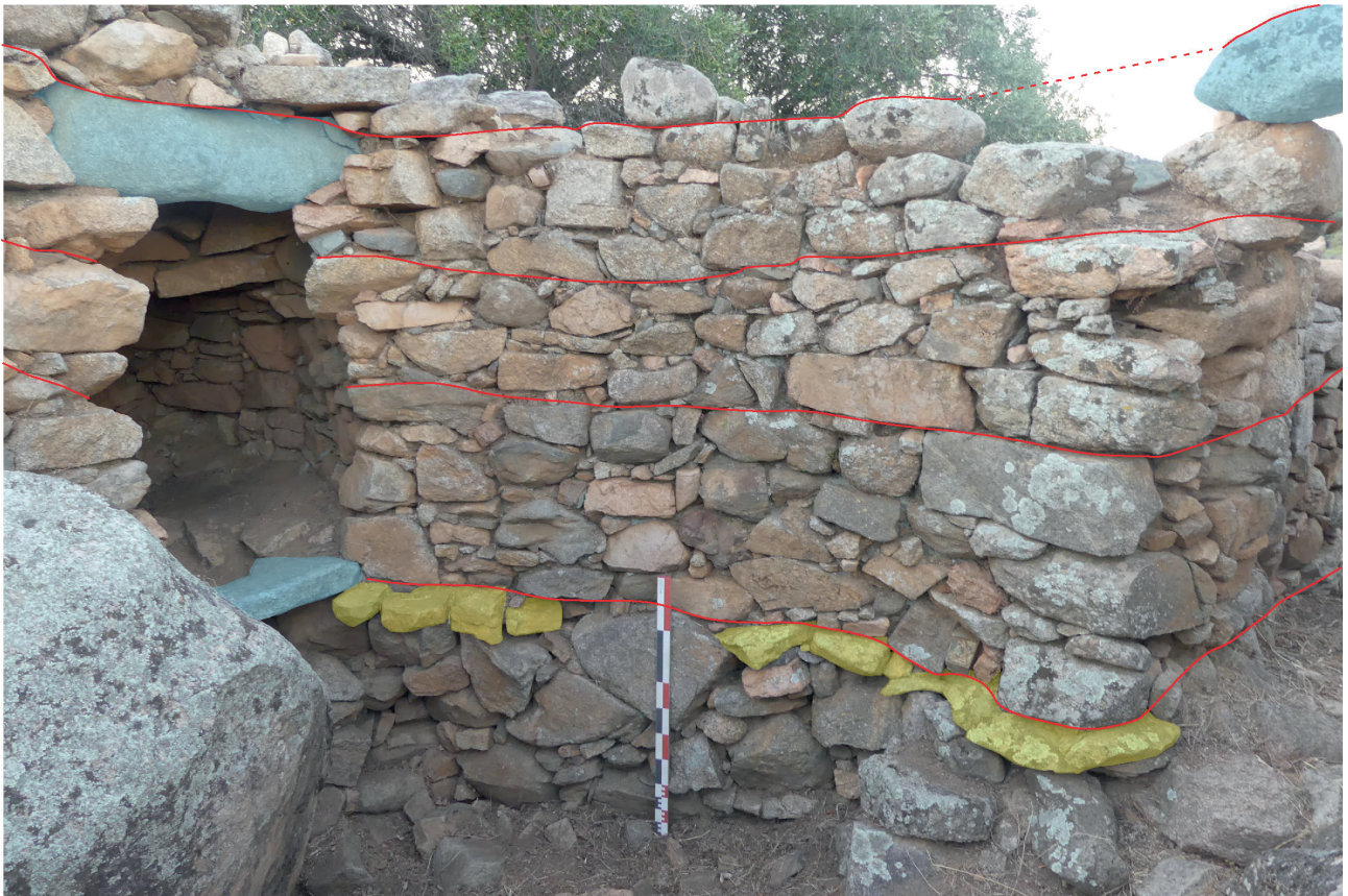
Fig. 13 – Tappa, début du Bronze moyen. Parement interne de la torra sud (DAO K. Peche-Quilichini) : niveau de console (jaune) ; assises de réglage (rouge) ; seuils et linteaux (bleu).
