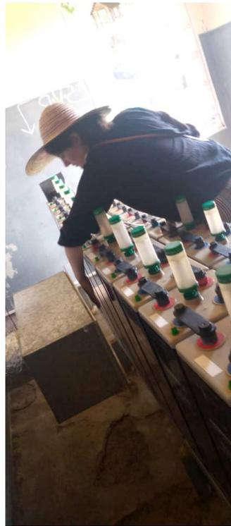
Figure 3. Le local des batteries doit être suffisamment ventilé car une chaleur excessive peut dégrader les batteries (2021, Sénégal).
