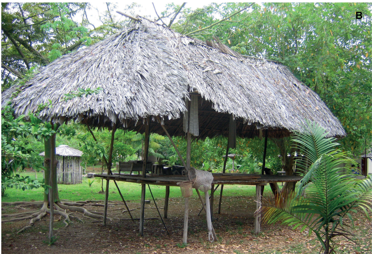
Fig. 10 – Les maisons traditionnelles amérindiennes diffèrent notablement selon les ethnies : carbet de plain-pied à toit en double pente, caractéristique des Kali'na de la côte occidentale de Guyane (A) ; habitation typique sur pilotis, très adaptée aux savanes inondables du littoral sud-est que les Palikur occupent (B ; clichés S. Rostain).
