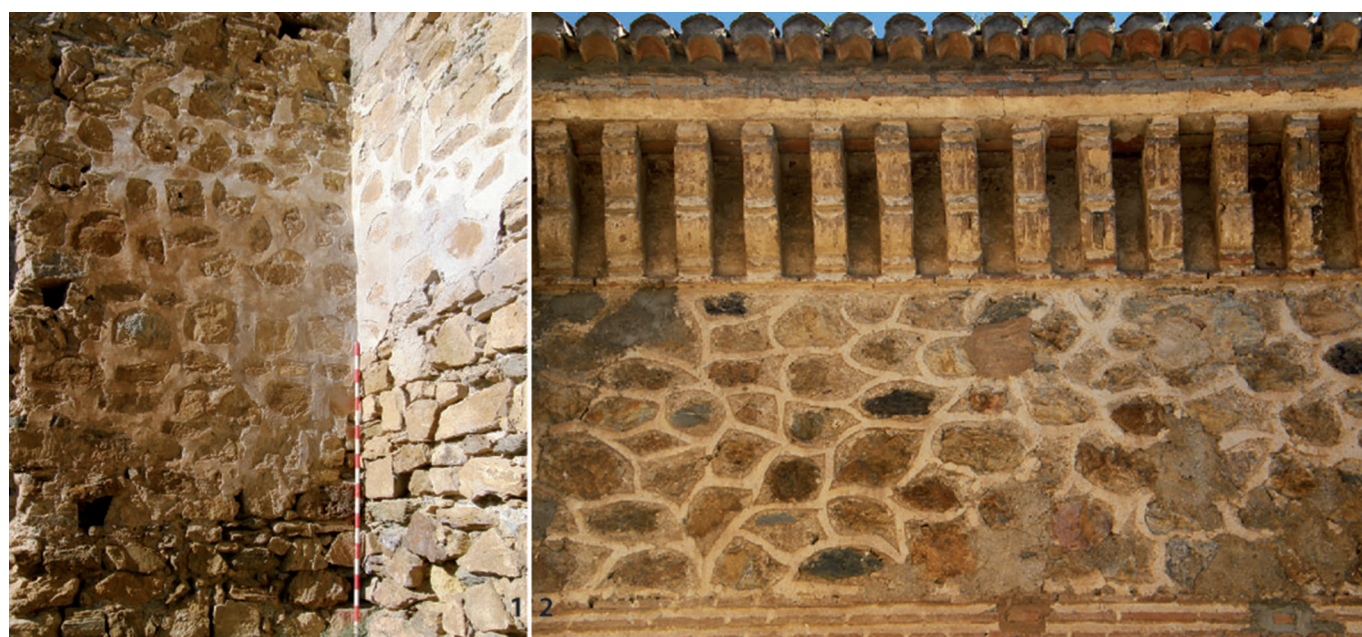
Fig. 9: Mampostería. Acabados exteriores con esgrafiados decorativos: 1 – Iniza. 2 – Yátor.
