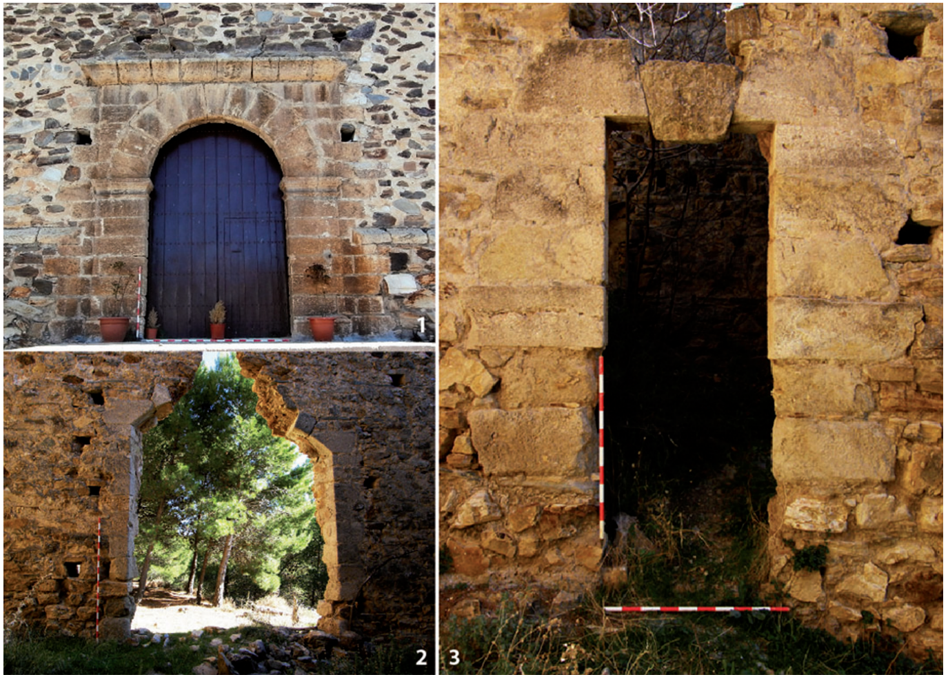
Fig. 12: Sillería. Portadas: 1 – Portada lateral de Bayárcal. 2 – Portada de Iniza, en arco escarzano. 3 – Puerta adintelada en Iniza.
