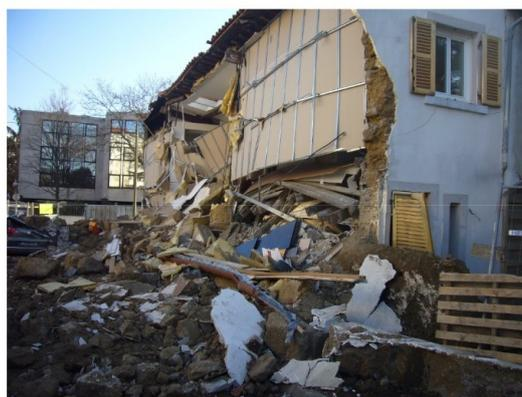
**FIGURE 3.** Effondrement structurel dû à une rénovation inappropriée [Indekeu, 2023]
