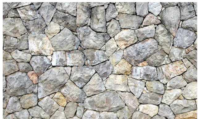
Fig. 47 : Appareil polygonal irrégulier à joints vifs
