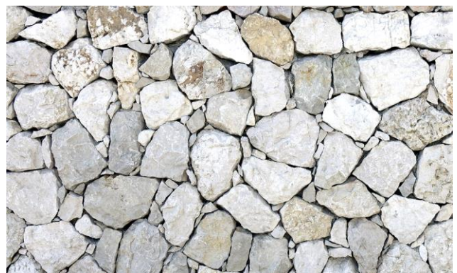
Fig. 49 : Appareil polygonal irrégulier calé à joints vifs
