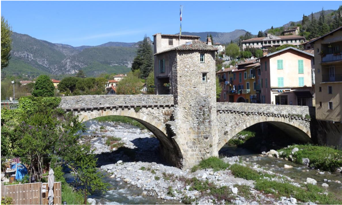
Fig. 24 : Sospel - Pont Vieux : pont fortifié à deux arches ; une tour est bâtie sur la large pile
