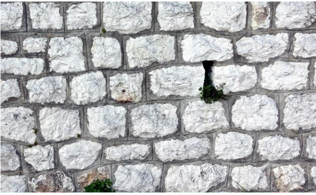
Fig. 34 : Appareil assisé à joints pleins moulurés
