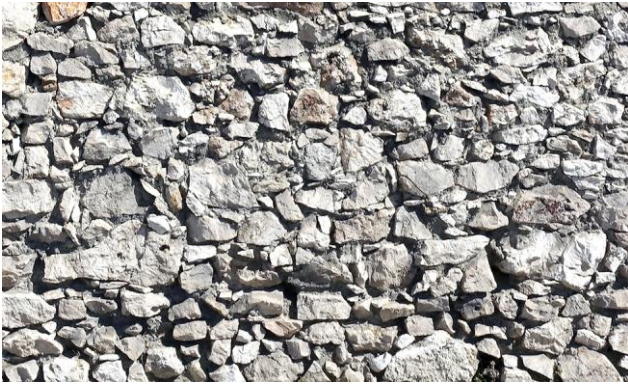
Fig. 26 : Appareil irrégulier à joints vifs
