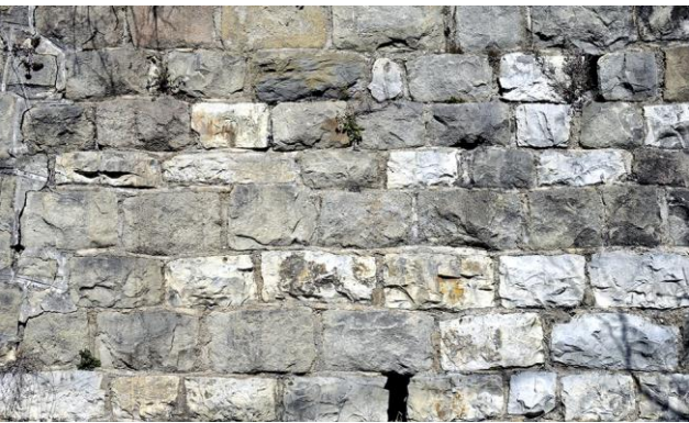
Fig. 36 : Appareil réglé, assises irrégulières, joints minces
