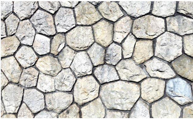
Fig. 42 : Appareil polygonal à joints creux
