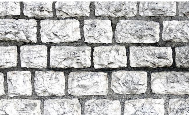
Fig. 38 : Appareil réglé, assises régulières, joints creux
