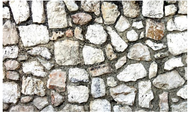
Fig. 27 : Appareil irrégulier à joints pleins
