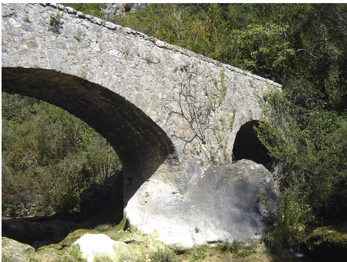
Fig. 17 : Saint-Cézaire - Pont du Moulin : pile solidement ancrée sur un bloc rocheux faisant office de bec de protection
