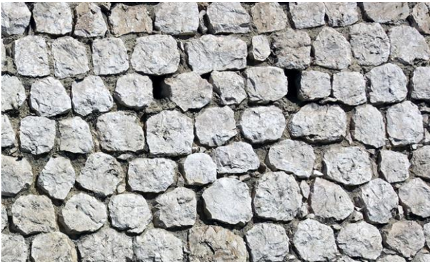
Fig. 28 : Appareil régulier à joints creux
