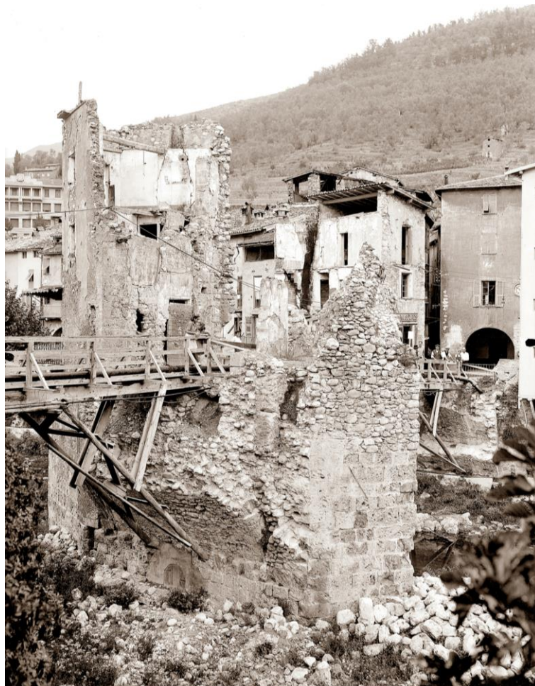
Fig. 25 : Sospel - Pont Vieux : après le minage de 1944 ; base de la tour en tuf, surélevée avec des galets (Photo : Département de la photographie, Ministère de la Culture, Médiathèque de l'Architecture et du Patrimoine, Diffusion RMN-GP, Réunion des Musées Nationaux-Grand Palais)
