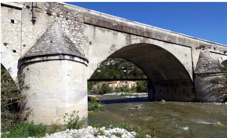
Fig. 19 : Drap - Pont de Peille : la largeur du Paillon a imposé quatre piles en tiers point protégées par des avant et arrière-becs ; deux demi-piles protégées de la même façon sont bâties aux extrémités, contre les culées
