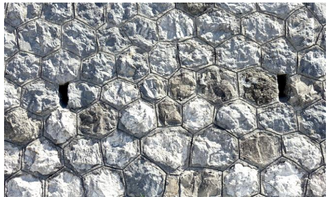
Fig. 45 : Appareil polygonal faux à joints moulurés
