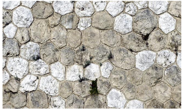
Fig. 43 : Appareil polygonal à joints brossés
