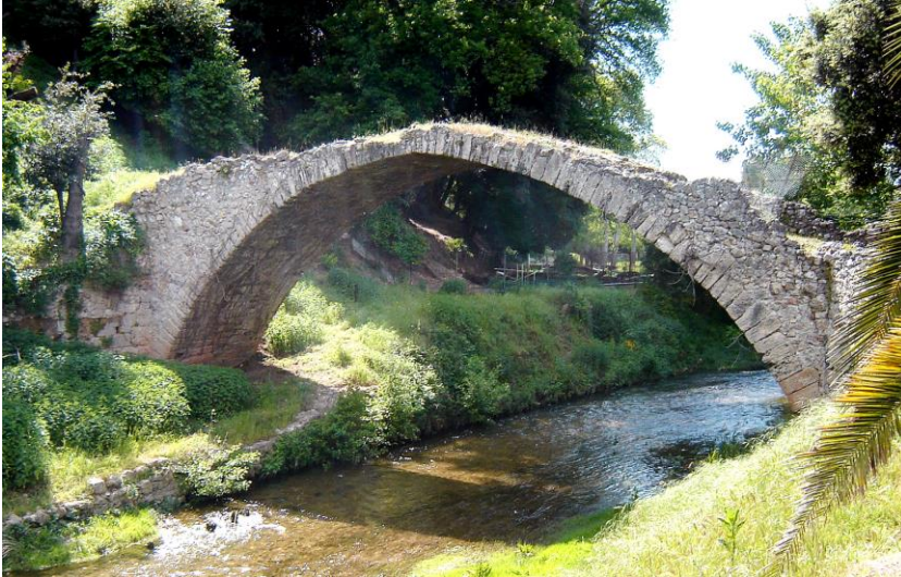
Fig. 21 : Antibes - Pont du Moulin du Roy ou pont du Bourguet, sur la Brague (c XVIIe s.)
