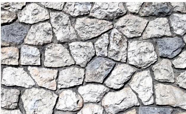
Fig. 46 : Appareil polygonal irrégulier à joints creux
