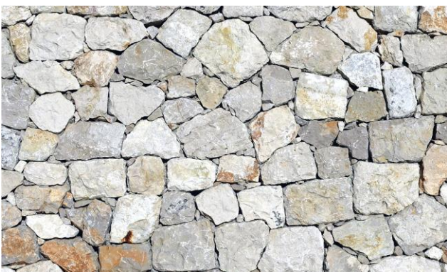
Fig. 32 : Appareil désordonné à joints vifs
