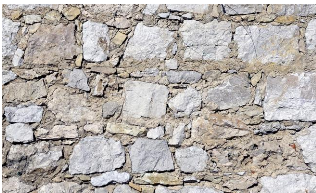
Fig. 48 : Appareil assisé calé à joints pleins
