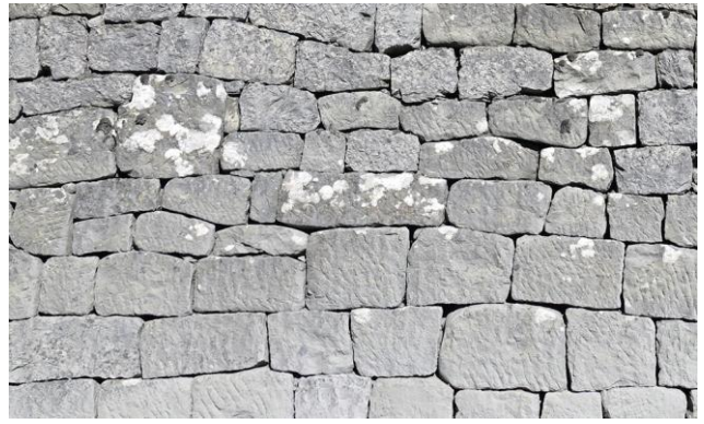
Fig. 35 : Appareil assisé à joints vifs
