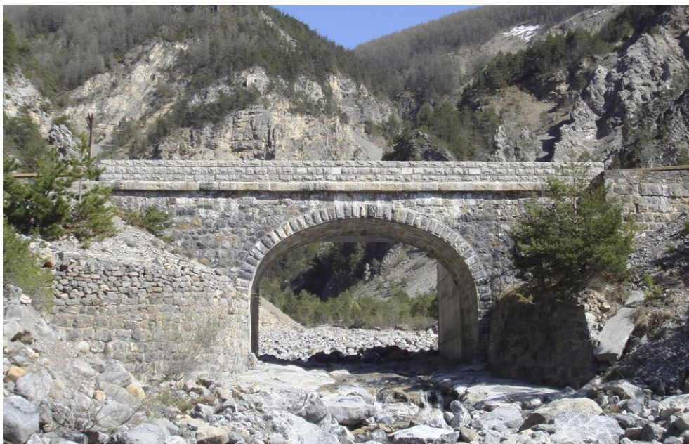
Fig. 4 : Péone - Pont de l'Eau Blanche : tablier horizontal
