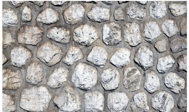
Fig. 29 : Appareil régulier à joints pleins brossés
