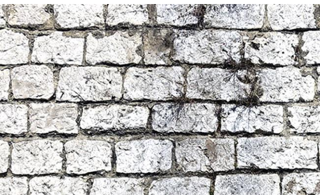
Fig. 40 : Appareil en demi-moellons à joints creux minces
