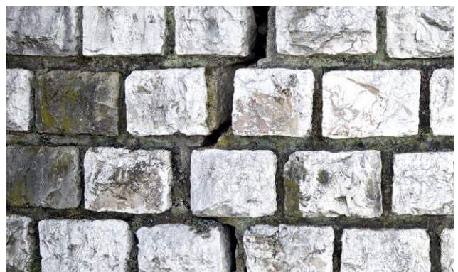
Fig. 41 : Appareil en demi-moellons à joints creux larges
