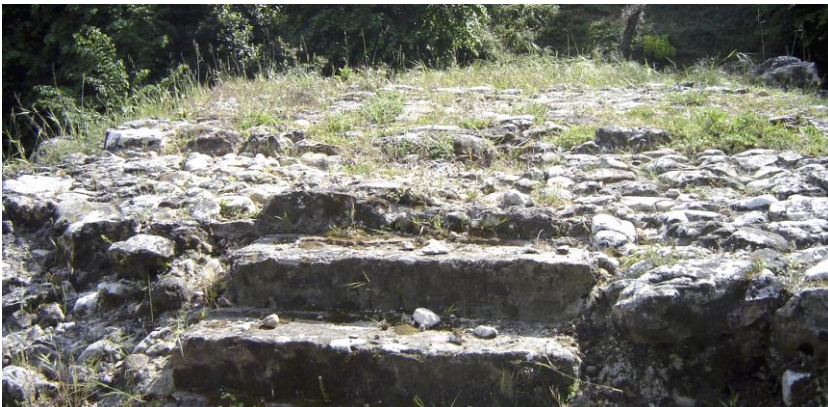
Fig. 23 : Antibes - Pont du Moulin du Roy : le tablier, escalier d'accès et pavage
