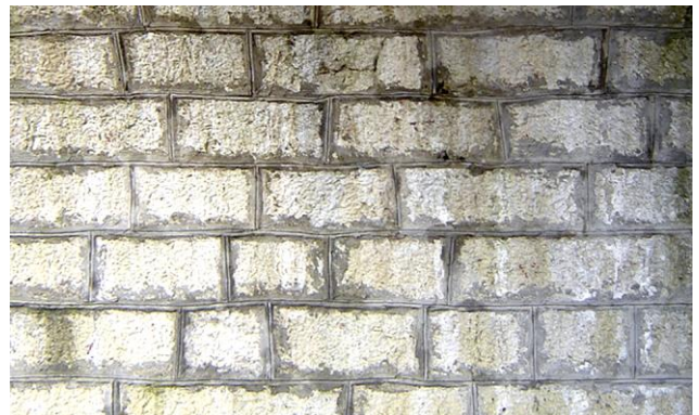
Fig. 39 : Appareil réglé, assises régulières, joints concaves
