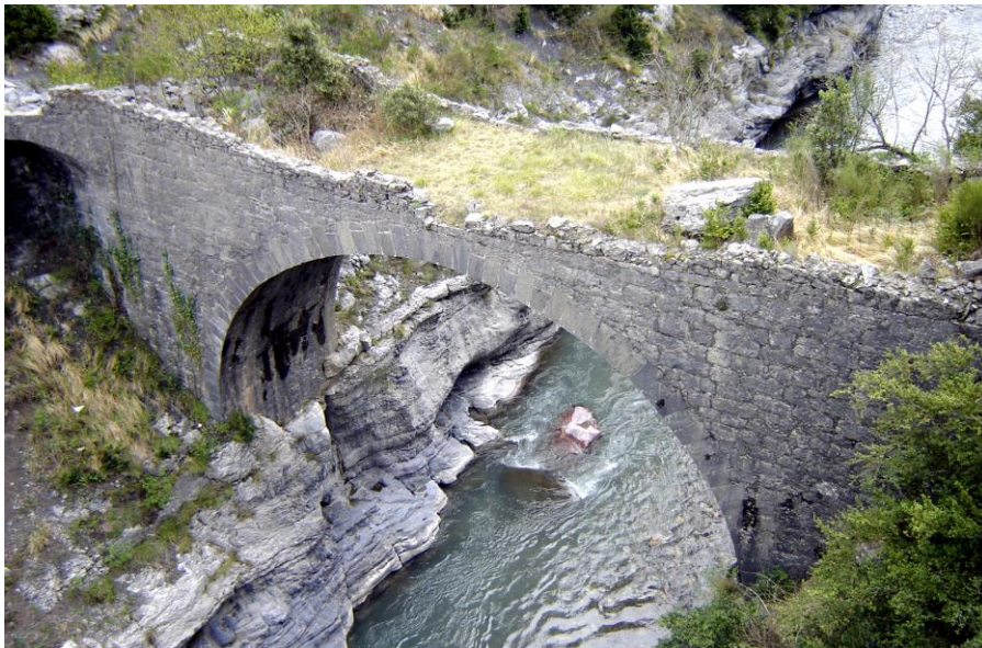
Fig. 1 : Valdeblore - Pont ancien de Chabriera (avant restauration) : arches ancrées sur le substrat rocheux
