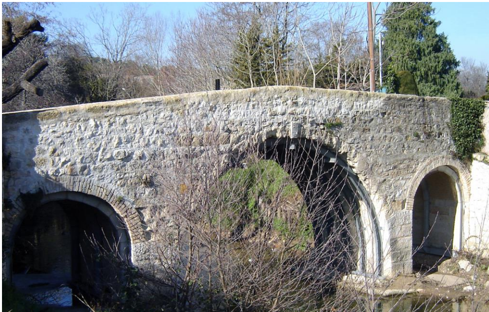
Fig. 3 : Antibes - Pont de la Bastide du Roy : pont à dos d'âne à trois arches
