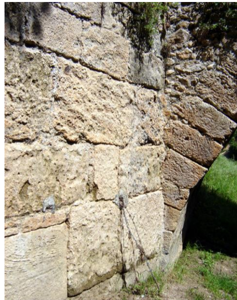
Fig. 22 : Antibes - Pont du Moulin du Roy : détail de la construction en blocs de tuf calcaire
