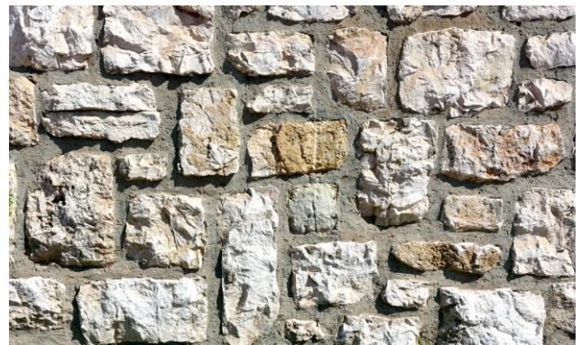
Fig. 31 : Appareil orthogonal à joints larges brossés
