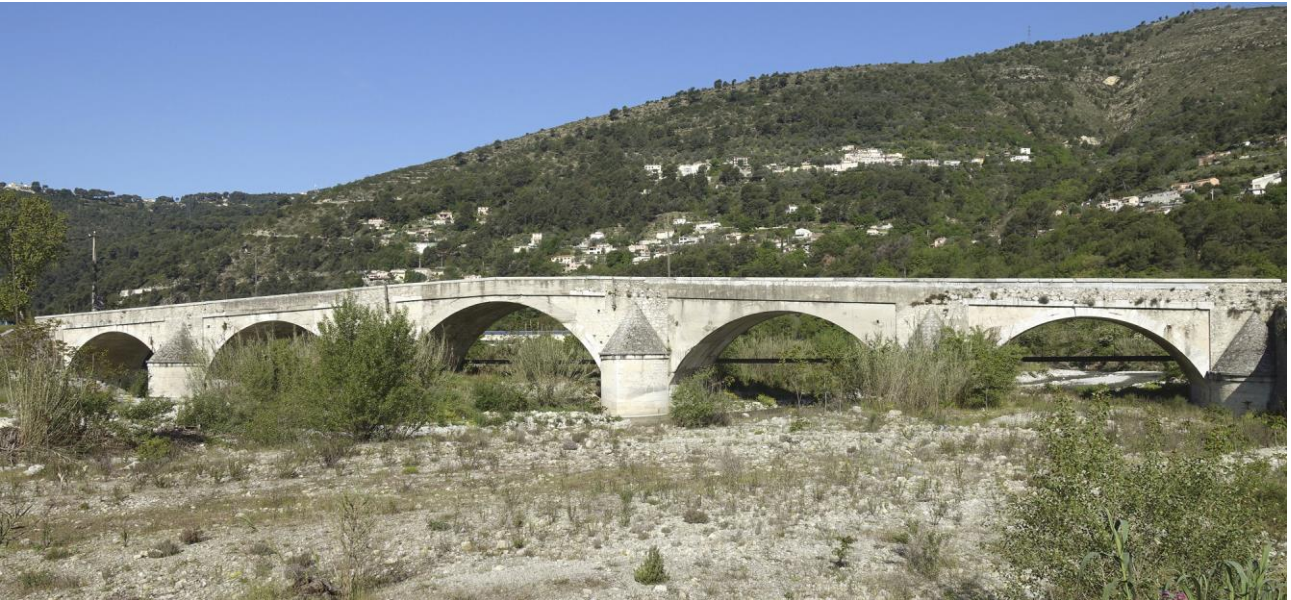
Fig. 19 : Drap - Pont de Peille : la largeur du Paillon a imposé quatre piles en tiers point protégées par des avant et arrière-becs ; deux demi-piles protégées de la même façon sont bâties aux extrémités, contre les culées
