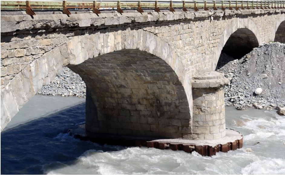
Fig. 18 : Puget-Théniers - Pont de la Trinité : piles avec avant et arrière-becs sur radiers de fondation (ici, arrière-bec)
