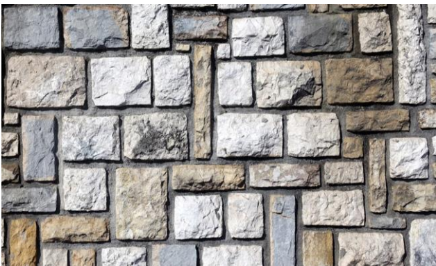
Fig. 30 : Appareil orthogonal à joints minces creux
