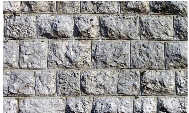
Fig. 37 : Appareil réglé, assises irrégulières, joints concaves
