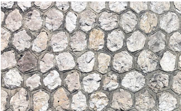
Fig. 44 : Appareil polygonal faux à joints moulurés
