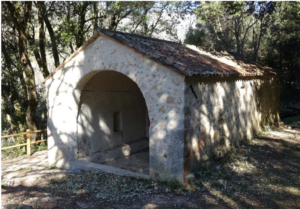
Fig. 16 : Vue d'ensemble de la chapelle
