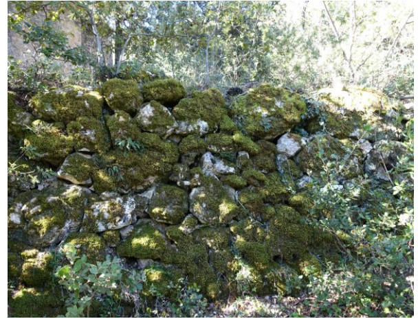
Fig. 29 : Mur de terrasse
