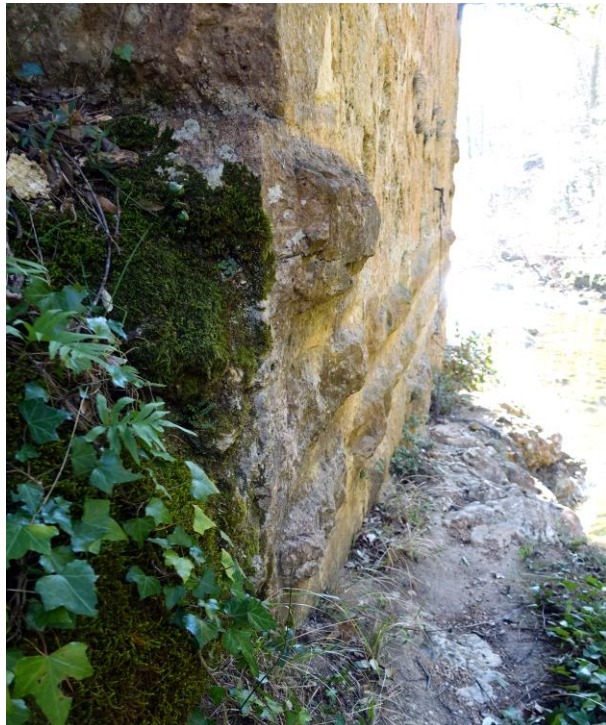
Fig. 4 : Base d'une pile avec pierres à bossage
