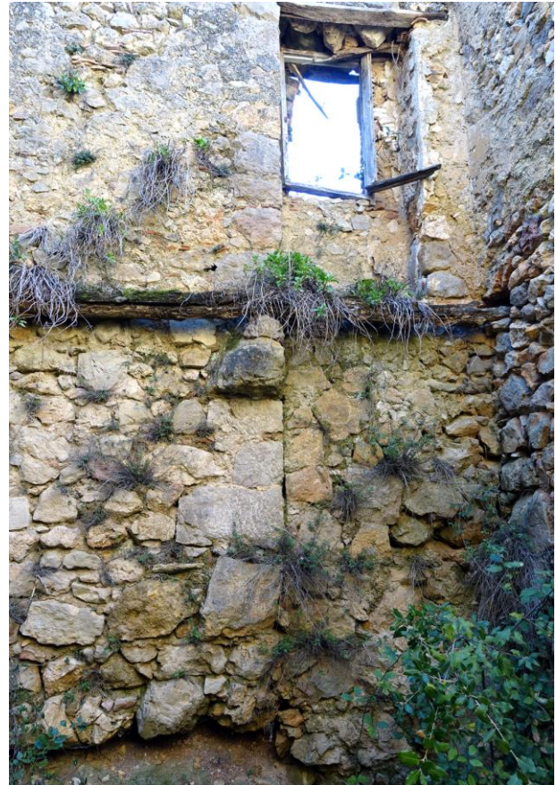
Fig. 22 : Angle intérieur avec blocs taillés
