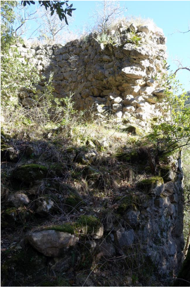
Fig. 9 : Vue d'ensemble de la tour
