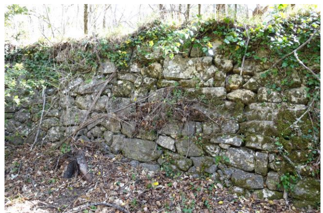
Fig. 40 : Mur de terrasse
