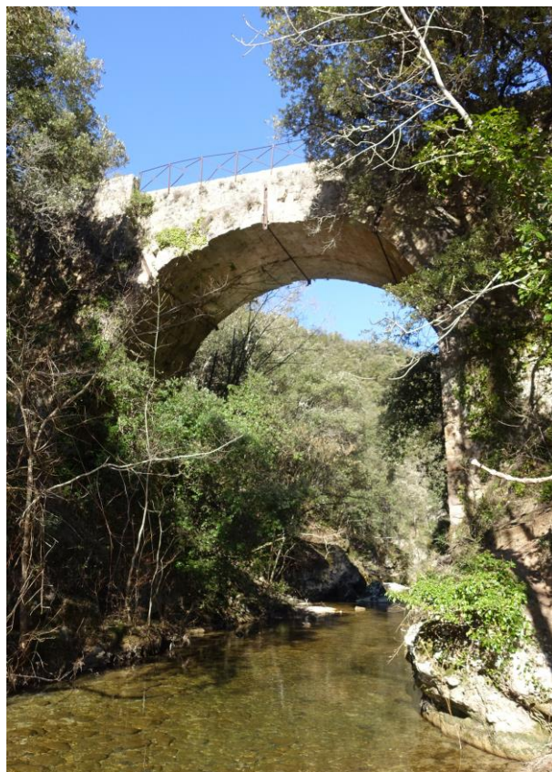
Fig. 2 : Vue d'ensemble du Vieux Pont
