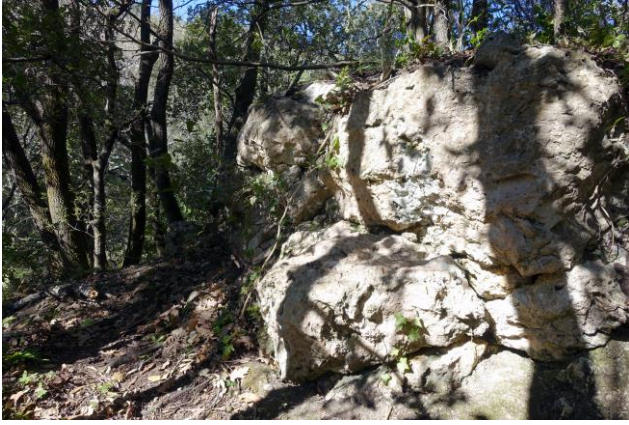
Fig. 12 : Mur périphérique en gros blocs
