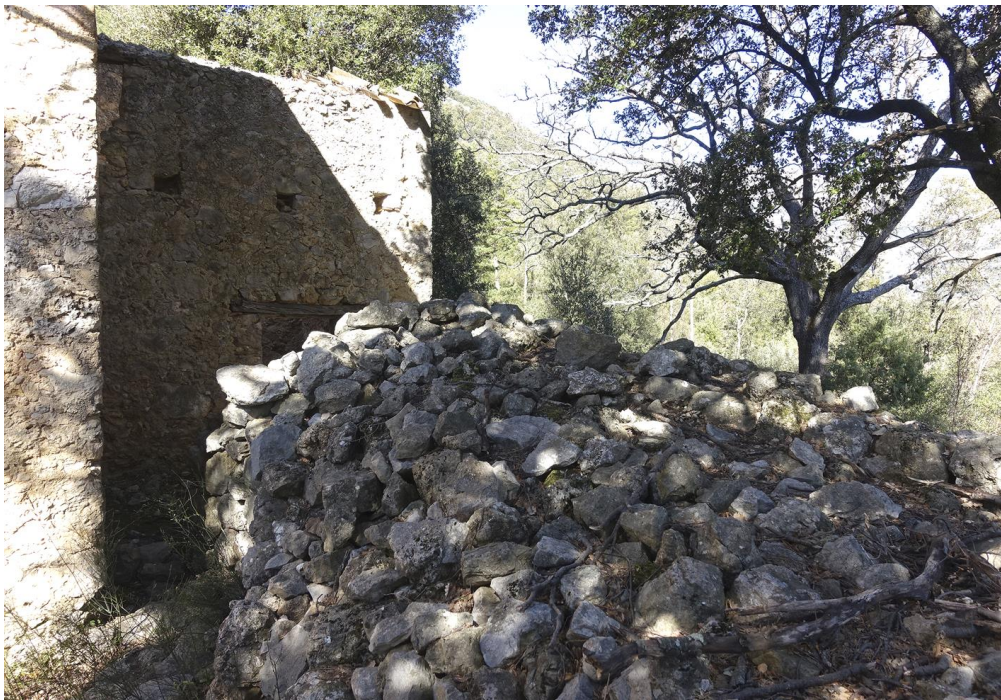
Fig. 30 : Accumulation de blocs « anciens » ; au second plan, le petit corps de bâtiment « ancien »
