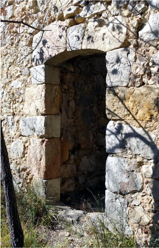
Fig. 28 : Porte à encadrement
