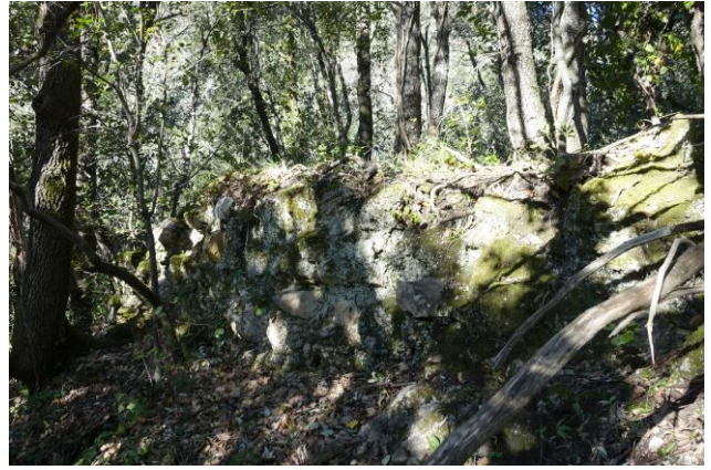
Fig. 13 : Mur périphérique en blocs moyens
