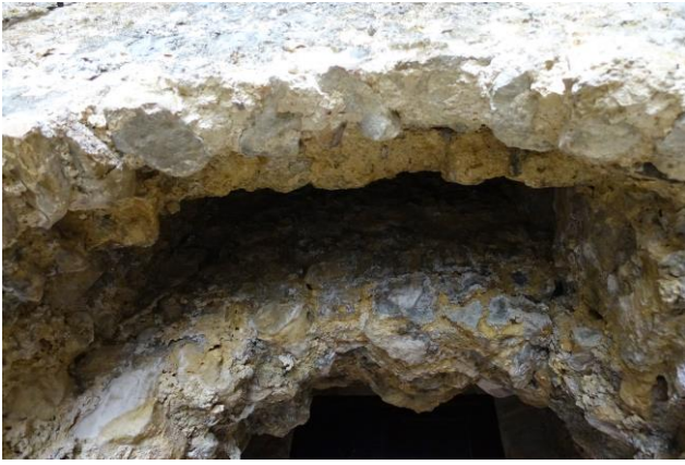
Fig. 77 : Le mur double (détail)
