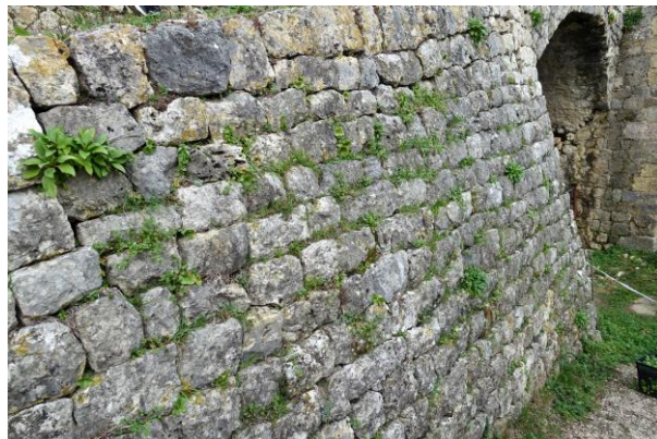
Fig. 58 : Mur intérieur avec fruit
