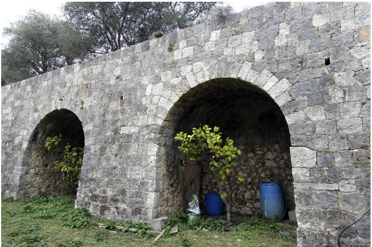
Fig. 37 : Partie restaurée au XVIIIe s. (quatrième type de bâti)
