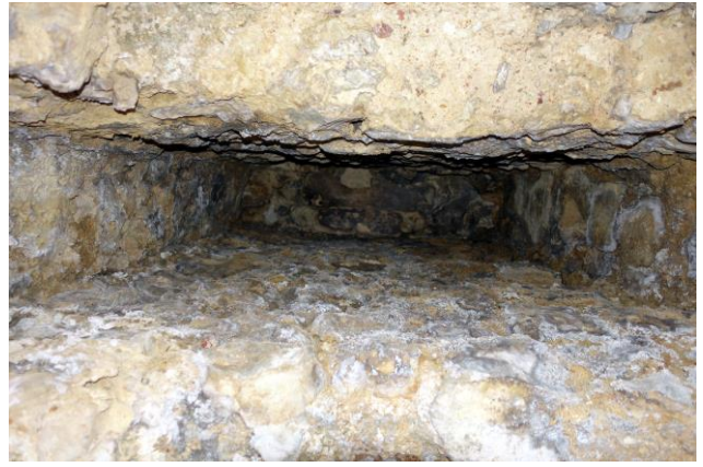
Fig. 78 : Le mur double (détail)
