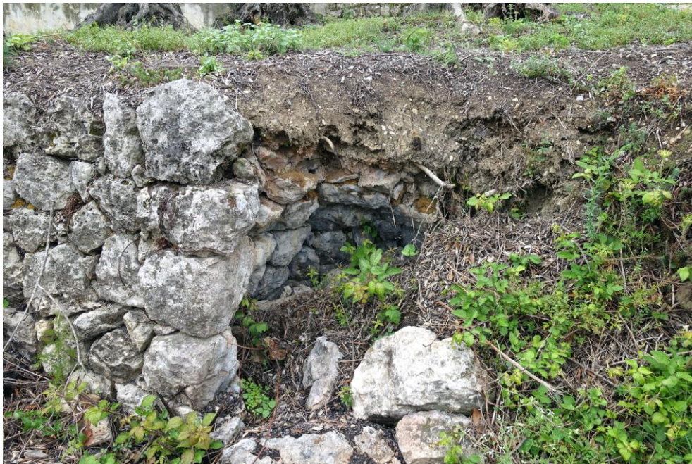
Fig. 32 : Vestiges d'une niche aménagée dans un mur de terrasse
