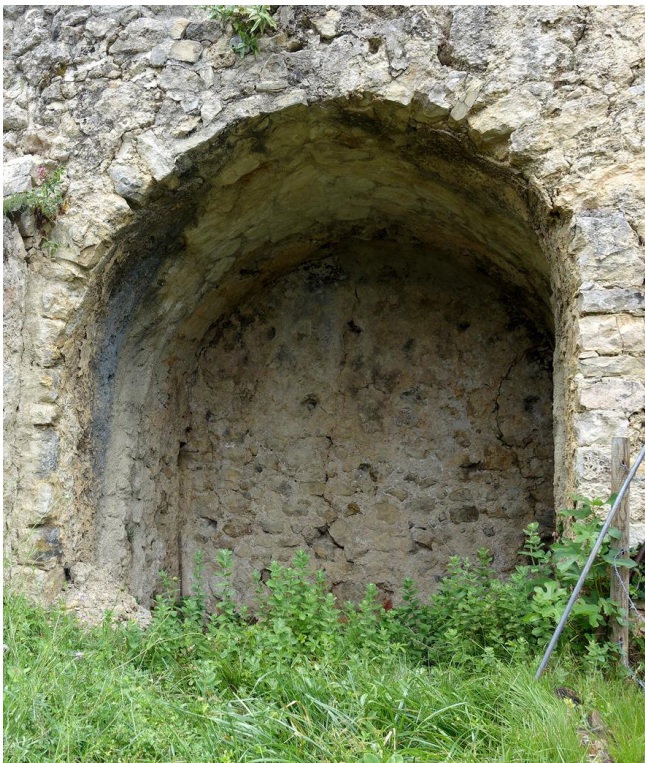
Fig. 41 : Alcôve 9 (façade restaurée)
