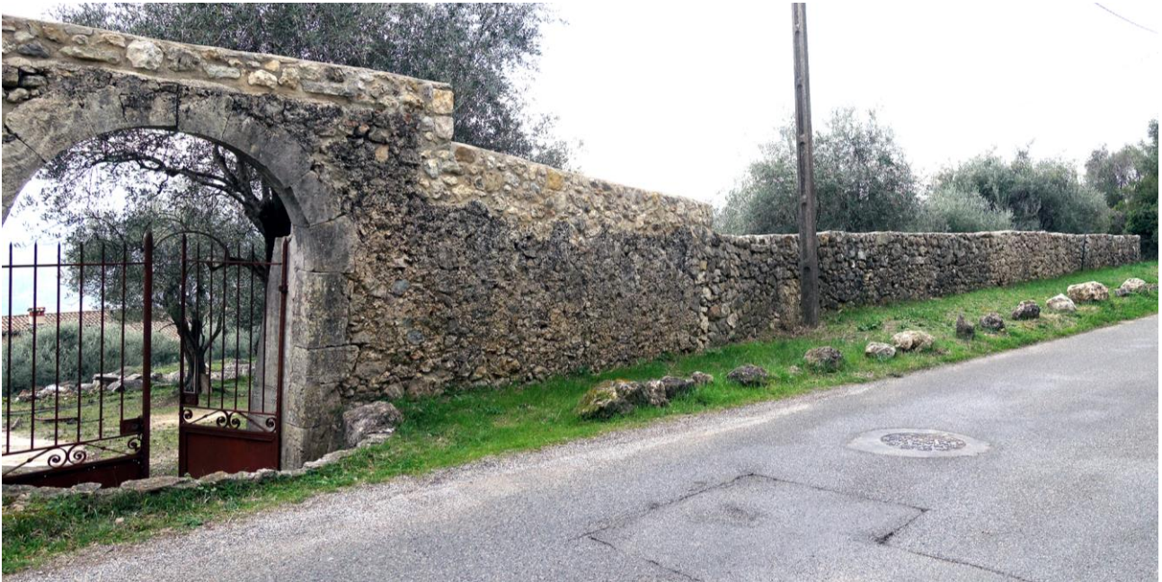
Fig. 27 : Porte et mur nord
