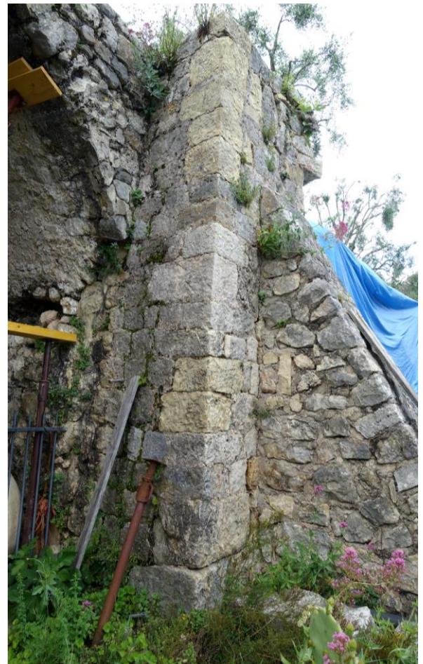
Fig. 63 : Entrée côté est
