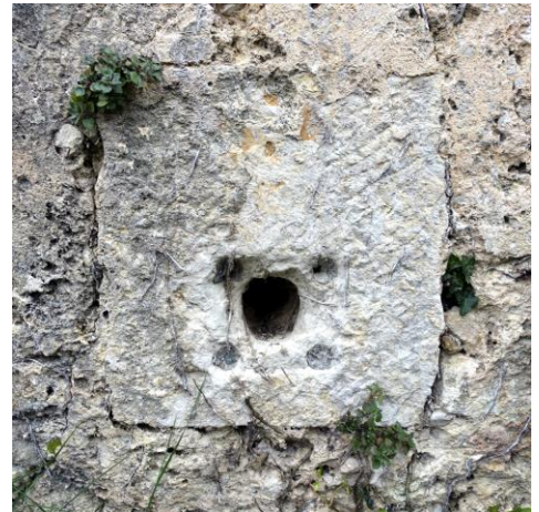
Fig. 50 : Vestige de la sortie d'eau
