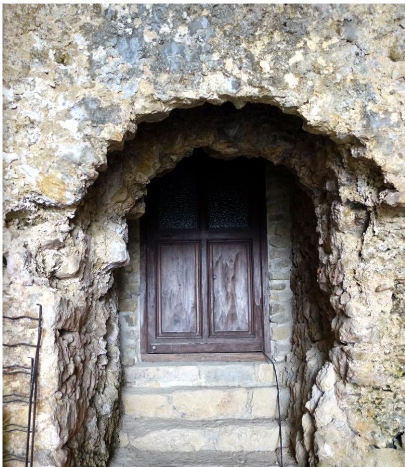
Fig. 75 : Petit couloir (vue d'ensemble)
