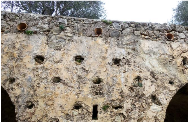
Fig. 43 : Surélévation orientale du Grand Mur avec addition des bouches d'écoulement
