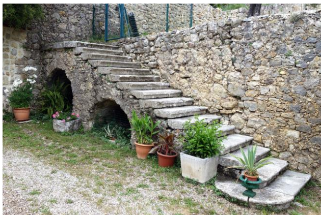
Fig. 17 : L'escalier droit (ensemble)
