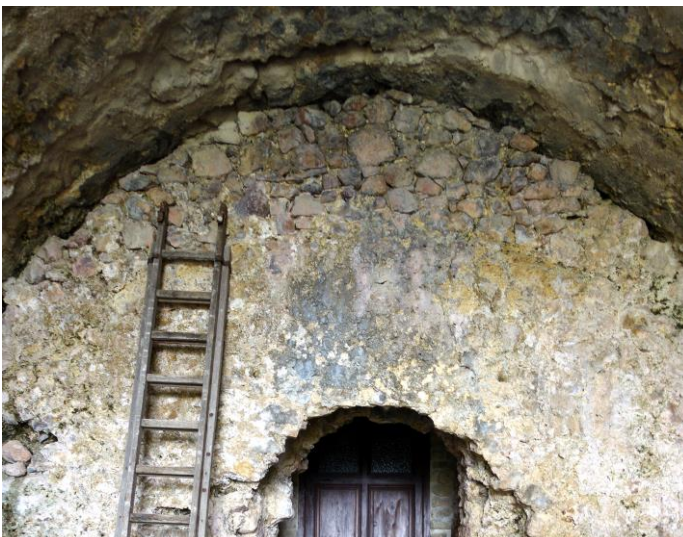
Fig. 65 : Mur de séparation non intégré à la voûte
