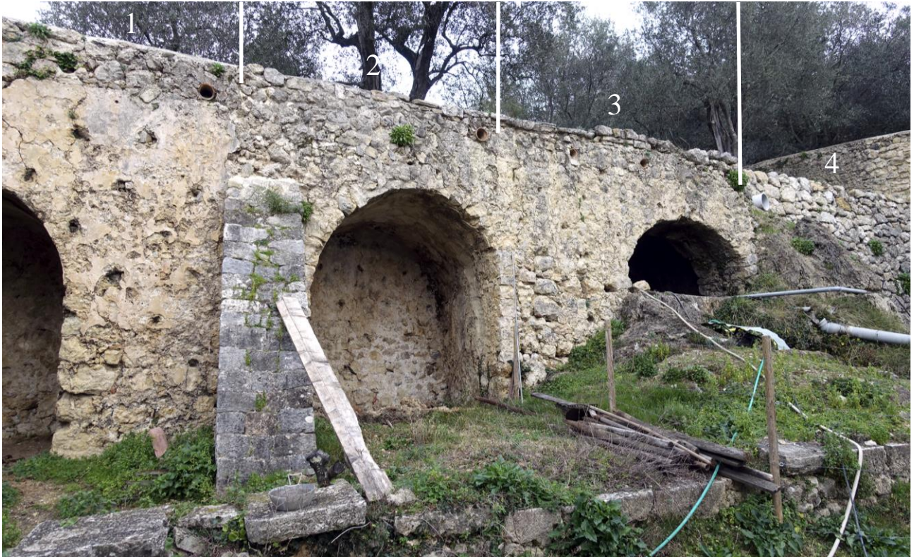
Fig. 36 : Partie orientale montrant trois types de construction et de reconstruction Le 1er et le 3e tronçons sont contemporains et antérieurs au 2e qui ne possède pas les bouches d'écoulement
