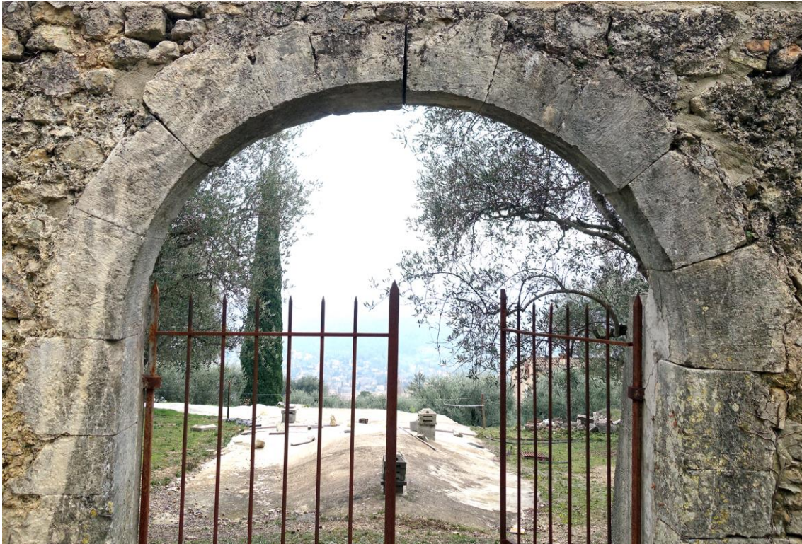
Fig. 81 : Couverture de protection du cellier en béton (Vue de la porte cintrée de Jardin Nord)
