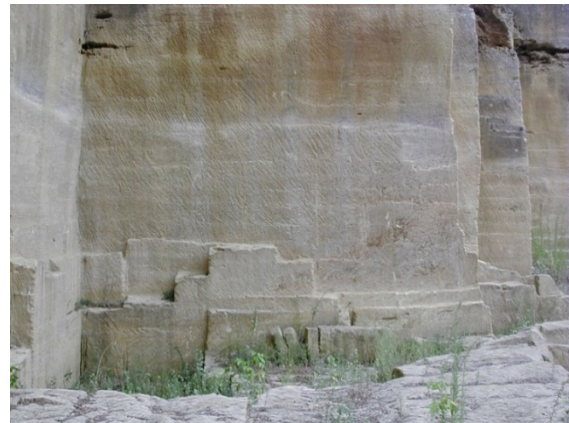
Fig. 33 – Carrière moderne de l'Estel sud. La partie haute des fronts de taille et le sol au premier plan, correspondent à la carrière d'approvisionnement du pont routier, la partie inférieure concerne la réouverture de chantiers de faibles volumes qui reprennent les sols de l'exploitation antérieure. (Cliché Inrap, 2002, Vacca-Goutoulli, 2006).
