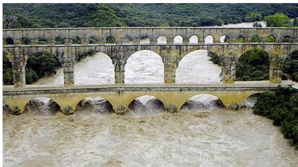
Fig. 7 – le Gardon et le Pont du Gard, vue aérienne. Le parement aval du monument pendant la crue millénaire de septembre 2002. (Cliché Midi-Libre, 2002).
