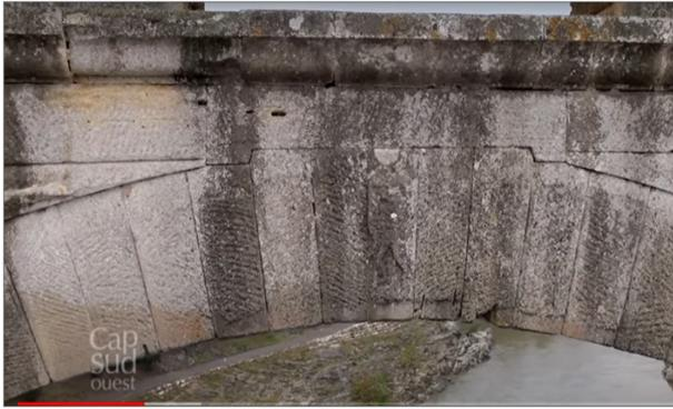
*Fig. 22 – Vue de détail de la voûte de l'arche majeure du deuxième étage d'arches du Pont-du-Gard. L'agencement précis et soigné des voussoirs, la finesse des joints, la tenue d'arête et la qualité des adoucis dans les moulures, caractérisent une pierre au grain fin et régulier. Sur la clé, bas-relief représentant sans doute un tailleur de pierre. (Cliché Cap Sud-ouest).*
