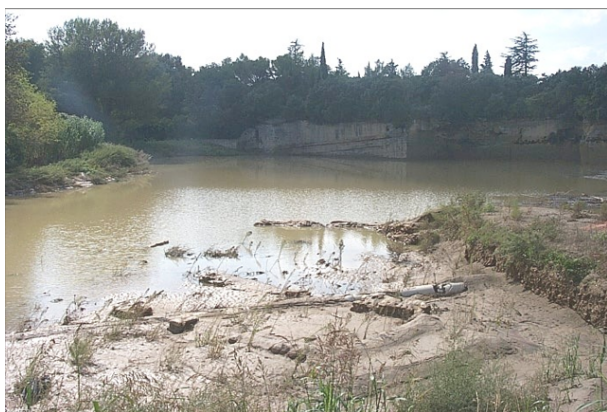
Fig. 8 – Carrière de l'Estel, le 14 septembre 2002 après la crue millénaire des 8 et 9 septembre 2002, vue prise du nord. Au premier plan, l'espace de l'habitat des carriers. (Cliché Lydiane Estève EPCC Pont du Gard, 2002).
