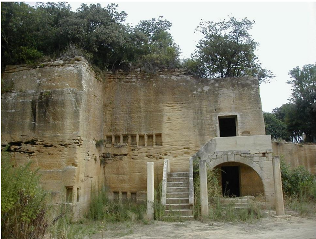
Figure 31 : La maison de l'appareilleur. L'entrée du niveau inférieur est protégée des crues par un seuil surélevé. Apé rupestre. (Cliché Inrap, 2002), Vacca-Goutoulli, 2006.
