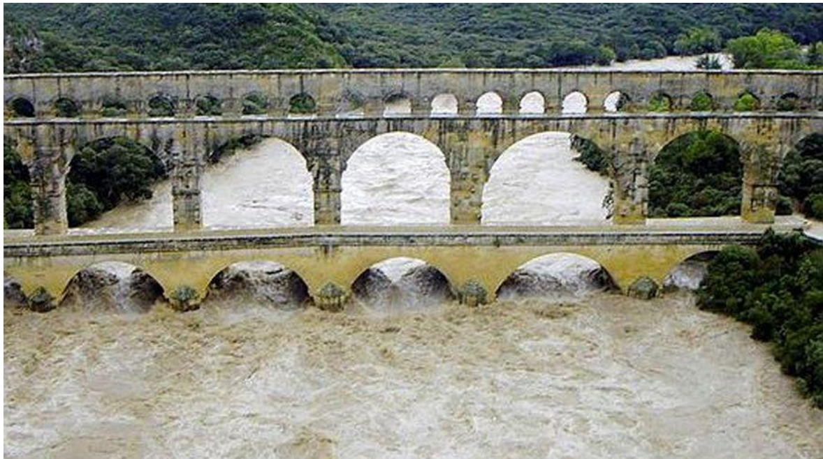
Figure 7: le Gardon et le Pont du Gard, vue aérienne. Le parement aval du monument pendant la crue millénale de septembre 2002. (Cliché Midi-Libre, 2002).
