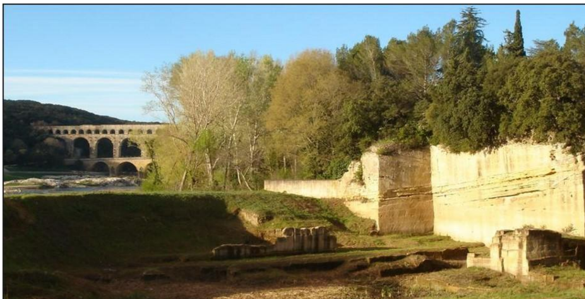
Figure 1 : 2006, la carrière romaine et le Pont du Gard, vus depuis la maison de l'appareilleur. La digue, bien qu'affaiblie, s'est maintenue en place. Depuis 2002, des crues majeures en 2009 et 2014, ont déposé des épaisseurs de sables micacés qui aujourd'hui encore, colmatent les sols mis au jour par l'étude archéologique. (Cliché M. V-G, 2006).
