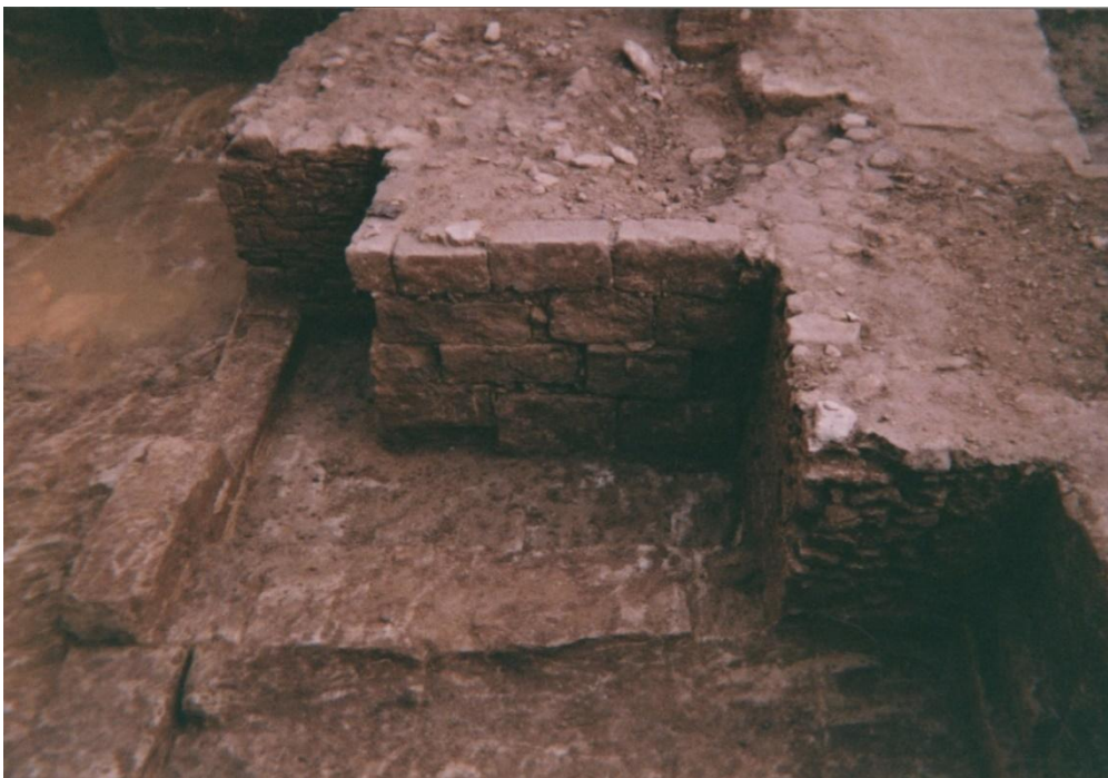
Figure 33: Carrière moderne. Murets destinés à contenir les déchets d'extraction. La terrasse édifée de cette façon, facilite la manutention des blocs et leur embarquement sur des charriots. (Cliché Afan, 1998, Vacca-Goutoulli, 1999).
