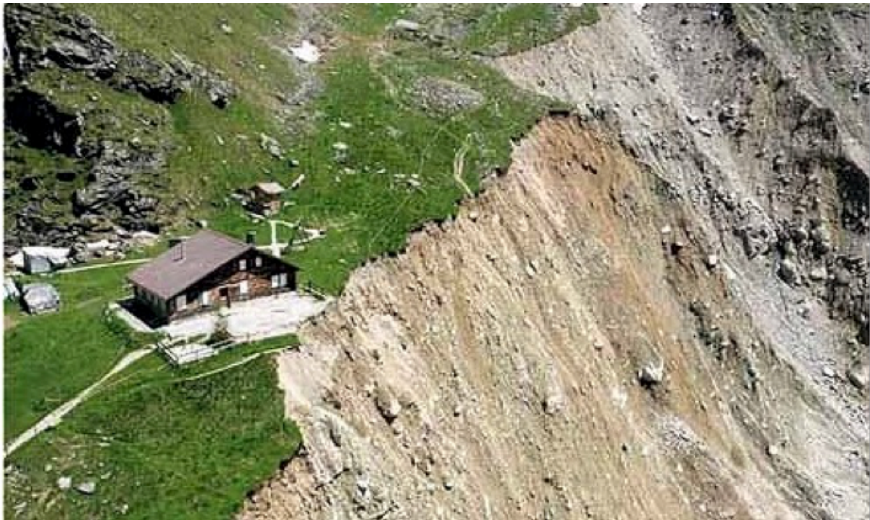
Glissement (Source : http://www.images-droles.com/image-drole-1298-chalet-glissement-de-terrain.html )
