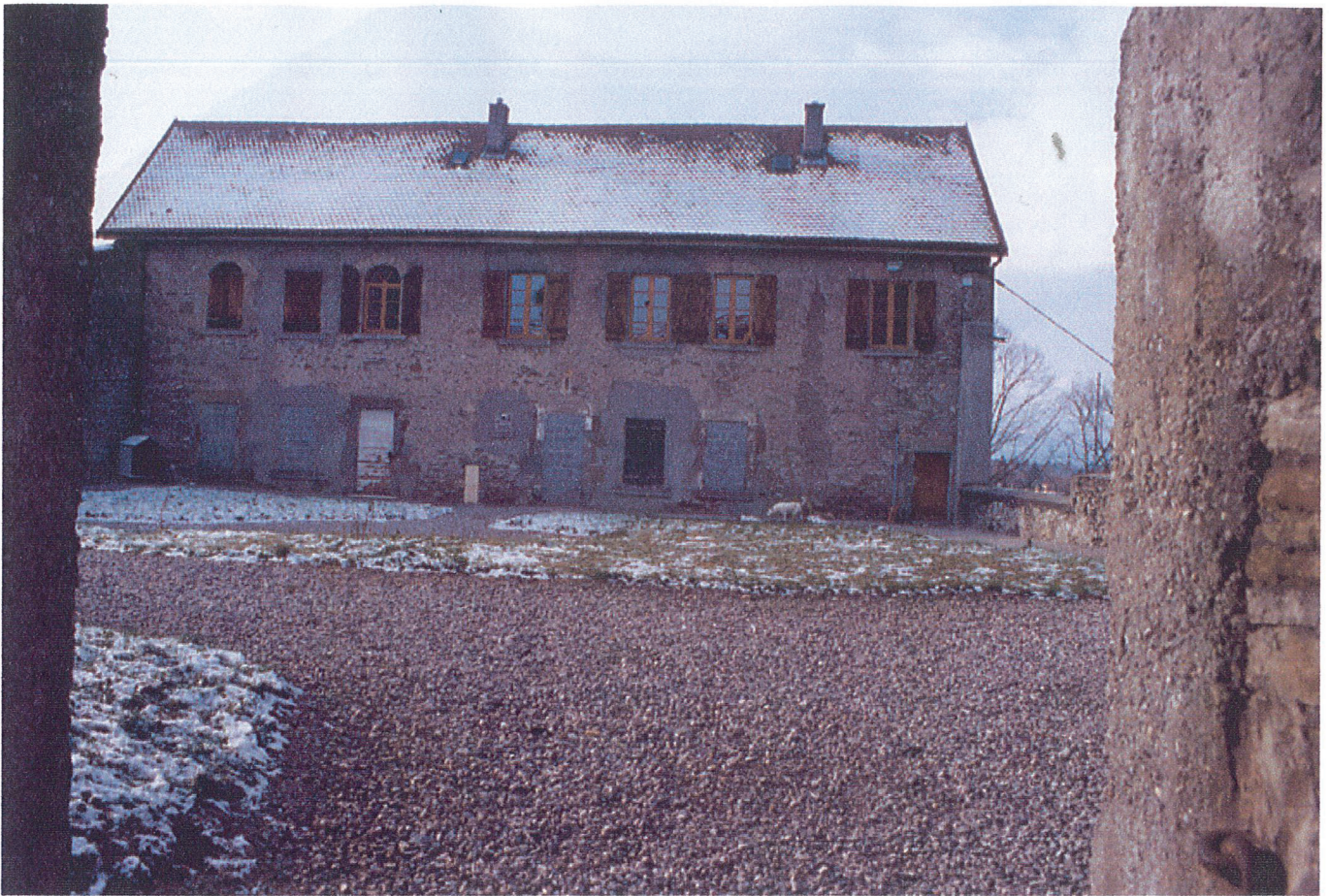
logement du gardien, façade est
