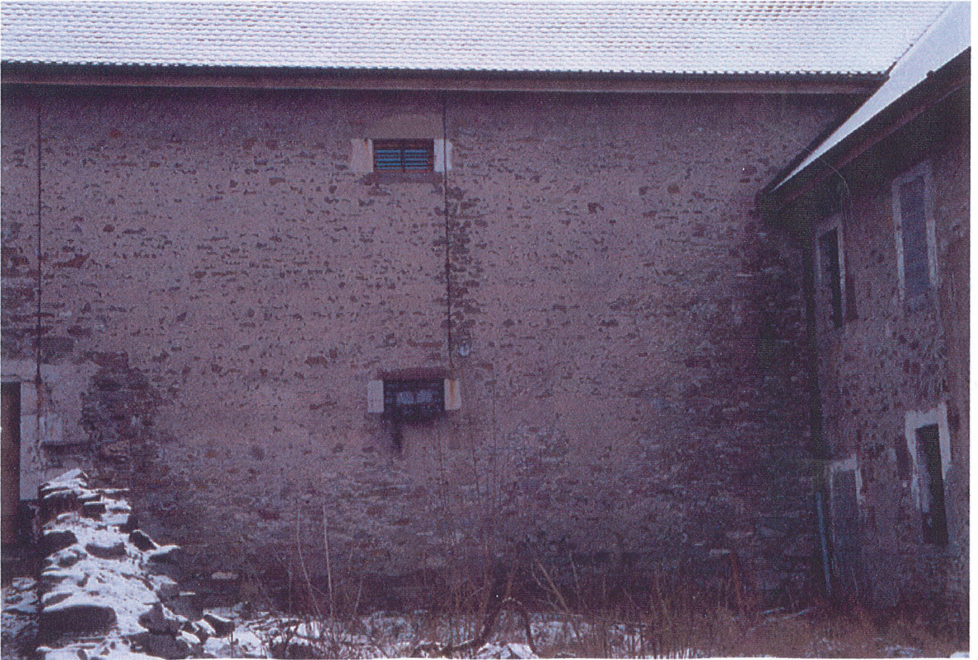
logement du gardien, façade ouest
