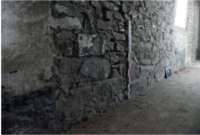
Fig 223 : Vestiges du parement USC 10325 dans l'espace ES 1.31. Cliché : Équipe de fouille 2020.
