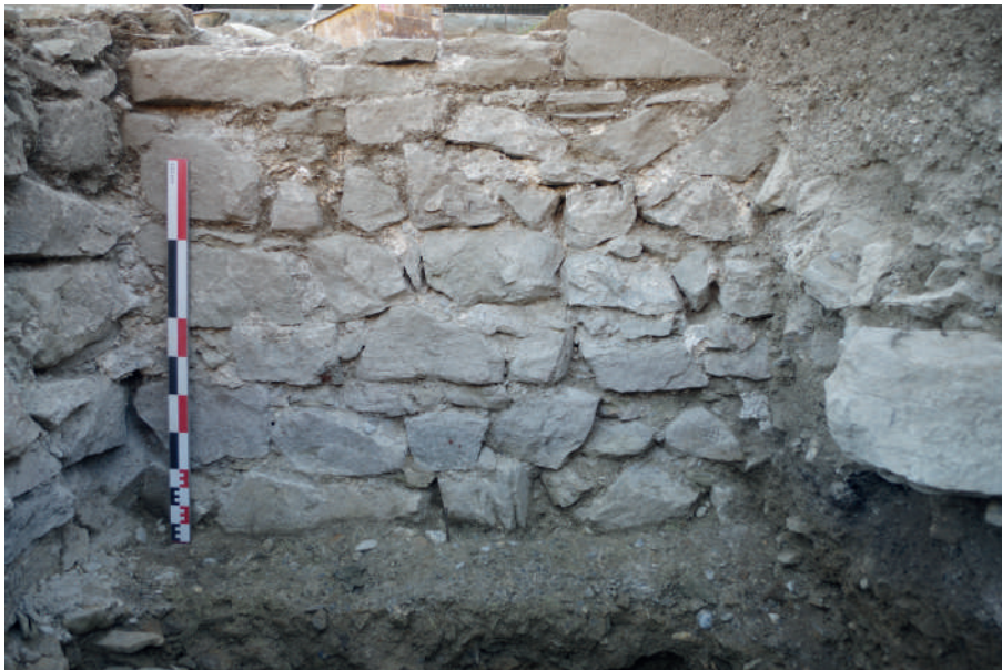
Fig 85 : Elévation occidentale du mur M 1002. Cliché : Equipe de fouille 2018.
