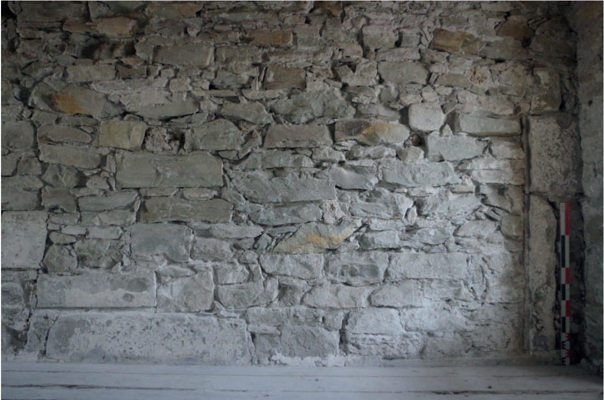
Fig 194 : Parement oriental du mur M 1075. Cliché : Équipe de fouille 2020.
