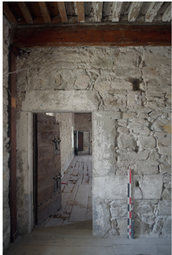
Fig 210 : Porte POR 1084 entre les espaces ES 1.29 et 1.30. Cliché : Équipe de fouille 2020.
