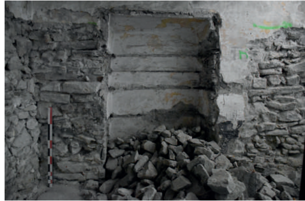
Fig 152 : Liaison entre les courtines occidentale et septentrionale au sein de l'espace ES 1.25. Cliché : Équipe de fouille 2020.
