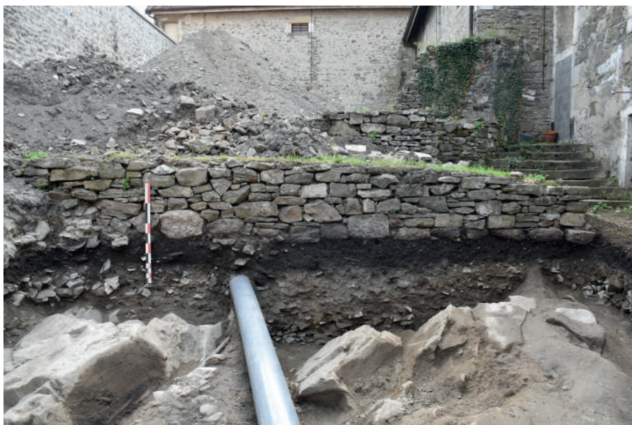
Fig 120 : Vue du parement ouest du mur M 1045.
