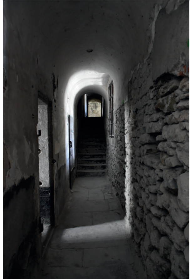
Fig 176 a : Couloir ES 1.11 Clichés : Équipe de fouille 2020..
