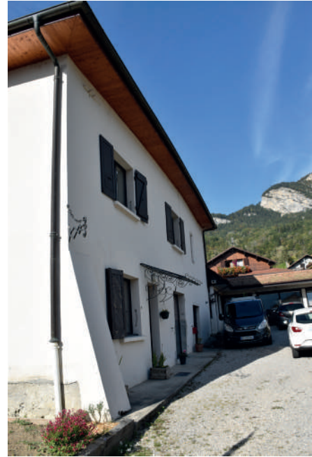
Fig 316 : Façade orientale du Maney. Cliché : Equipe de fouille.
