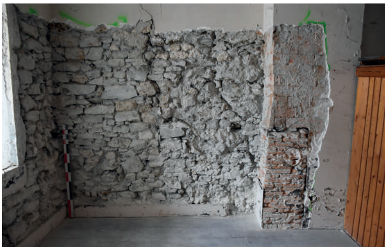
Fig 213 : CHE 1090 et reprises USC 10306 et USC 10307 du parement USC 10305 (M 1098 - ES 1.28). Cliché : Équipe de fouille 2020.
