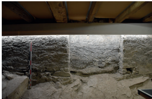
Fig 333 : Ancienne ouverture bouchée. Cliché : Equipe de fouille.
