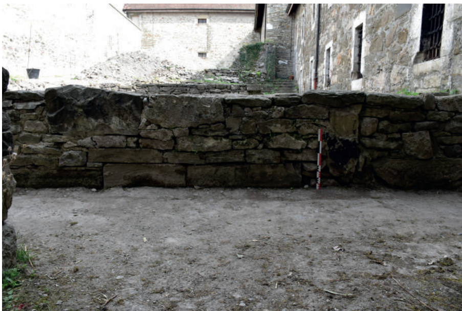
Fig 129 : Parement occidental du mur M 1040. Cliché : Équipe de fouille 2019.
