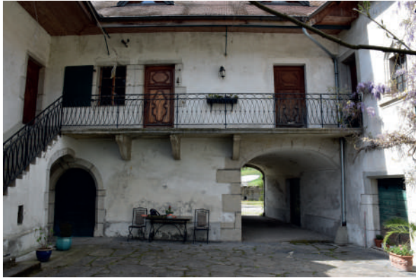
Fig 304 : Façade orientale du logis ouest. Cliché : Equipe de fouille.
