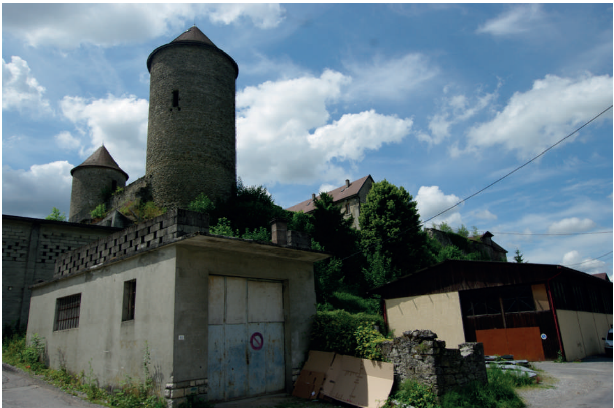
Fig 54 : Parking situé en contrebas de la courtine orientale. Cliché : C. Guffond.
