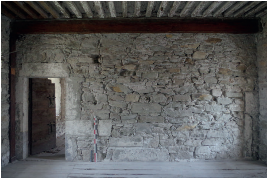
Fig 13 a et b : Exemples d'une pièce à l'étage présentant des murs presque sans enduits et d'un décrouantage partiel. Clichés : Équipe de fouille 2020.
