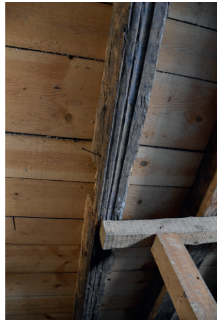
Fig 318 : Solivage de la cave. Cliché : Equipe de fouille.
