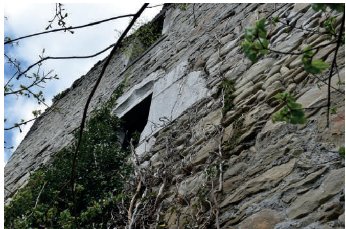
Fig 373 : Exemple d'ouverture présentant un linteau à accolade. Cliché : Equipe de fouille.
