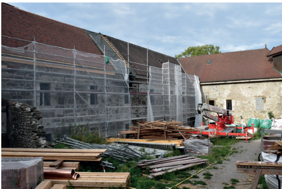
Fig 7 : Bâtiments des prisons. Clichés : Equipe de fouille 2020.
