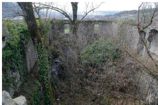
Fig 369 a et b : Vue d'ensemble du logis depuis l'escalier. Clichés : Equipe de fouille.
