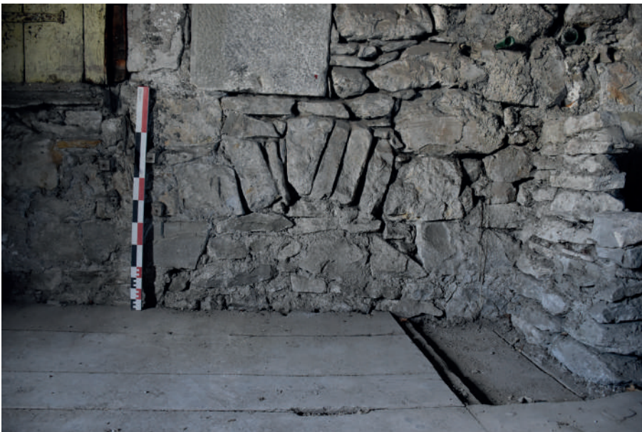
Fig 155 : Ouverture OUV 1142. Cliché : Équipe de fouille 2020.
