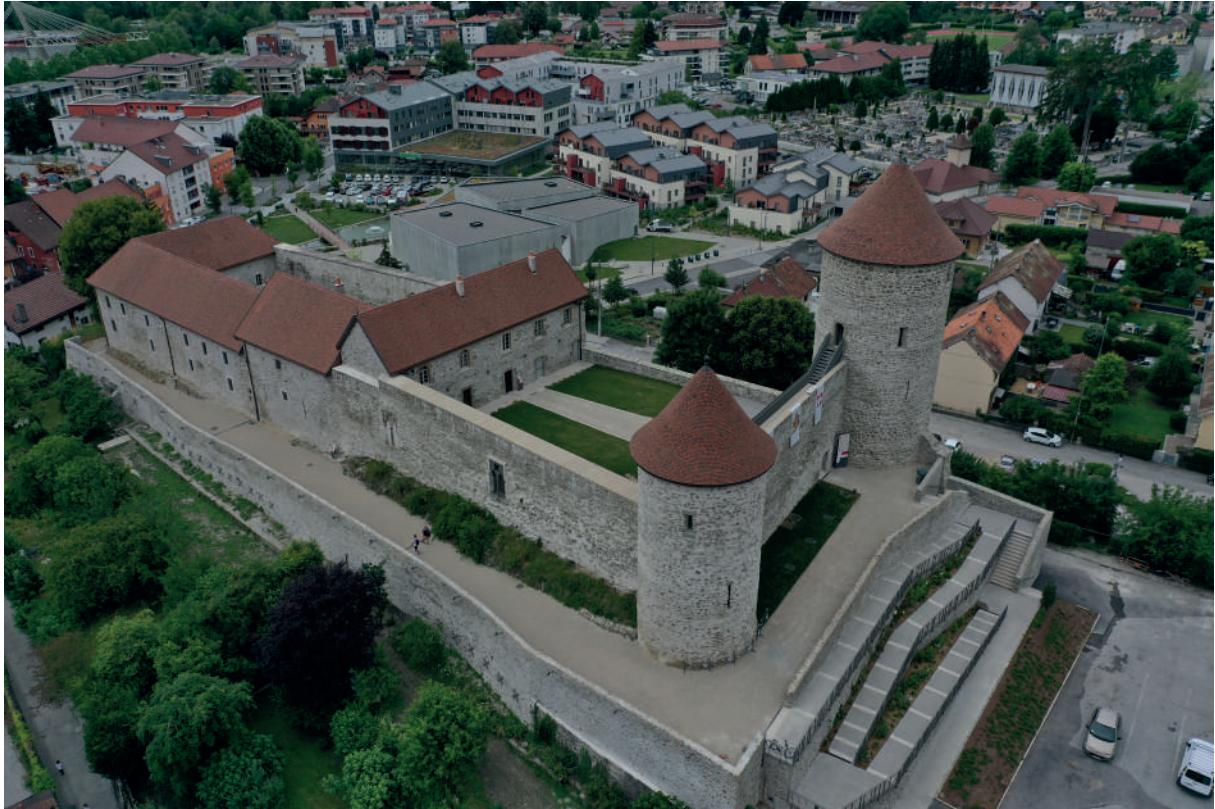
Fig 1 : Vue générale du château de Bonneville après restauration. Cliché : Communauté de communes Faucigny-Glières.
