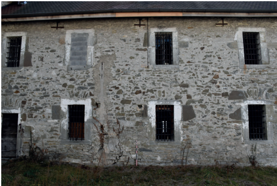
Fig 59 : Aile haute des prisons. Cliché : Équipe de fouille 2019.
