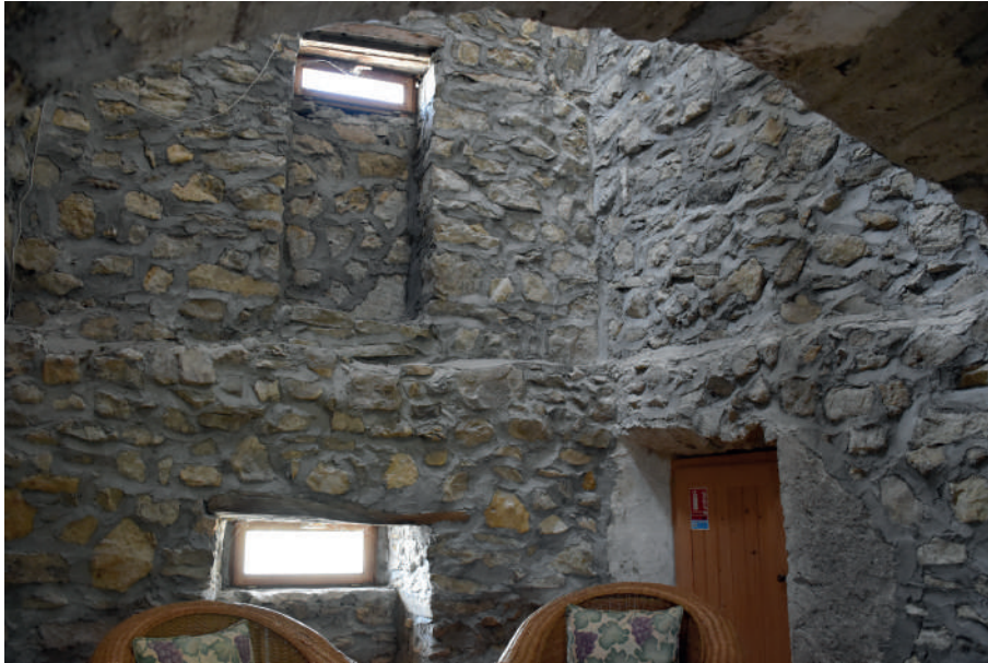
Fig 296 : Intérieur de la tour porte et bouchage des ouvertures. Cliché : Equipe de fouille.
