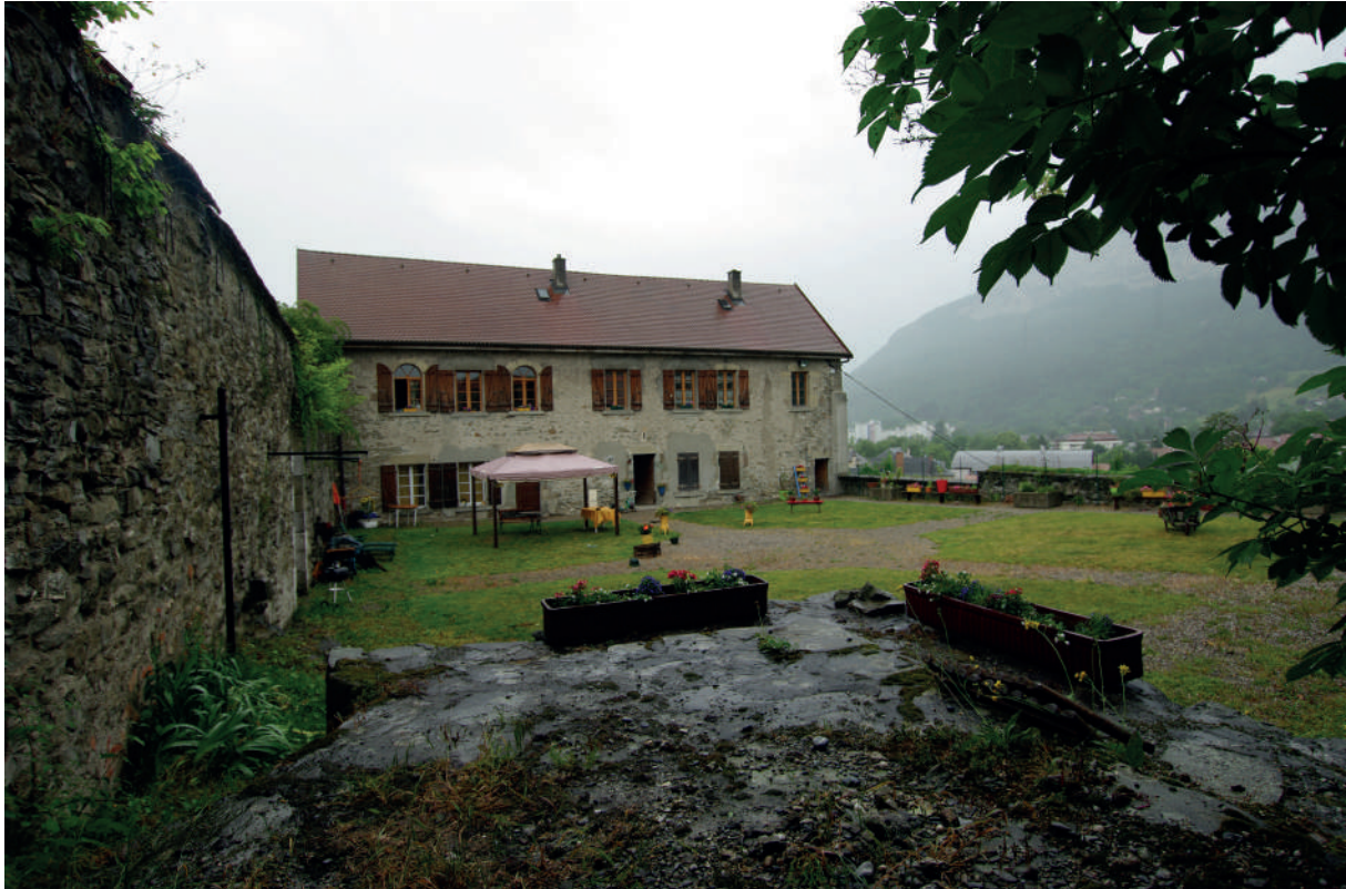
Fig 4 : Les intérieurs du château avant le projet de restauration. Clichés : C. Guffond.
