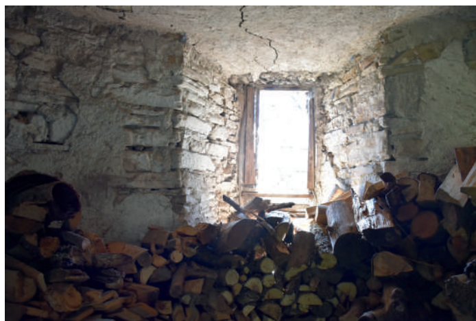
Fig 342 : Vestiges d'enduits autour de la baie de la tour sud-ouest. Cliché : Equipe de fouille.
