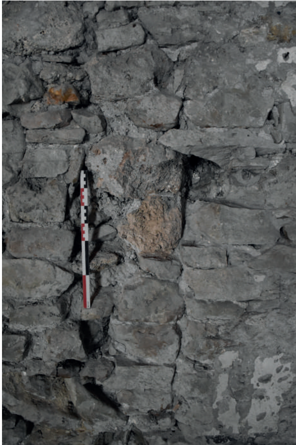
Fig 189 : Vestiges de l'ouverture OUV 1104 située à l'étage de l'aile basse. Cliché : Équipe de fouille 2020.
