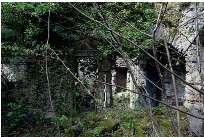
Fig 381 a et b : Tronçon du mur de refend sud. Clichés : Equipe de fouille.
