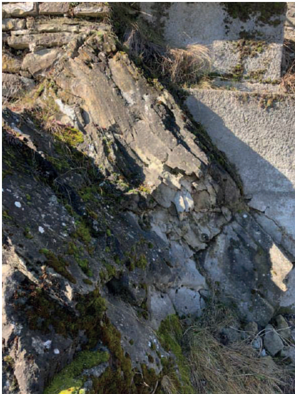
Fig 46 : Mur intérieur du château de Bonneville et son soubassement (substratum) constitué de « grès de Bonneville ». Remarquez le pendage du substratum.
