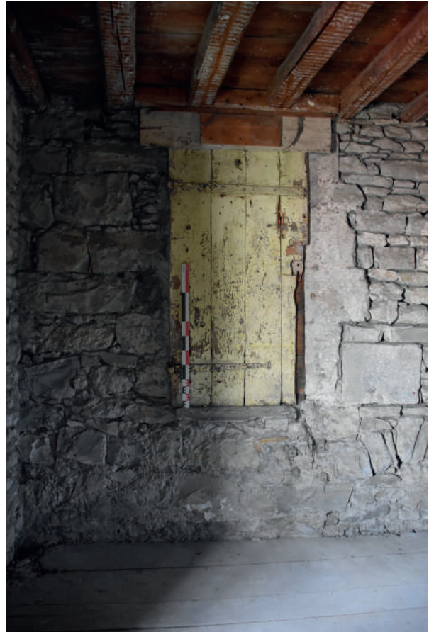
Fig 169 : Installation de la porte POR 1137 dans le mur M 1052. Cliché : Équipe de fouille 2020.
