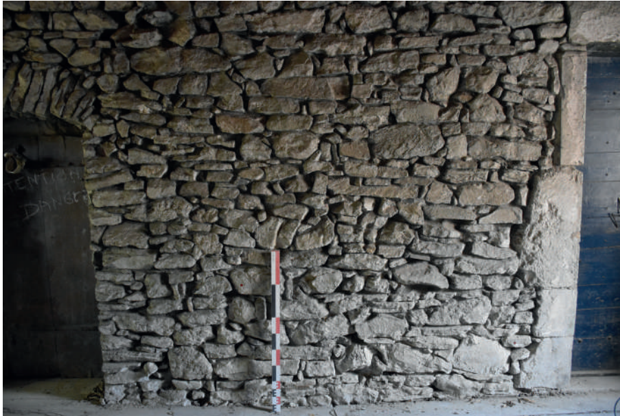
Fig 160 : Parement USC 10401 du mur M 1133 dans l'espace ES 1.27. Cliché : Équipe de fouille 2020.
