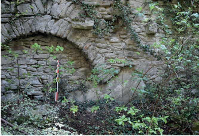
Fig 370 : Mise en œuvre et adaptation au substrat géologique. Cliché : Equipe de fouille.
