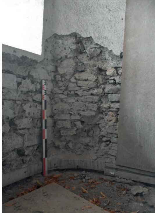
Fig 212 : USC 10285 reprise en partie basse du chaînage d'angle du mur M 1064 (USC 10284) et M 1098 (USC 10304). Cliché : Équipe de fouille 2020.
