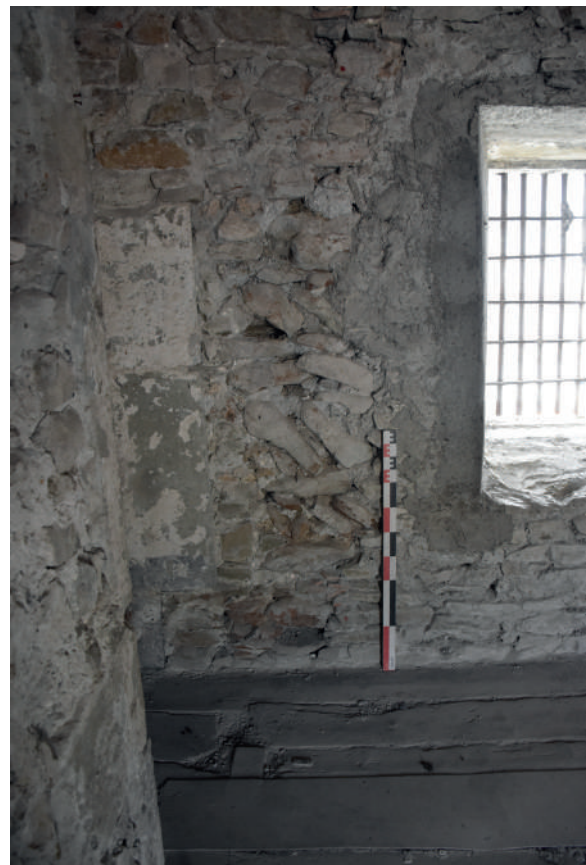
Fig 179 : Parement USC 10302 du mur M 1064 en ES 1.29. Cliché : Équipe de fouille 2020
