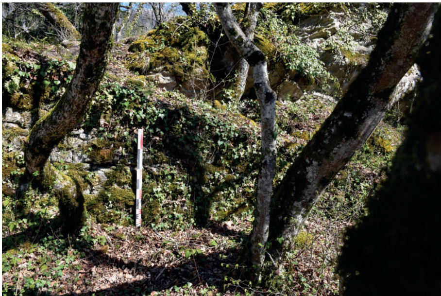
Fig 349 : Rampe du logis oriental. Cliché : Equipe de fouille.
