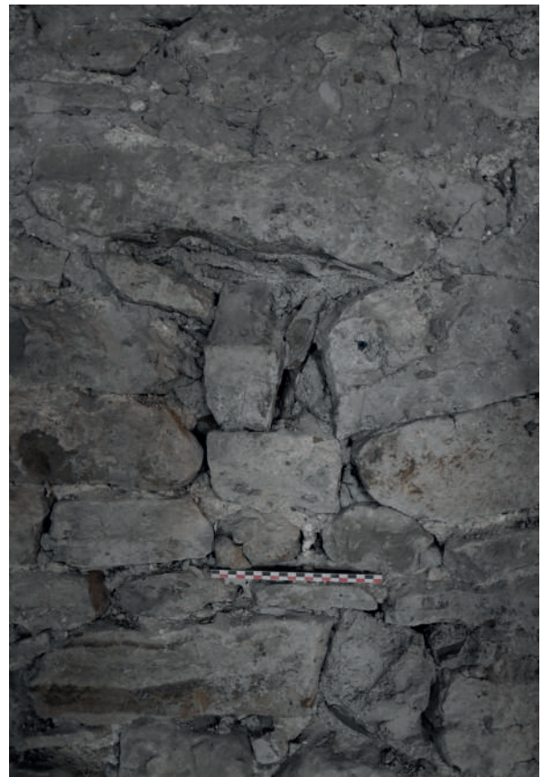
Fig 185 : Trou de boulin TRB 1100. Cliché : Équipe de fouille 2020.
