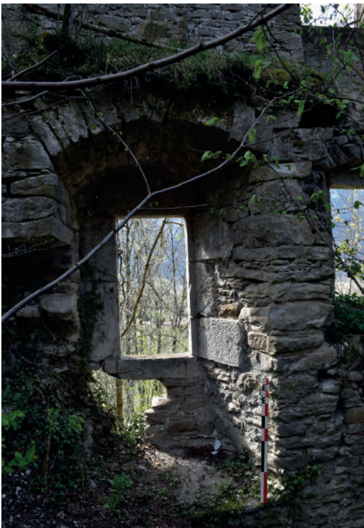
Fig 372 : Exemple de baie conservée. Cliché : Equipe de fouille.
