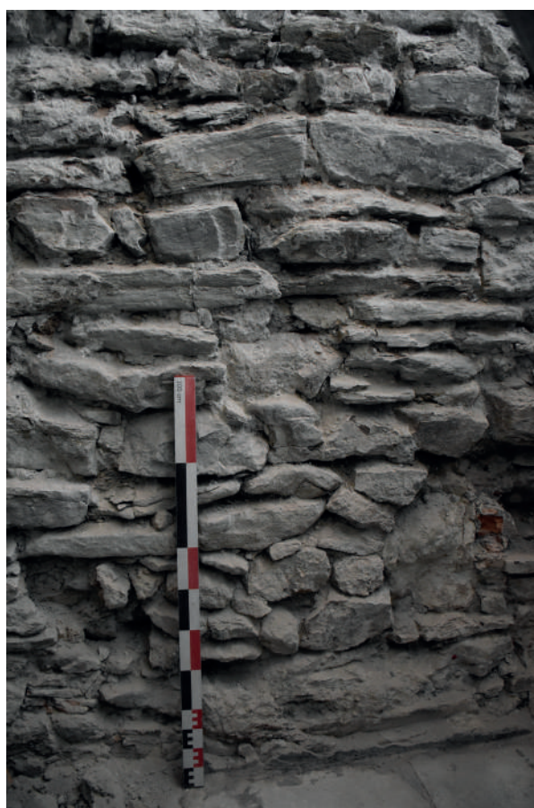
Fig 158 b : Parement USC 10319 présent sur le mur M 1107 au sein de l'espace ES 1.25. Cliché : Équipe de fouille 2020.
