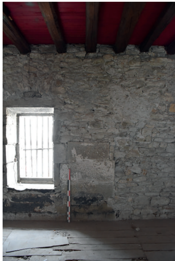
Fig 190 : Vue générale du mur M 1054.
