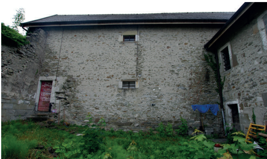
Fig 60 : Bâtiment du gardien, vue générale depuis l'ouest. Cliché : Équipe AVER 2010-2012.
