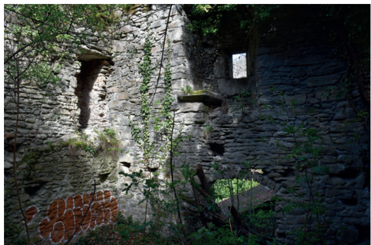
Fig 377 : Ouverture récente dans le mur gouttereau ouest et baie à coussiège. Cliché : Equipe de fouille.
