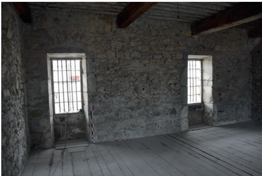
Fig 199 : Fenêtres 1081 et 1082 de ES 1.30. Cliché : Équipe de fouille 2020.
