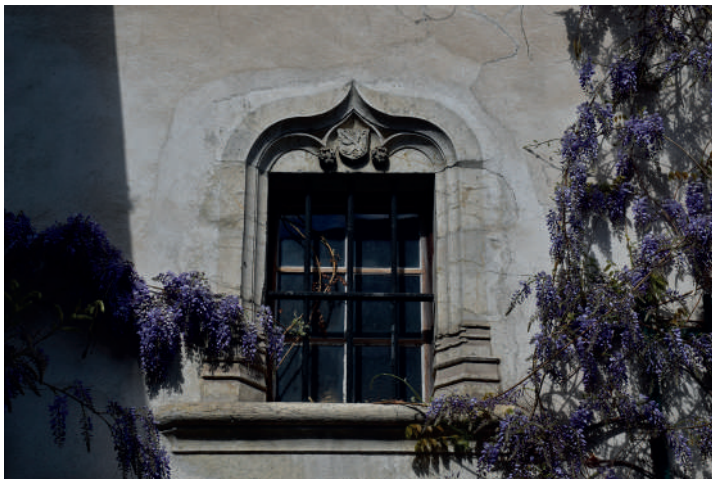
Fig 307 : Fenêtre à accolade aux armoiries de la famille de Menthon. Cliché : Equipe de fouille.
