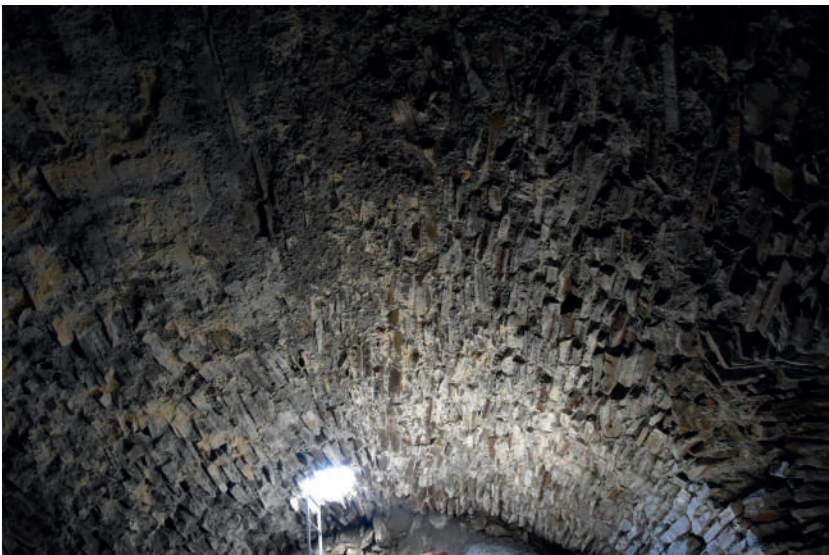
Fig 109 : Vue de l'intrados de la voûte VOU 1025. Cliché : Equipe de fouille 2018.
