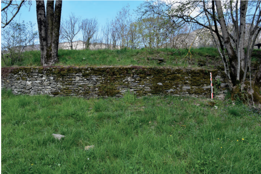
Fig 289 : Mur sud du bâtiment moderne. Cliché : Equipe de fouille.
