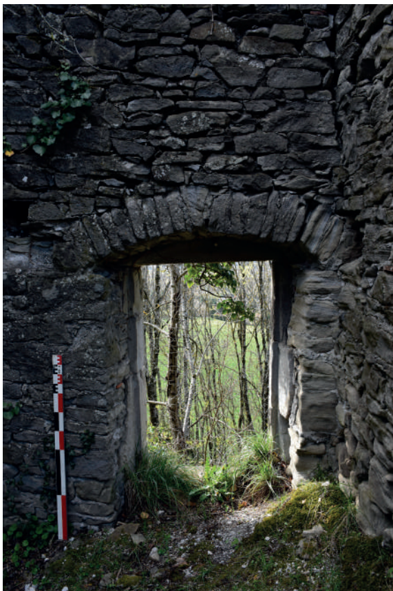
Fig 368 : Baie du 2nd étage de la tour escalier. Cliché : Equipe de fouille.
