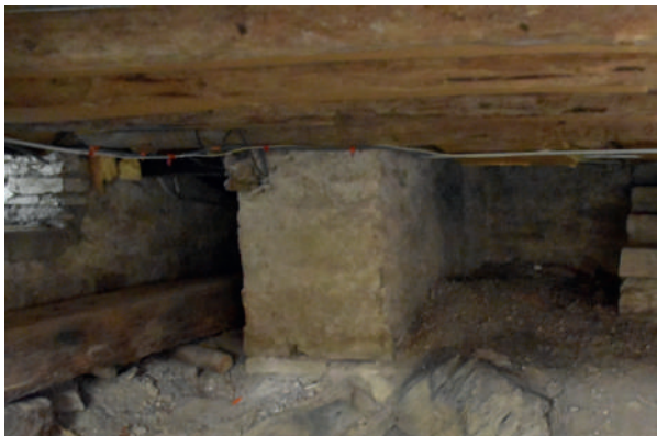
Fig 332 : Ancien escalier desservant le niveau de sous-sol. Cliché : Equipe de fouille.
