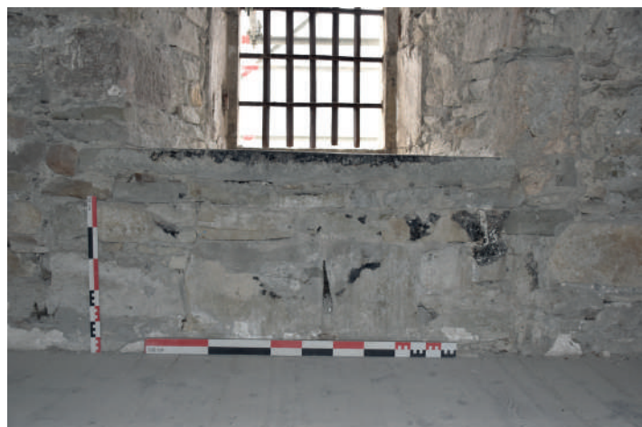
Fig 203 b : FEN 1079 – appuie USC 10446 sur maçonnerie USC 10252. Cliché : Équipe de fouille 2020.
