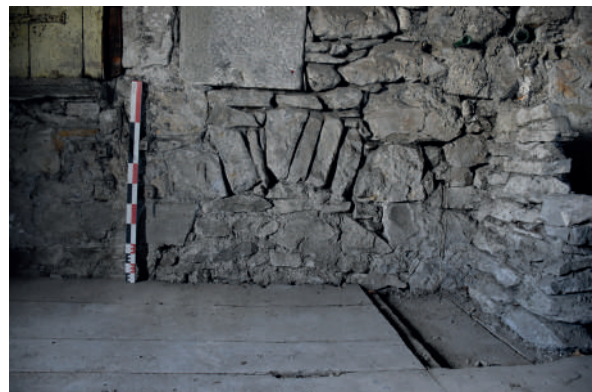
Fig 167 : Bouchage de l'ouverture OUV 1142. Cliché : Équipe de fouille 2020.
