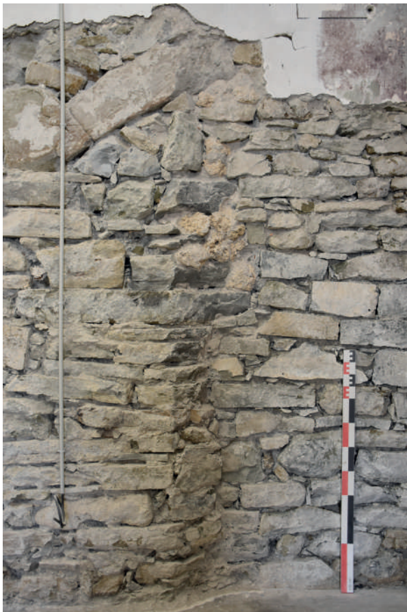
Fig 239 : Buchage entre les reparationtages USC 10214 et 10216 et appareillage de ce dernier. Clichés : Équipe de fouille 2020.
