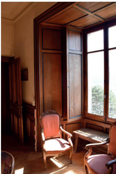
Fig 334 : Epaisseur de la maçonnerie sud visible derrière les boiseries. Cliché : Equipe de fouille.
