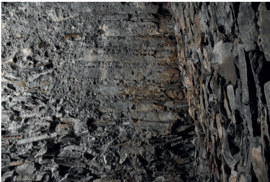
Fig 110 : Détail du négatif des planches du coffrage de la voûte.
