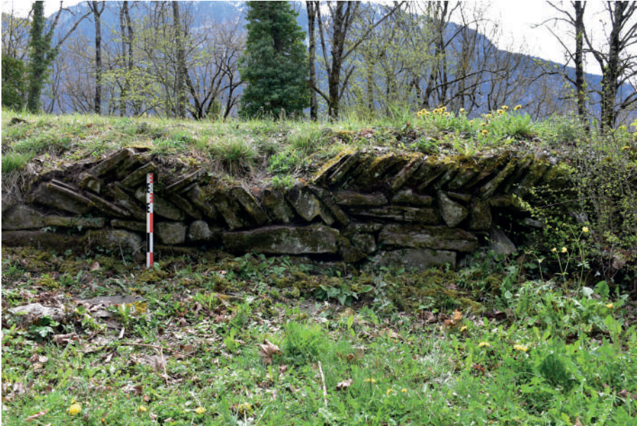
Fig 287 : Mur nord de la maison forte de Pressy. Cliché : Equipe de fouille.
