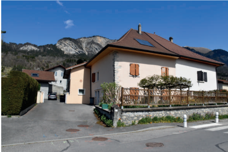
Fig 315 : Chaîne d'angle sud-ouest du bâtiment. Cliché : Equipe de fouille.
