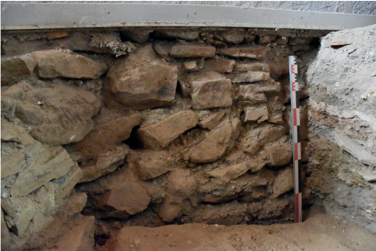
Fig 181 : Parement de la première phase de construction du mur M 1098. Cliché : Équipe de fouille 2020.
