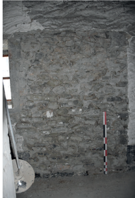
Fig 224 : Surélévation de la courtine sud (M 1064) visible en ES 1.31. Cliché : Équipe de fouille 2020.
