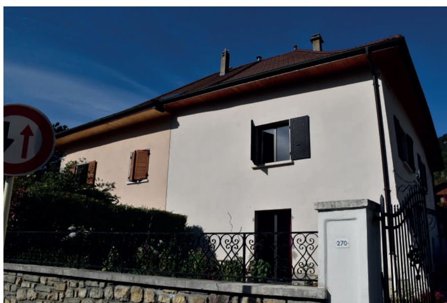
Fig 314 : Vue générale de la maison du Maney. Cliché : Equipe de fouille.
