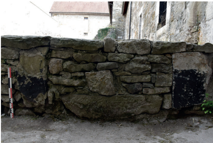
Fig 131 : Porte POR 1041 et son bouchage. Cliché : Équipe de fouille 2019.
