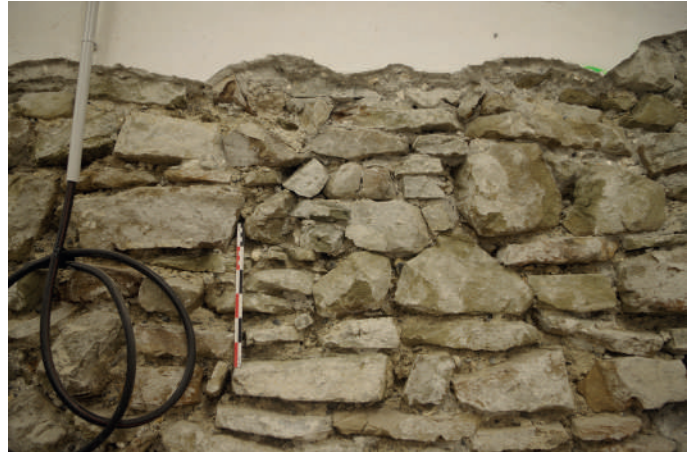
Fig 240 a et b : Exemples de bouchage d'anciens trous de poutre au sein du mur M 1063. Clichés : Équipe de fouille 2020.
