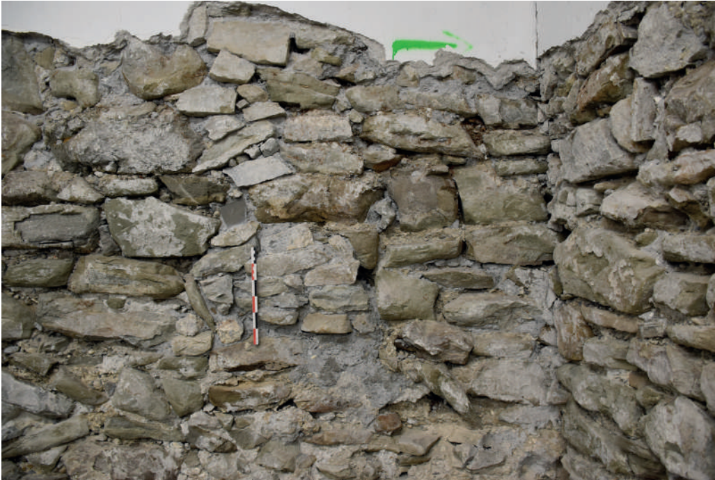
Fig 241 : Réfection USC 10200 sur le parement nord du mur M 1064 (ES 1.10). Cliché : Équipe de fouille 2020.
