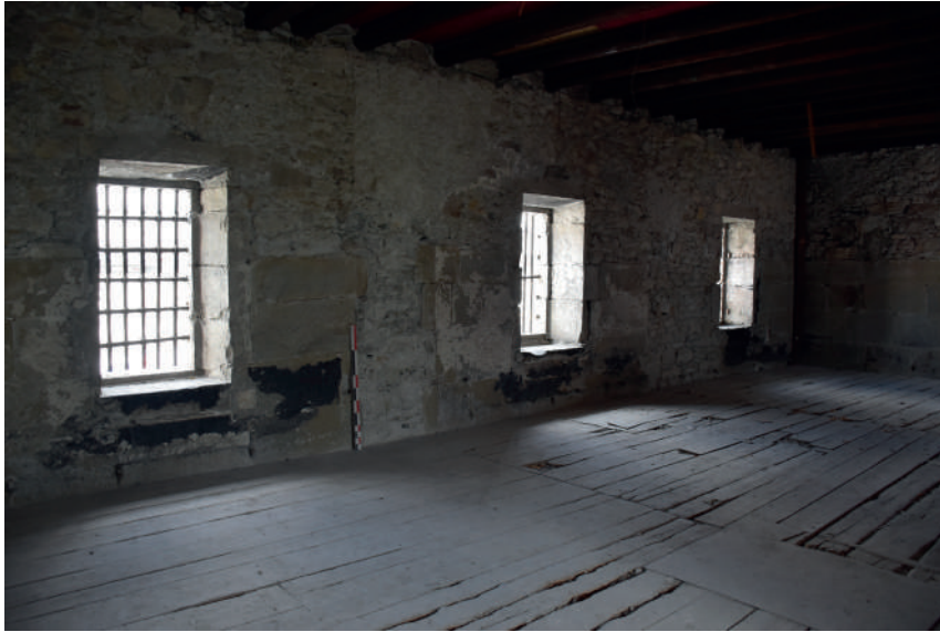
Fig 198 : Fenêtres FEN 1091, 1092 et 1093 de l'espace ES 1.29. Cliché : Équipe de fouille 2020.
