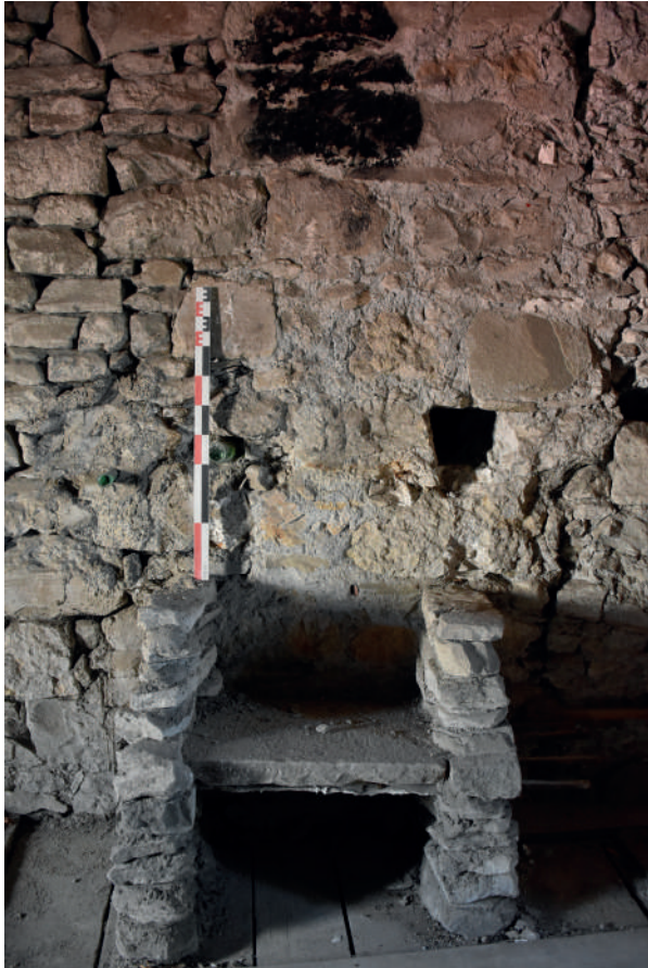
Fig 175 : Cheminée aménagée contre le parement nord du mur M 1052 dans la pièce ES 1.27. Cliché : Équipe de fouille 2020.
