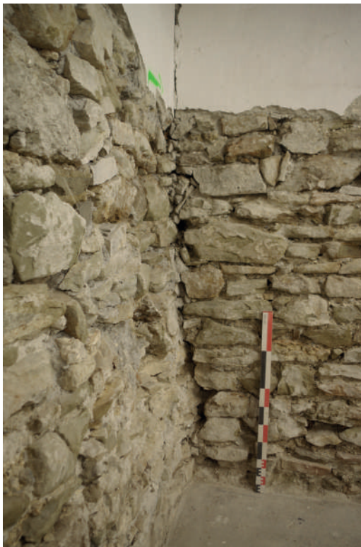
Fig 235 : Liaison entre les murs M 1063 et 1064 au sein de l'espace ES 1.10. Cliché : Équipe de fouille 2020.
