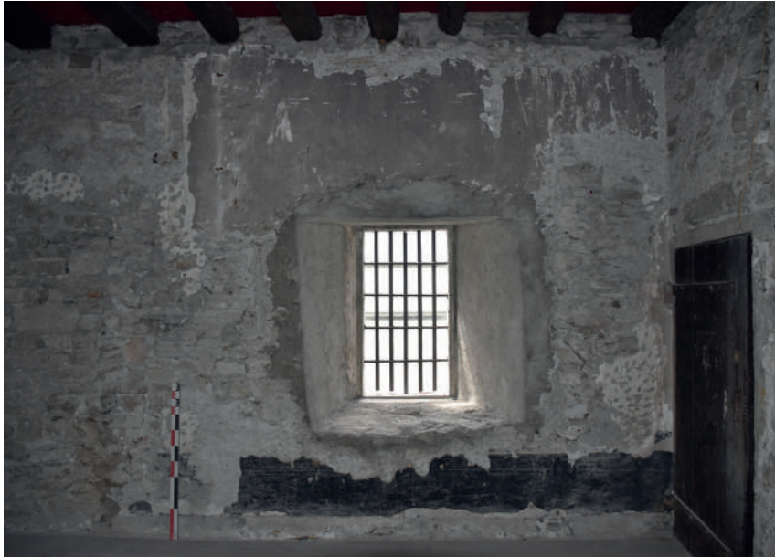
Fig 201 : Fenêtre FEN 1095. Cliché : Équipe de fouille 2020.
