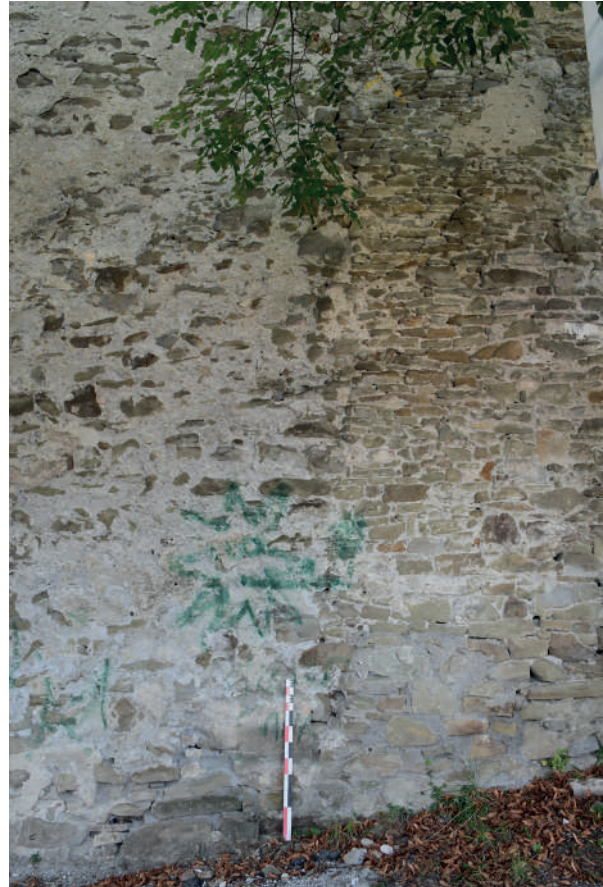
Fig 207 : Parement extérieur de la courtine ouest M 1098. Cliché : Équipe de fouille 2020.
