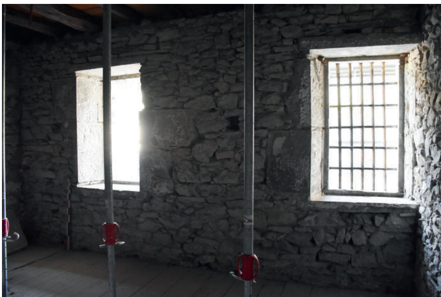
Fig 228 : Fenêtres FEN 1154 et 1155 du mur M 1061 (ES 1.33). Cliché : Équipe de fouille 2020.
