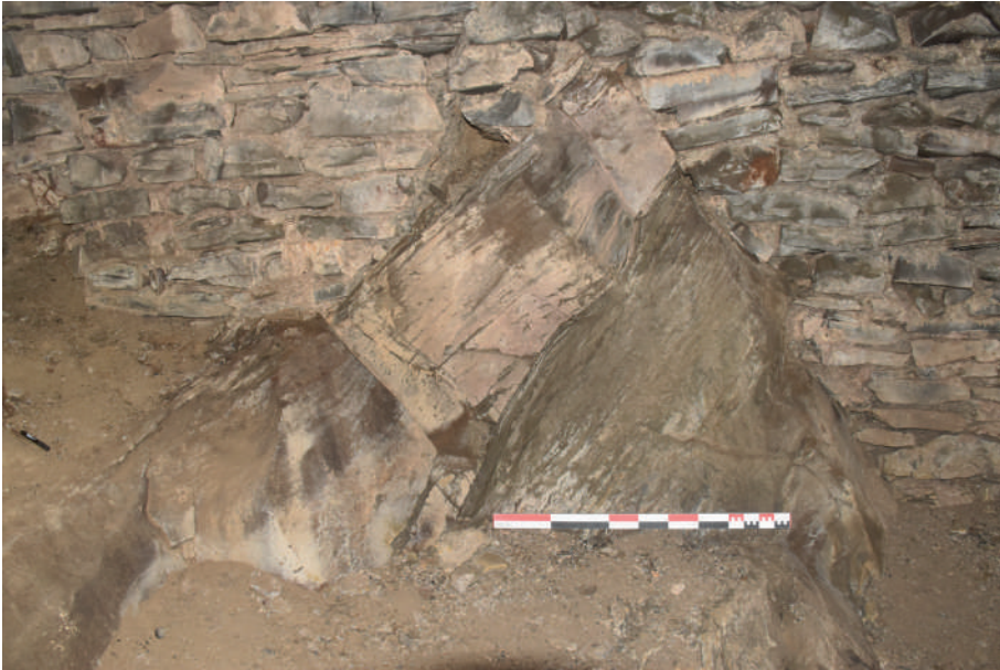
Fig 278 : Fondation du mur oriental de la cave ES 1.7. Cliché : Equipe de fouille 2018.
