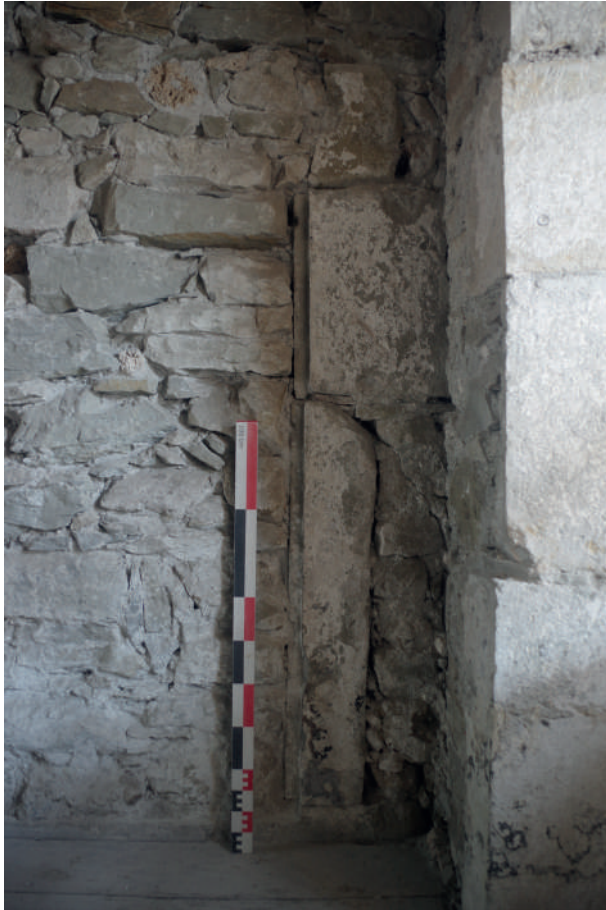
Fig 204 : Vestiges de la porte POR 1085 dans le mur M 1075 (ES 1.30). Cliché : Équipe de fouille 2020.
