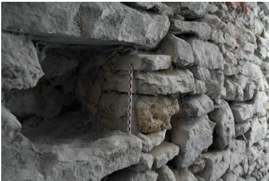
Fig 187 b : Vestiges de la baie OUV 1115. Clichés : Équipe de fouille 2020.
