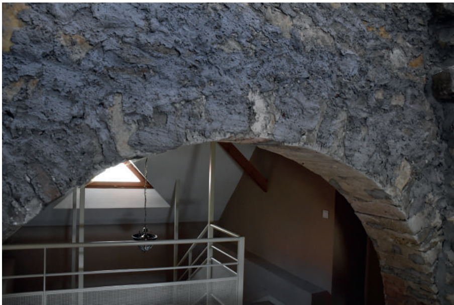
Fig 297 : Arc reconstruit au niveau de la jonction entre la tour et le logis. Cliché : Equipe de fouille.
