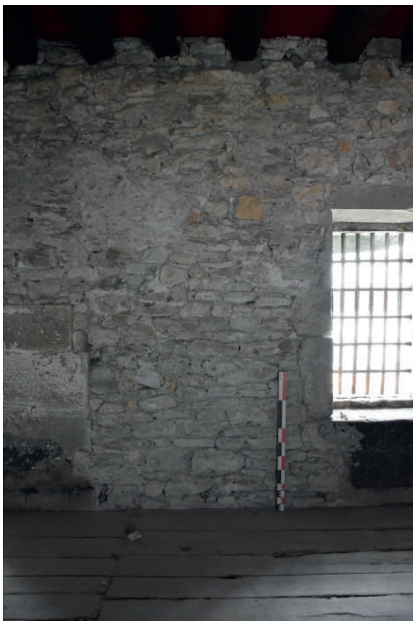
Fig 209 b : Arrachement des maçonneries en ES 1.29 et reparementage partiel. Clichés : Équipe de fouille 2020.
