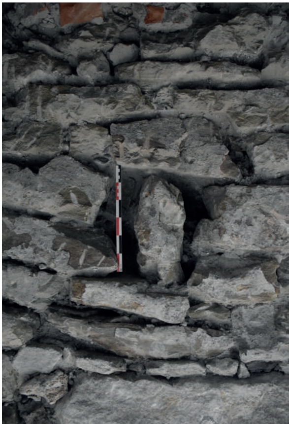
Fig 184 : Trou de boulin TRB 1131 aménagé dans le parement USC 10361. Cliché : Équipe de fouille 2020.
