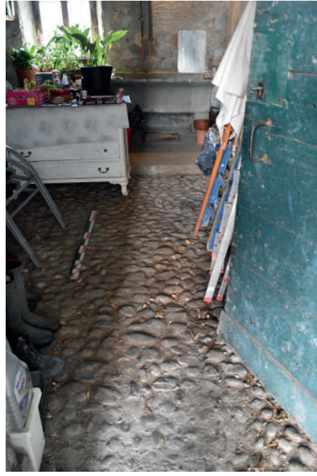
Fig 309 a et b : Potentielles anciennes écuries de la maison forte. Clichés : Equipe de fouille.
