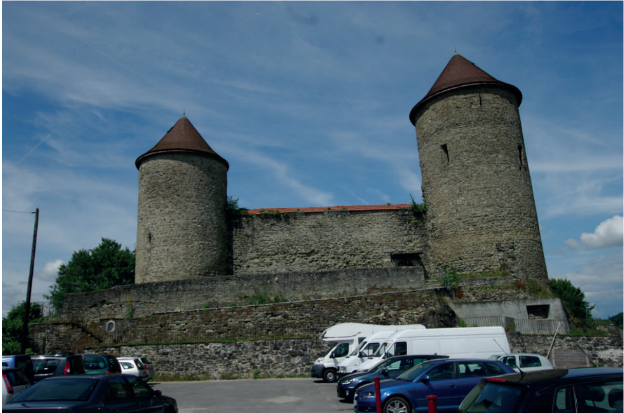
Fig 53 : Vue du château depuis le nord. Cliché : C. Guffond.
