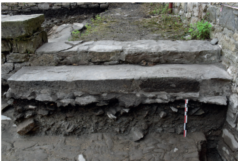
Fig 122 : Ouverture OUV 1043 et escalier ESC 1044. Cliché : Équipe de fouille 2019.
