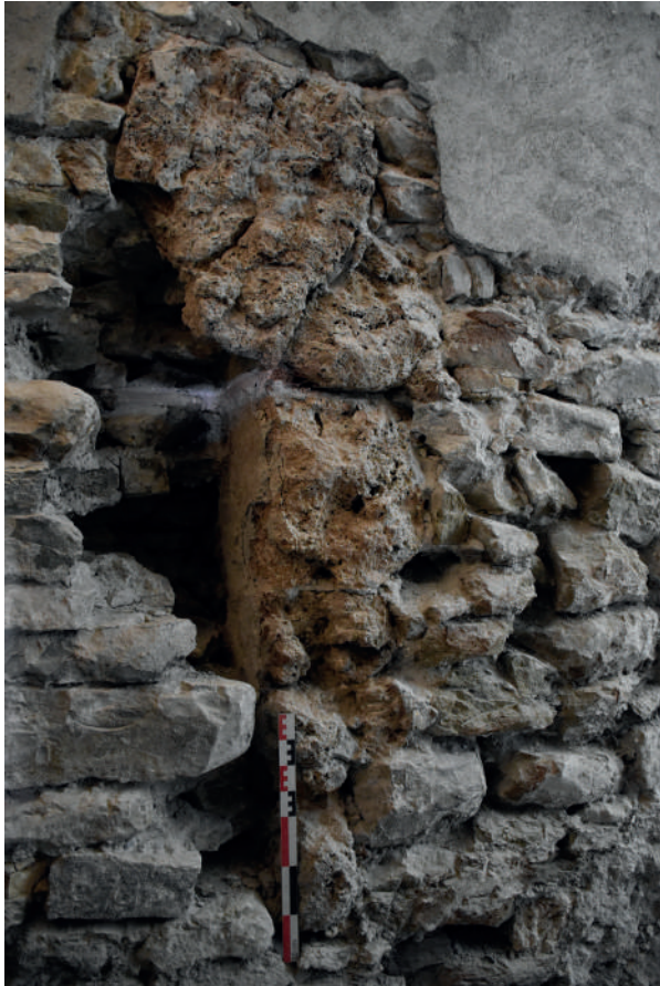
Fig 186 : Baie en tuf OUV 1119 de la deuxième phase de construction. Cliché : Équipe de fouille 2020. Cliché : Équipe de fouille 2020.
