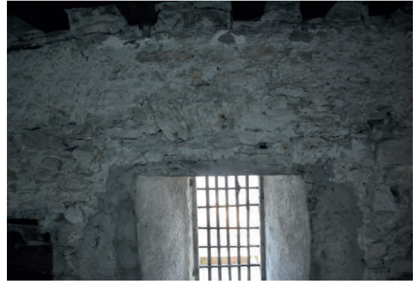
Fig 183 : Vestiges de l'arc de la fenêtre FEN 1176. Cliché : Équipe de fouille 2020.
