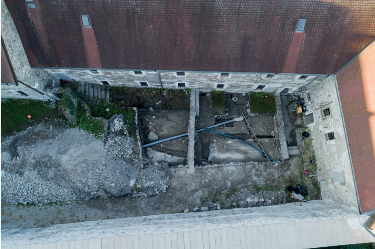
Fig 11 : Fouilles dans la cour des prisons. Cliché : O. Veissière – patrimoine numérique.
