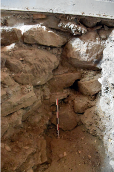
Fig 221 : Chaînage entre la courtine M 1098 et le mur M 1125. Cliché : Équipe de fouille 2020.
