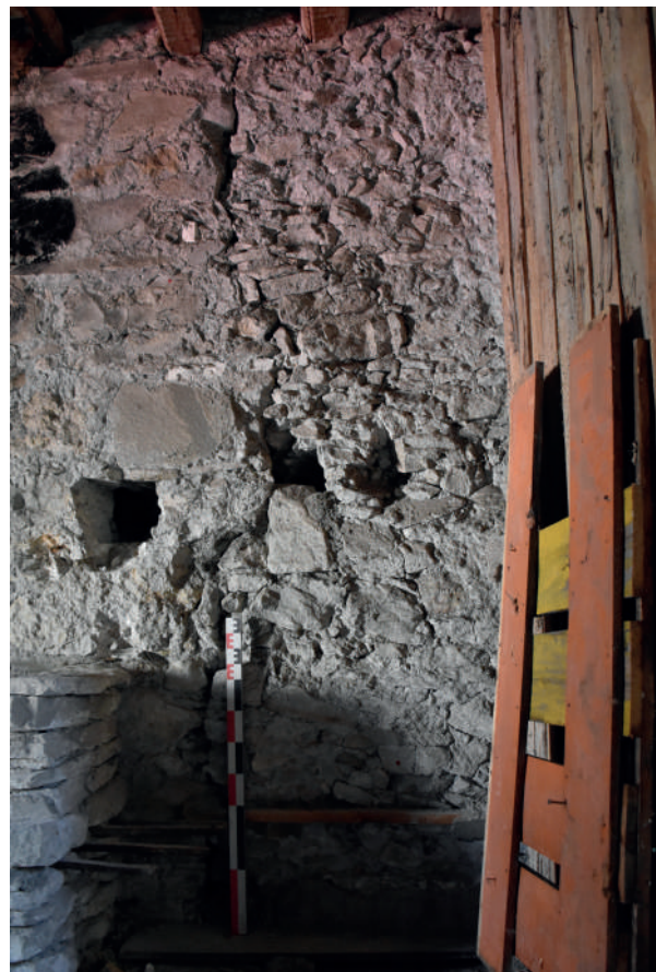
Fig 173 : Reparementage USC 10399 à l'extrémité occidentale du mur M 1052. Cliché : Équipe de fouille 2020.
