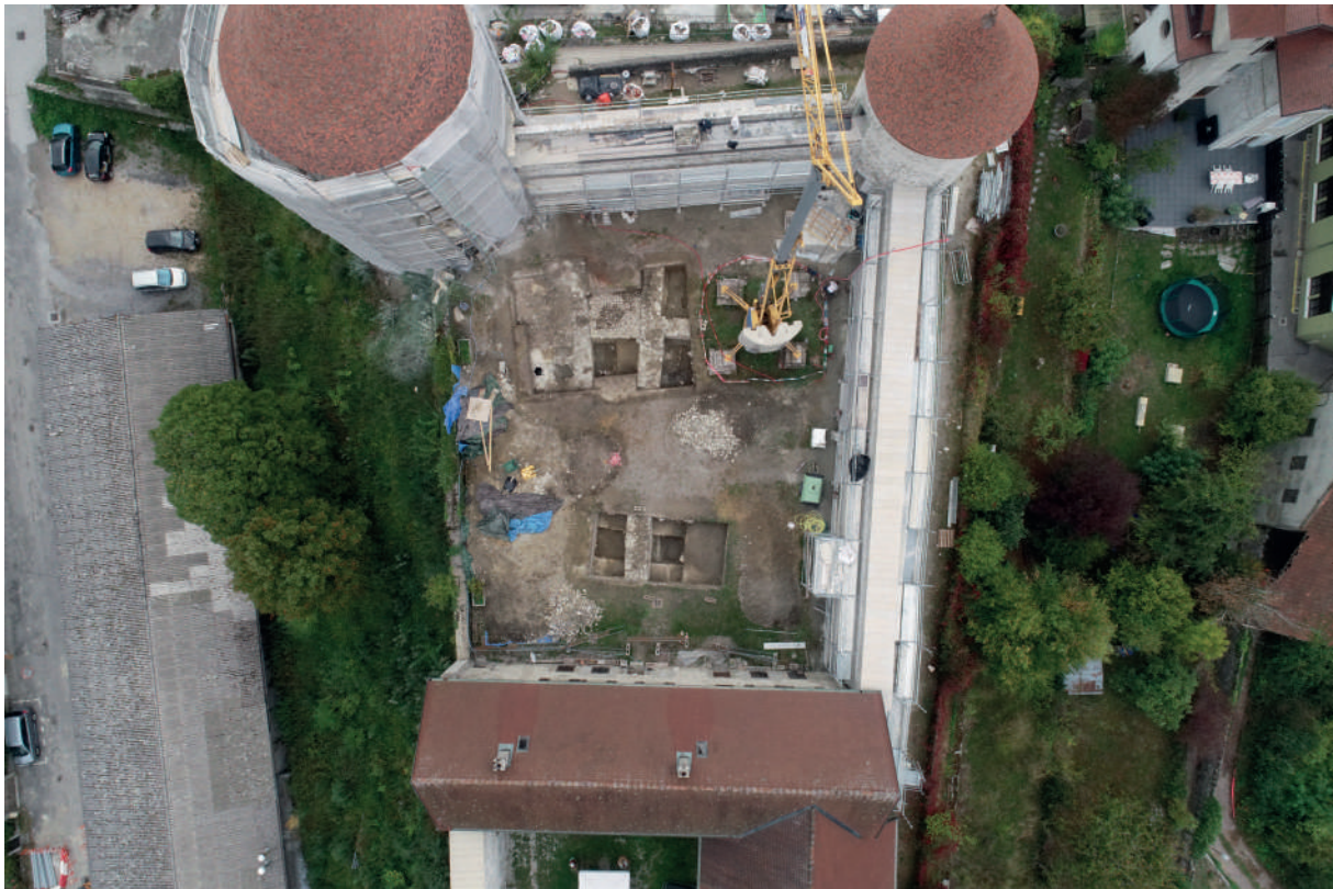
Fig 8 Vue générale des bâtiments découverts en 2018. Cliché : O. Veissière – patrimoine numérique.
