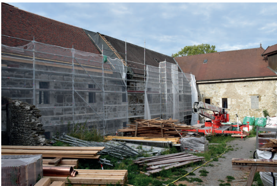
Fig 7 : Bâtiments des prisons. Clichés : Equipe de fouille 2020.
