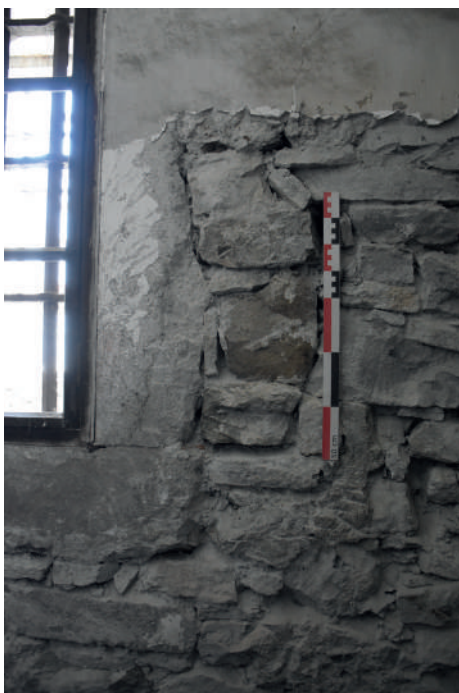
Fig 200 a et b : Insertions des fenêtres FEN 1114 et 1120 dans le mur M 1064 (ES 1.11). Cliché : Équipe de fouille 2020.
