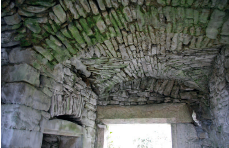
Fig 364 a et b : Voûtes conservée dans la tour escalier. Clichés : Equipe de fouille.
