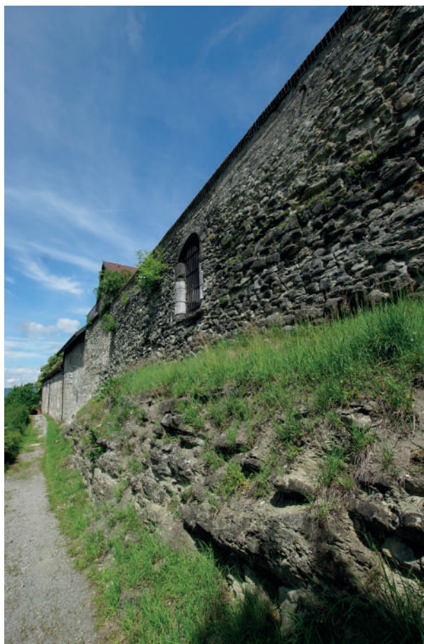
Fig 232 : Courtine sud (M 1064) avant travaux. Cliché : Équipe AVER 2010-2012.
