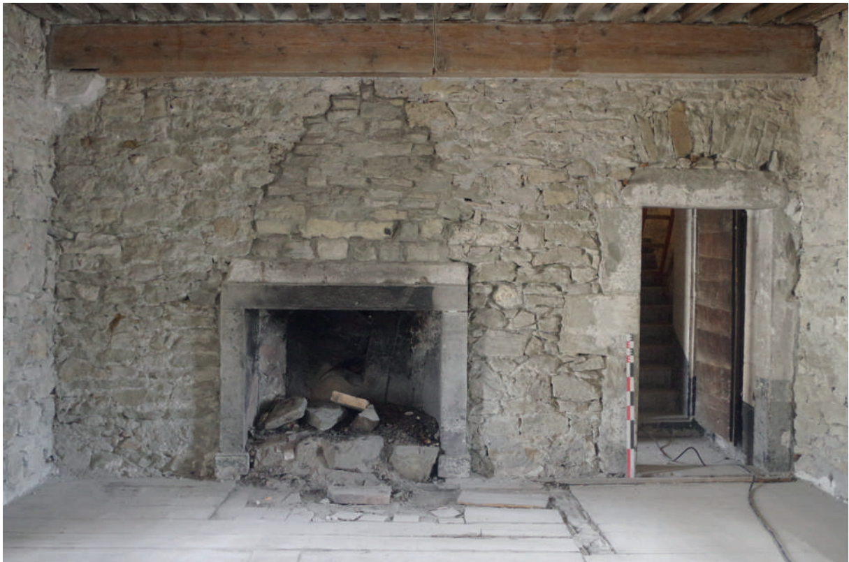
Fig 192 : Parement USC 10223 au sein du mur M 1076. Cliché : Équipe de fouille 2020.
