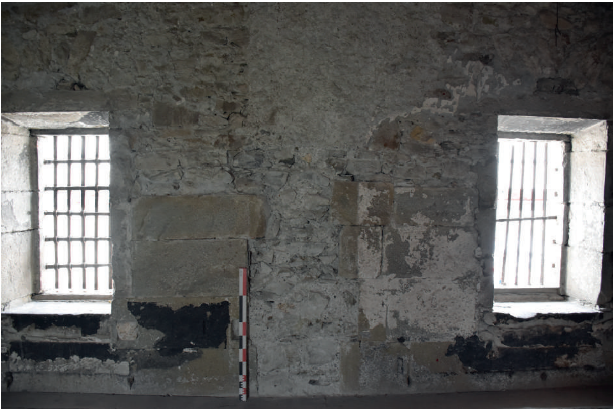
Fig 195 : Reparementage en pierre de taille des cellules de l'aile basse. Cliché : Équipe de fouille 2020.
