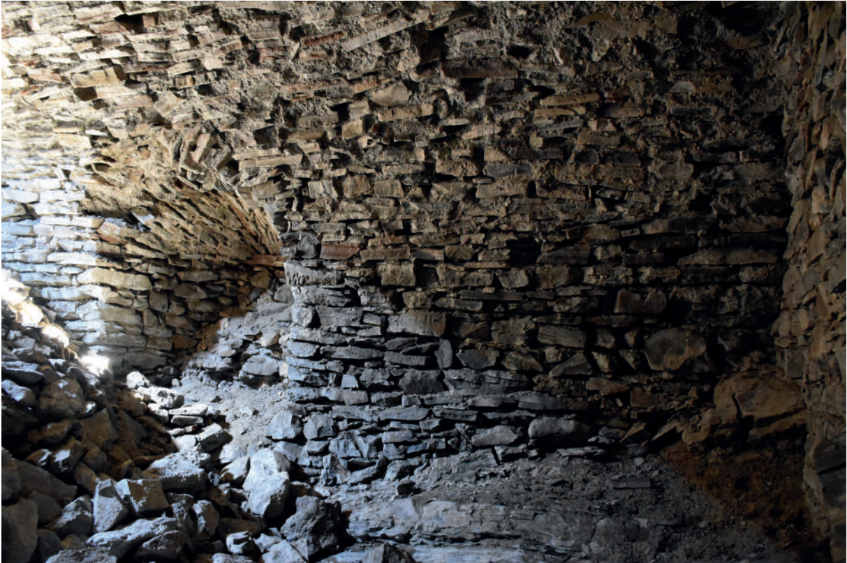
Fig 106 : Parement sud de la courtine M 1029 et ouverture ARC 1032. Cliché : Equipe de fouille 2018.
