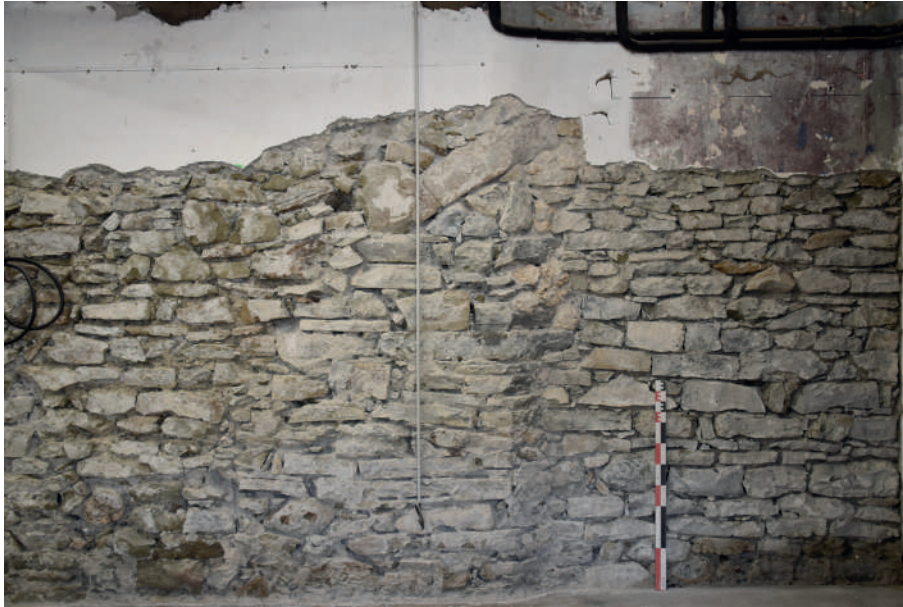
Fig 238 : Reparementages USC 10214 et 10216. Cliché : Équipe de fouille 2020.
