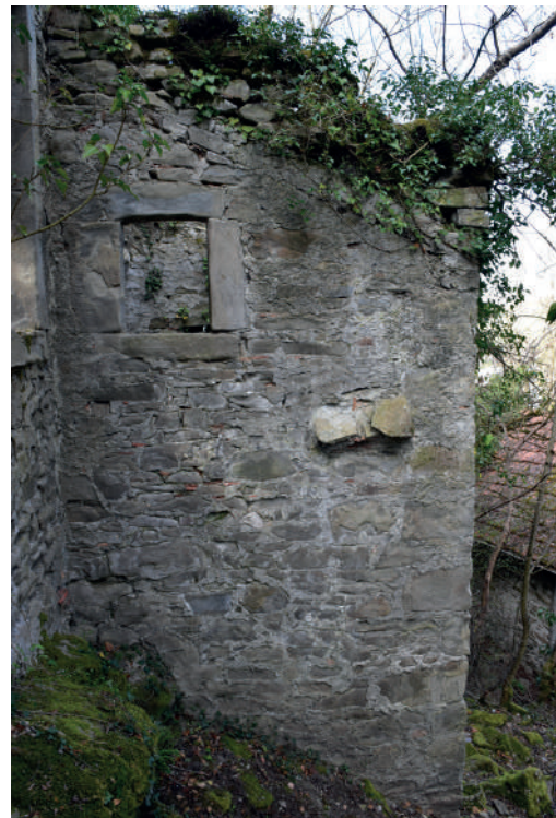
Fig 362 : Départ d'arc sur la tourelle ouest correspond à l'emplacement d'une potentielle poterne. Cliché : Equipe de fouille.
