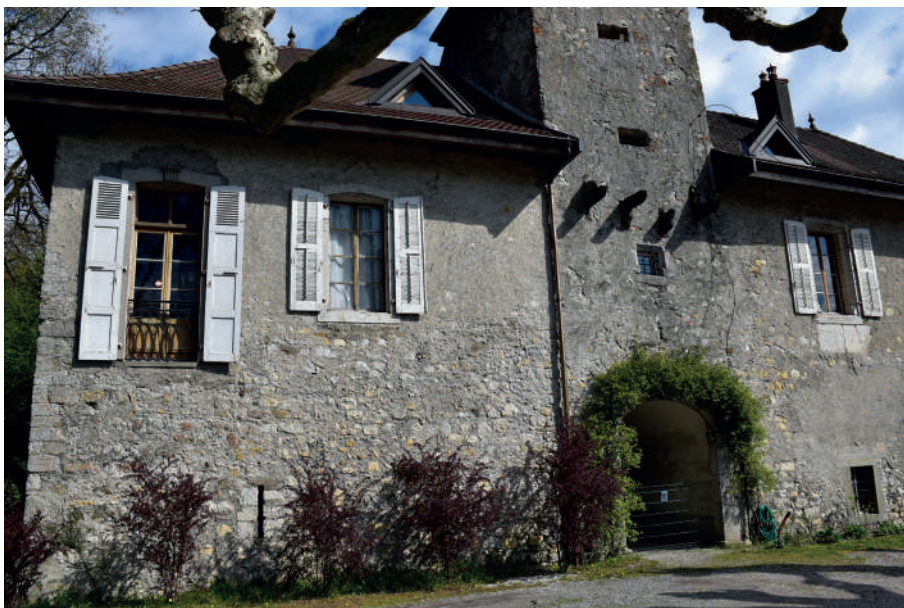
Fig 298 : Façade occidentale. Cliché : Equipe de fouille.
