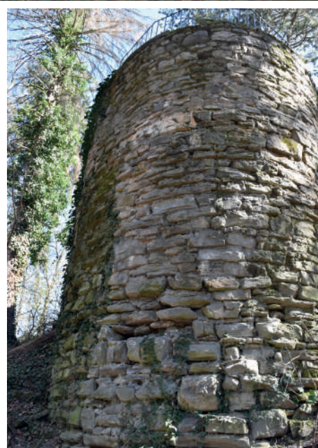
Fig 338 : Appareillage et réfections de la tour nord-ouest. Cliché : Equipe de fouille.
