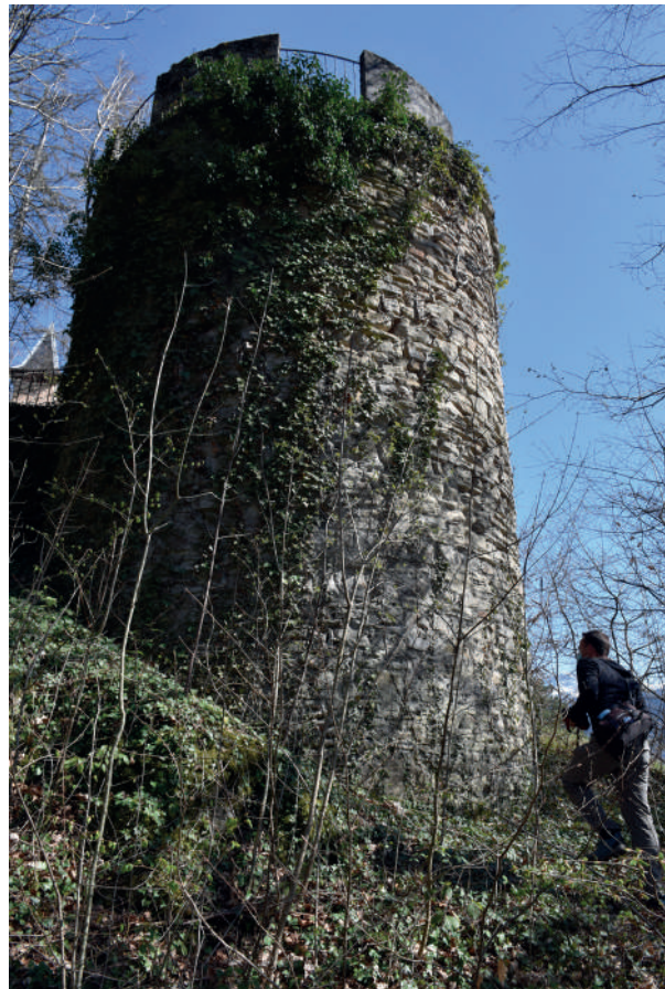
Fig 340 : Parement extérieur de la tour sud-ouest. Cliché : Equipe de fouille.
