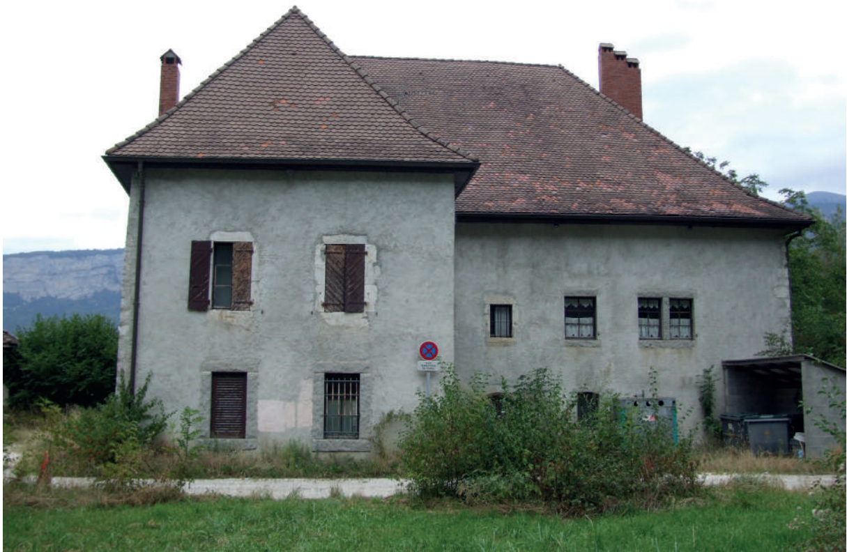
Fig 326 : Vue générale de la maison forte de Pontchy. Cliché : Dr F. Margolliet.
