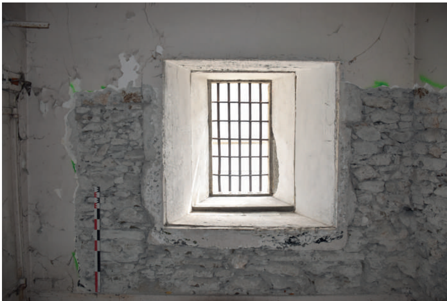
Fig 208 : Parement USC 10267 et fenêtre FEN 1089. Cliché : Équipe de fouille 2020.
