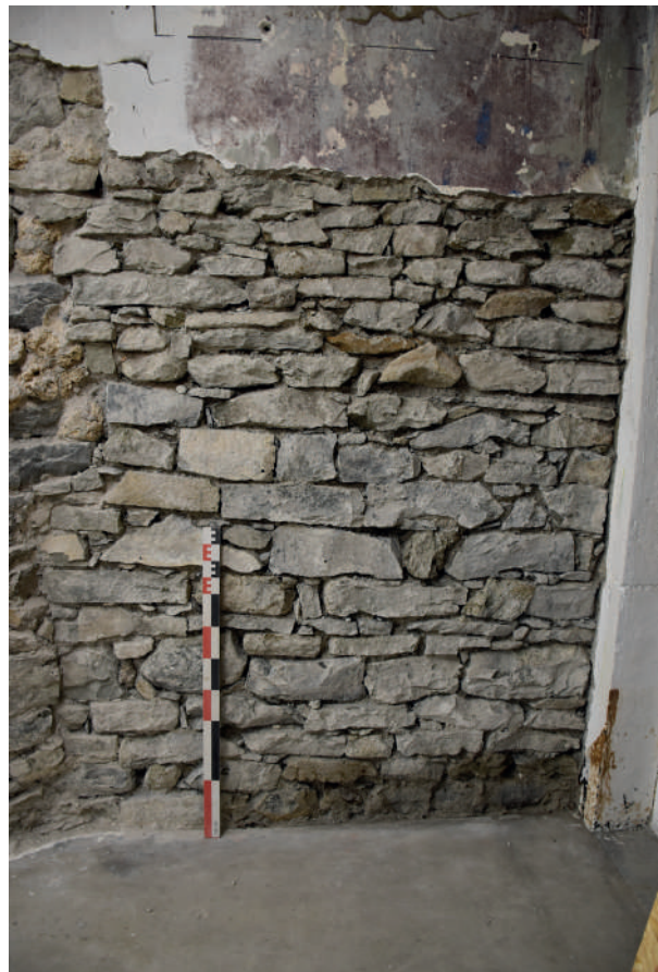
Fig 239 : Buchage entre les reparationtages USC 10214 et 10216 et appareillage de ce dernier. Clichés : Équipe de fouille 2020.
