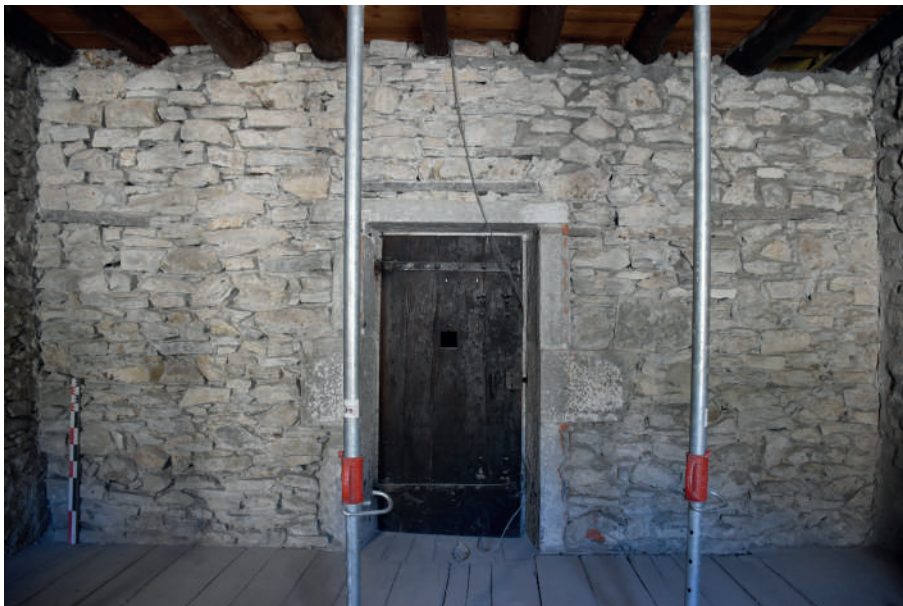
Fig 227 : Vue générale du mur M 1144 depuis l'espace ES 1.33. Cliché : Équipe de fouille 2020.
