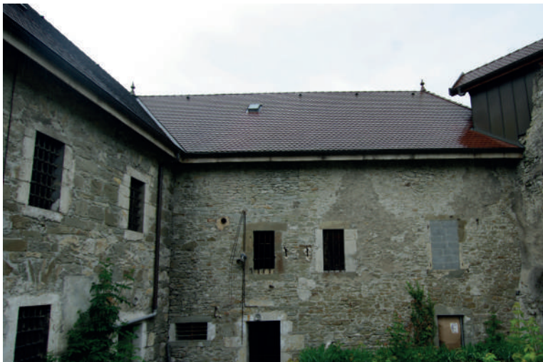
Fig 57 : Bâtiment ouest des prisons avant travaux. Cliché : Équipe AVER 2010-2012.
