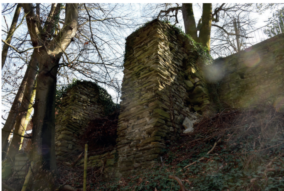
Fig 337 : Contreforts septentrionaux. Cliché : Equipe de fouille.
