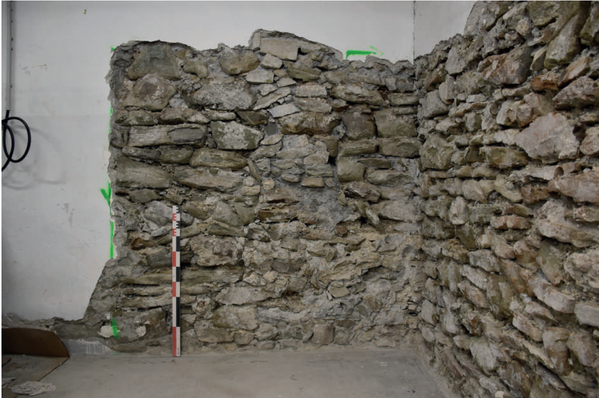
Fig 233 : Parement septentrional de la courtine sud (M 1064). Cliché : Équipe de fouille 2020.
