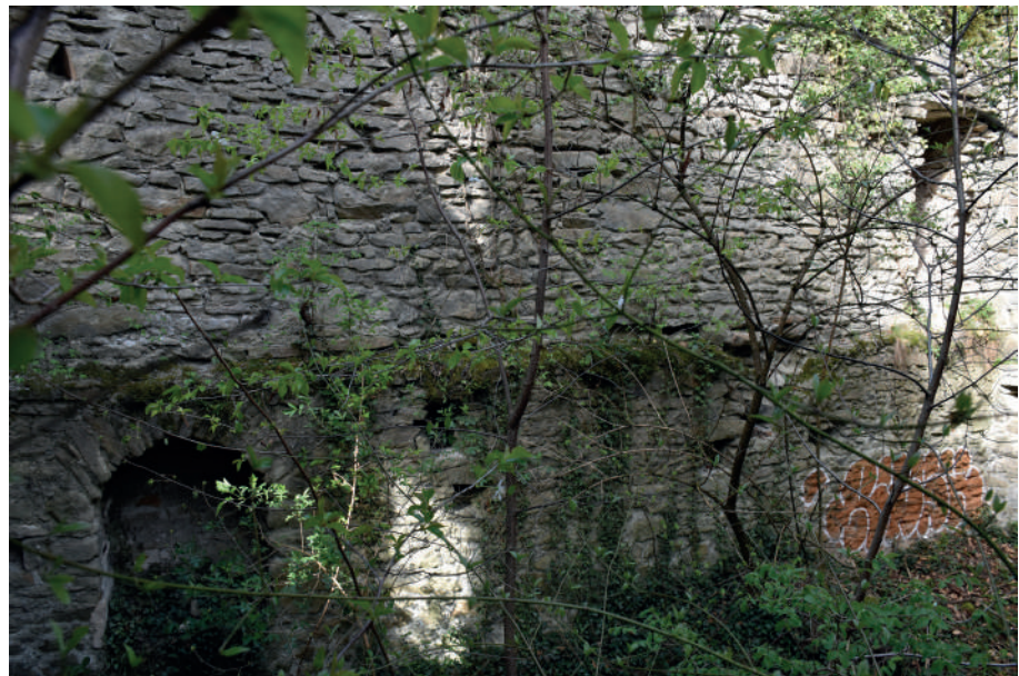
Fig 375 : Mur pignon sud. Cliché : Equipe de fouille.
