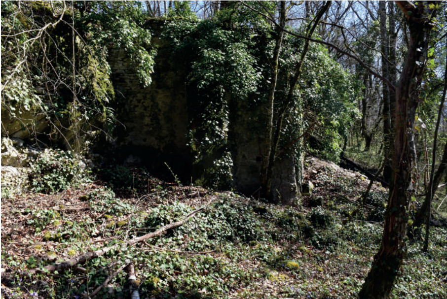
Fig 344 : Exemple de mur de terrasse devant Asnières. Cliché : Equipe de fouille.
