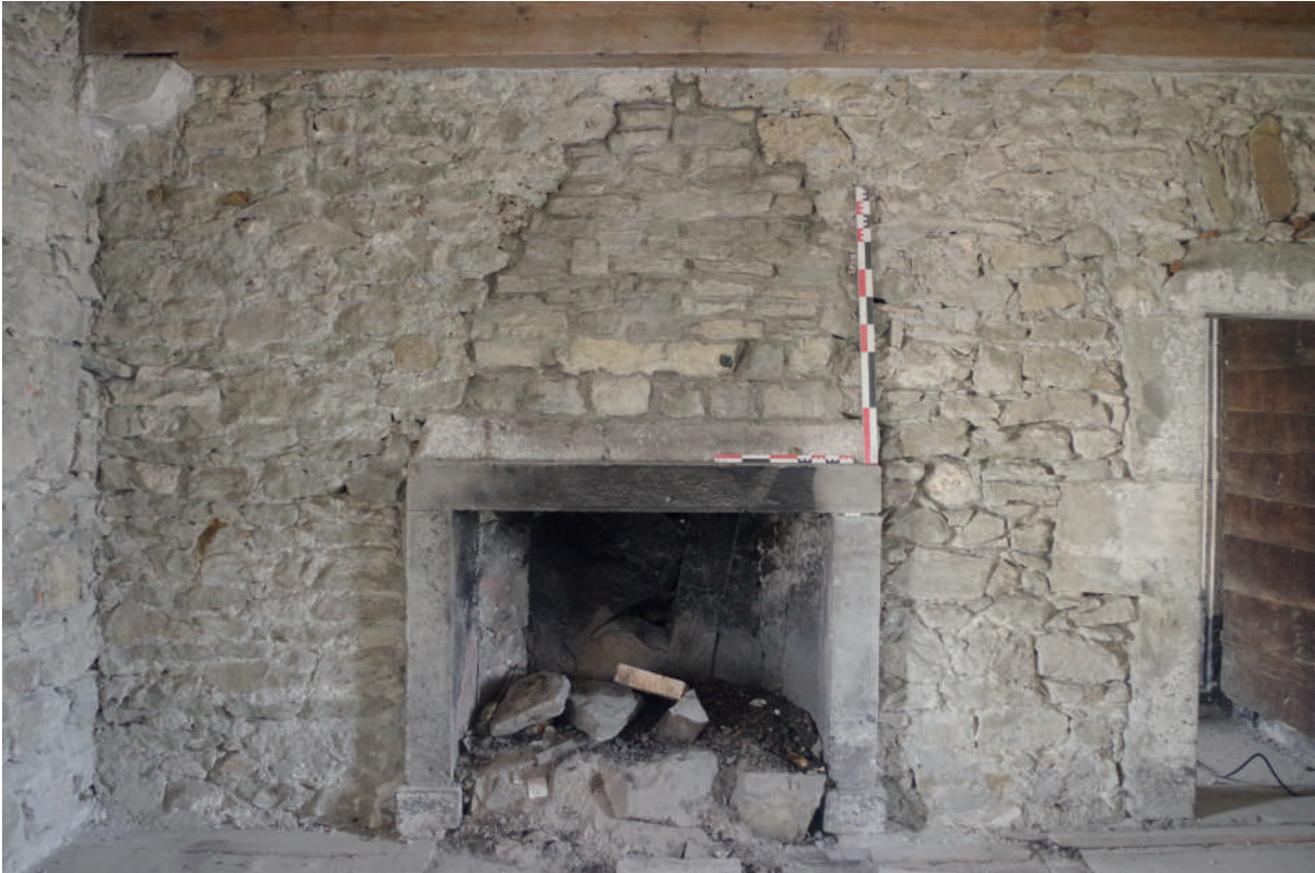
Fig 205 : Cheminée CHE 1078 (ES 1.30). Cliché : Équipe de fouille 2020.
