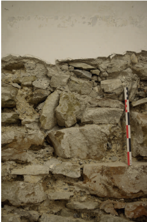
Fig 240 a et b : Exemples de bouchage d'anciens trous de poutre au sein du mur M 1063. Clichés : Équipe de fouille 2020.
