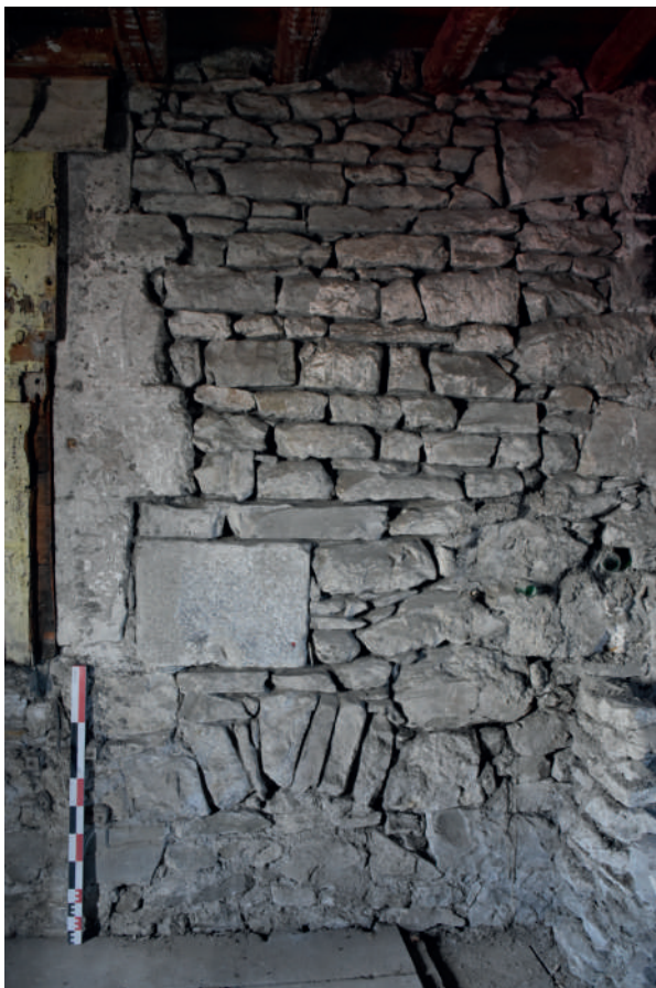
Fig 166 : Remaillage USC 10394 présent sur le mur M 1052. Équipe de fouille 2020.
