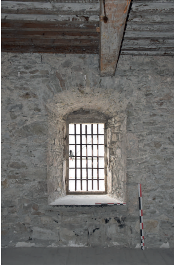
Fig 182 : Fenêtre FEN 1079. Cliché : Équipe de fouille 2020.
