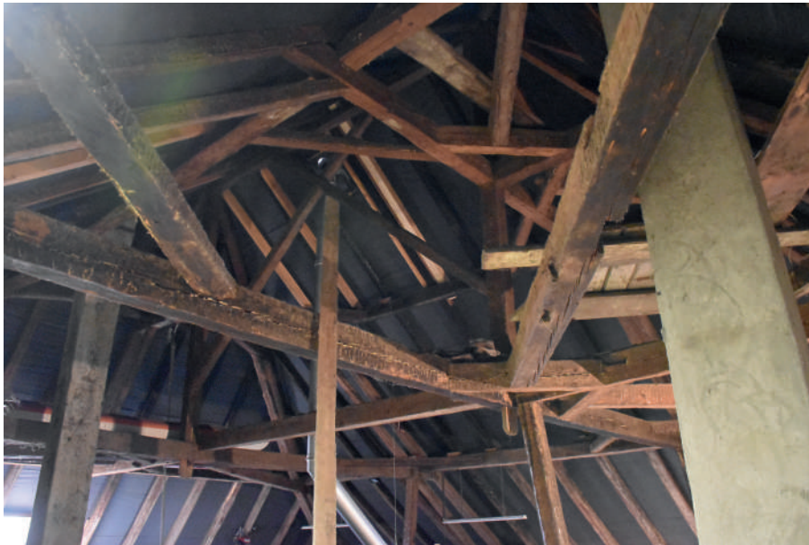
Fig 324 : Charpente de la maison du Maney.
