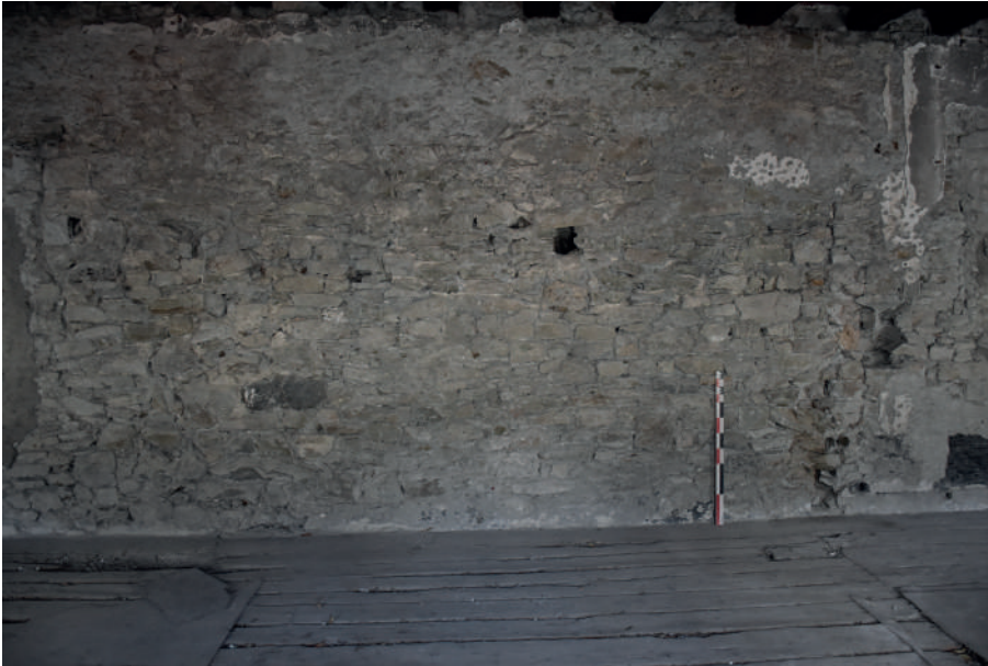
Fig 197 : Reprise en sous-œuvre USC 10296 en partie basse du mur M 1064 dans l'espace ES 1.29. Cliché : Équipe de fouille 2020.
