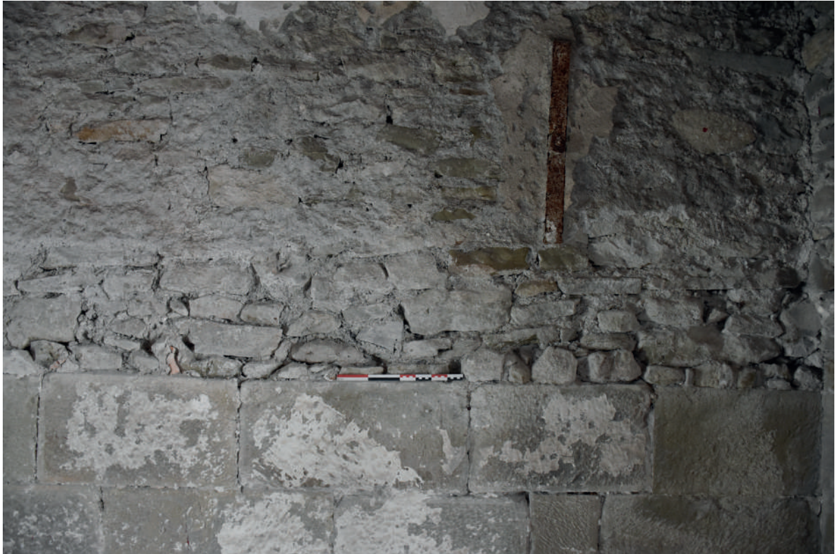
Fig 191 : Parement d'origine USC 10265 du mur M 1086. Cliché : Équipe de fouille 2020.
