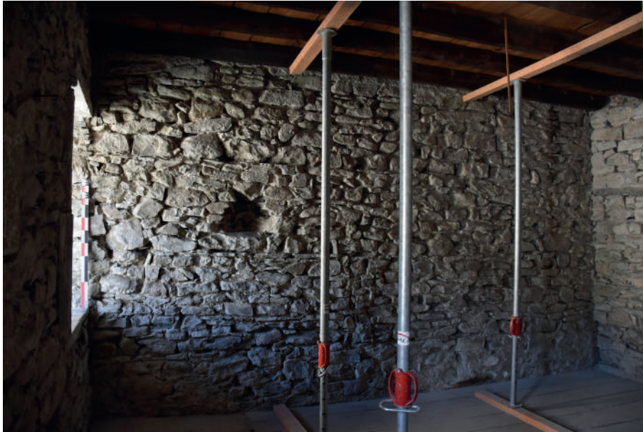
Fig 226 : Parement USC 10414 du mur M 1143. Cliché : Équipe de fouille 2020.
