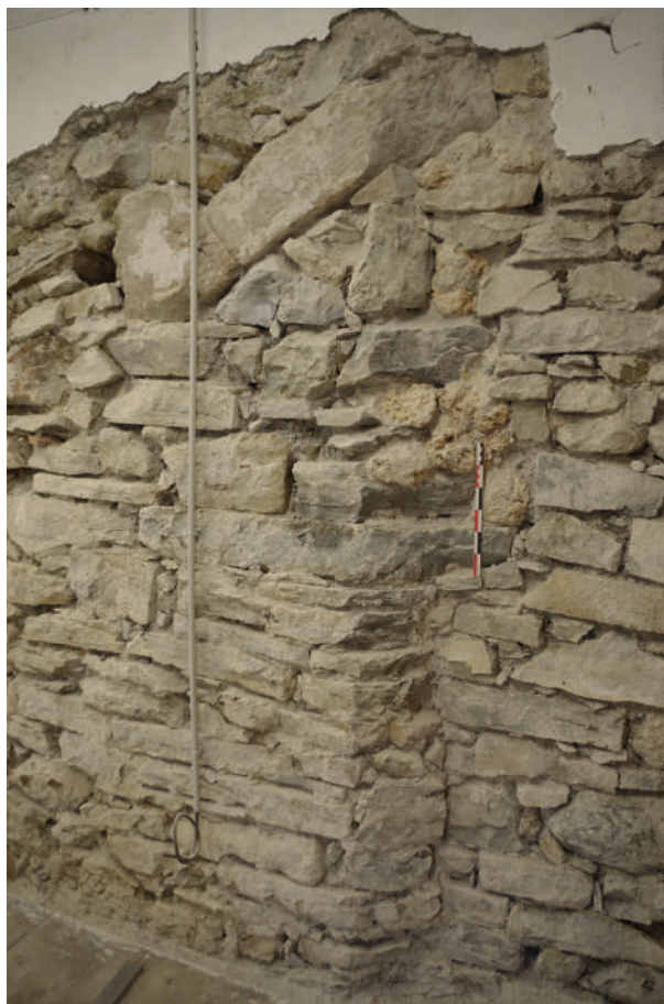
Fig 242 : Placages USC 10215, 10217 et 10219. Cliché : Équipe de fouille 2020.
