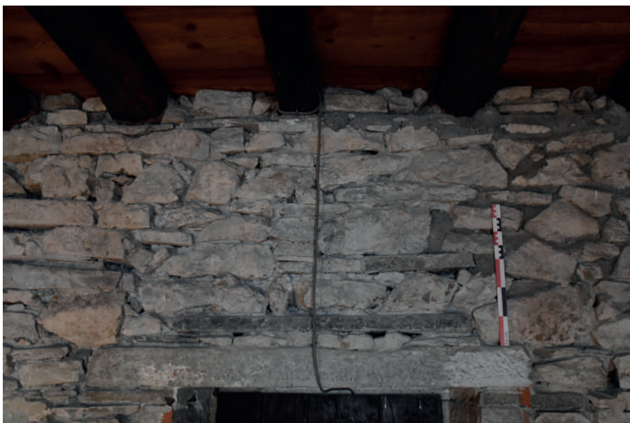
Fig 231 : Reprise de la partie haute de la porte POR 1146. Cliché : Équipe de fouille 2020.
