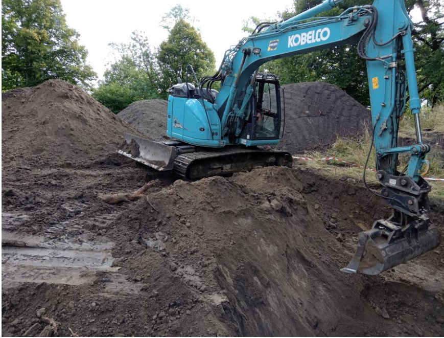
Fig. 6: Décapage mécanique initial. Cliché: Equipe de fouille.
