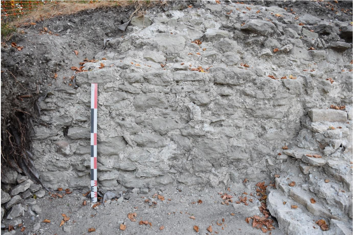
Fig. 12: Mur M 1002 - parement sud. Cliché: Equipe de fouille.
