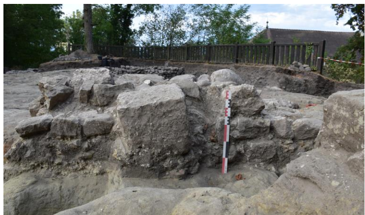
Fig. 61: Parement nord de M 1323. Cliché: Equipe de fouille.
