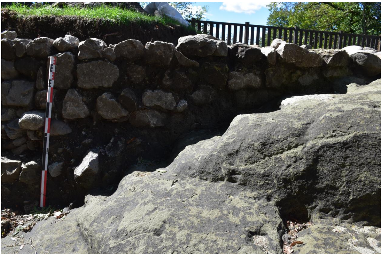
Fig. 43: Escalier ESC 1365. Cliché: Equipe de fouille.
