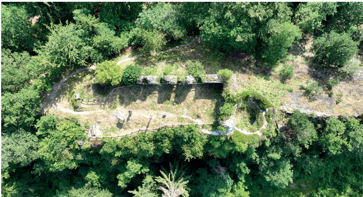
Fig. 24 : Vue d'ensemble du château avant l'opération archéologique. Crédit : Equipe de fouille.
