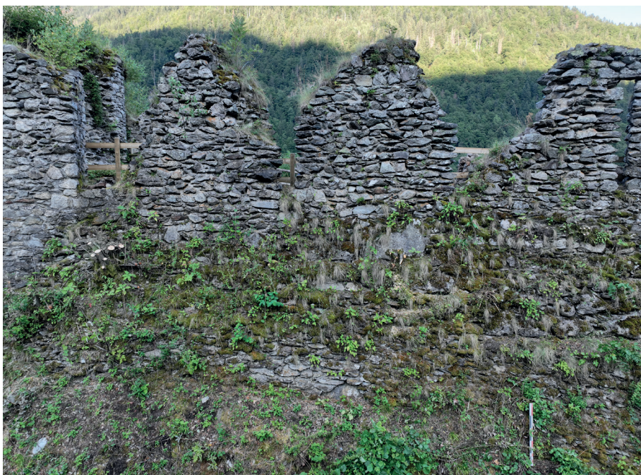
Fig. 51 : Parement inférieur du mur F1, correspondant vraisemblablement à une maçonnerie antérieure. Crédit : Equipe de fouille.
