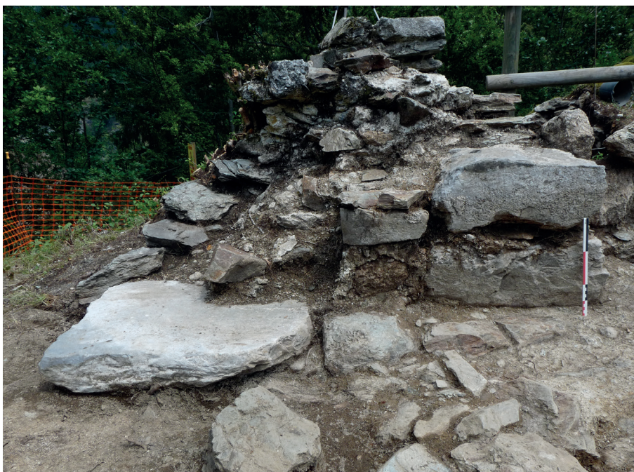
Fig. 48 : Piédroit et seuil de la porte d'accès située dans le mur F5. Crédit : Equipe de fouille.
