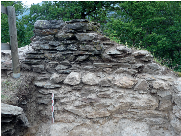
Fig. 44 : Ressaut du mur F5 . Crédit : Equipe de fouille.
