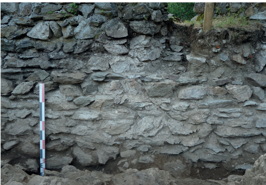
Fig. 43 : Ressaut du mur F1. Crédit : Equipe de fouille.
