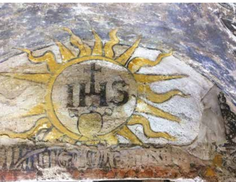
Fig. 16 : Chapelle des Rubins, détail du nettoyage en cours avec un film d'agar, mur nord. Le film d'agar a été apposé sur le fond blanc à droite de la Gloire, il est en cours de dépose.
