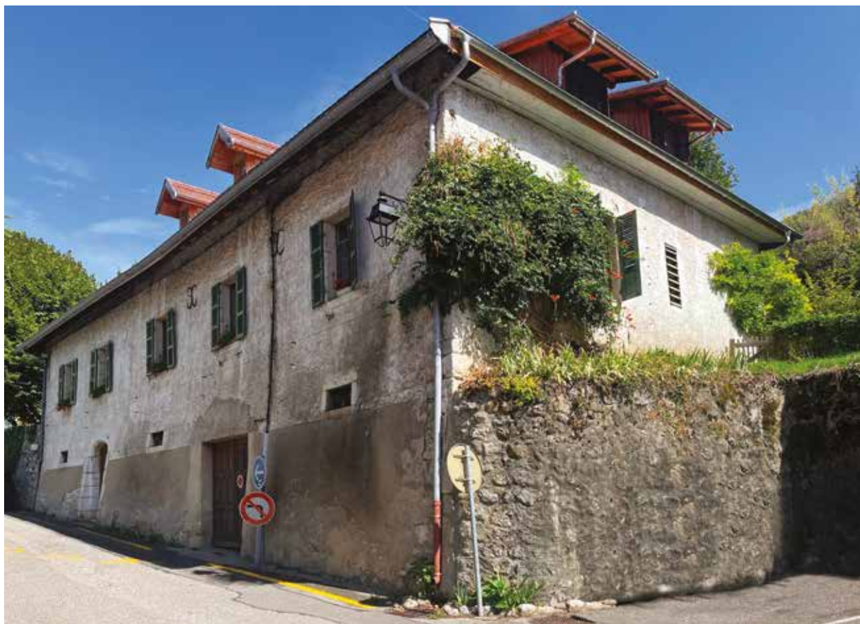
Fig. 6 : Vue d'un cellier identifié à Talloires © S. Mahfoudi - Département de la Haute-Savoie.
