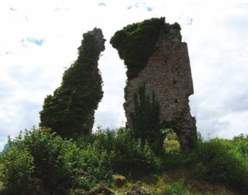
Fig.7 : Mur nord du logis et détail du parement sud et de l'arrachement. © Auriane Lorphelin - 2018.
