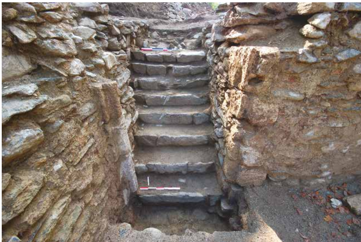
Fig.21 : Escalier d'accès aux caves de la tour nord © L. D'Agostino.
