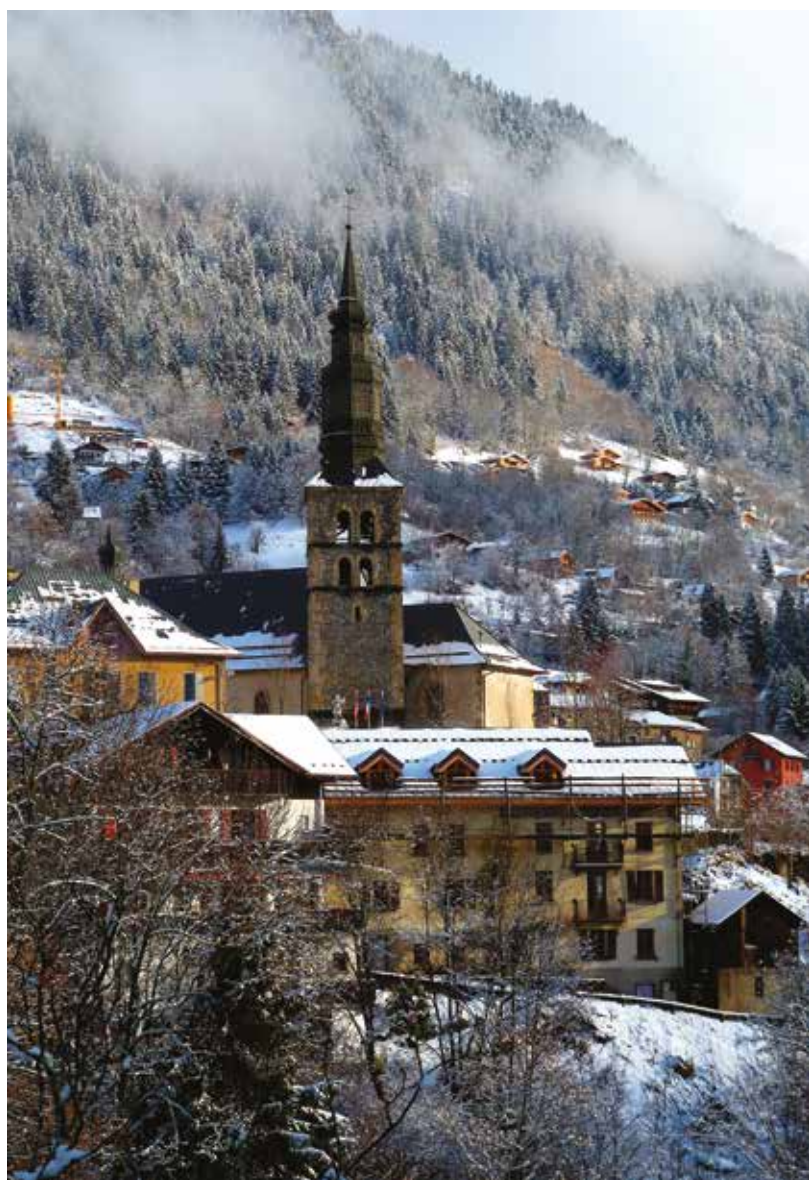
Fig.1 : Le clocher en 2016 avant sa restauration, © Siren-Com CC-BY-SA.
