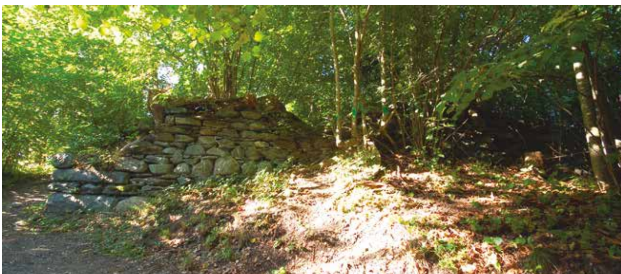
Fig.3 : Vestiges maçonnés de la tour nord dans la forêt avant le début des fouilles © L. D'Agostino.
