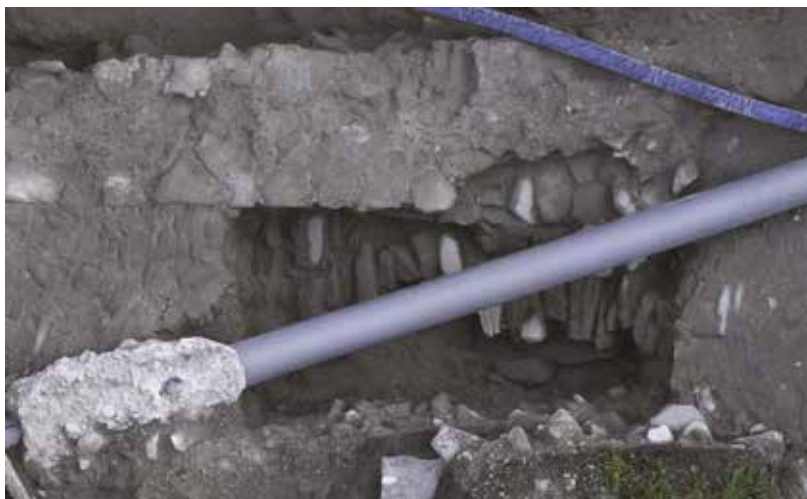
Fig. 16 : Ancien pavage présent sous le sol supérieur dans la cour ouest © L. Benoit - Département de la Haute-Savoie.
