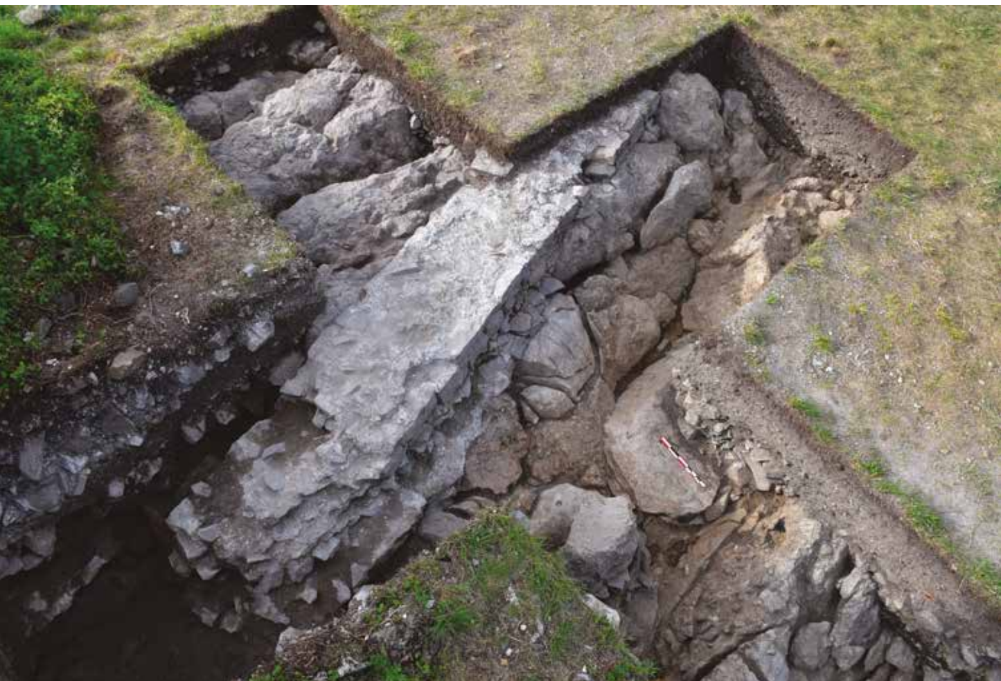
Fig.9 : Mur oriental du logis – Fin de fouille 2019. © Auriane Lorphelin – 2019.
