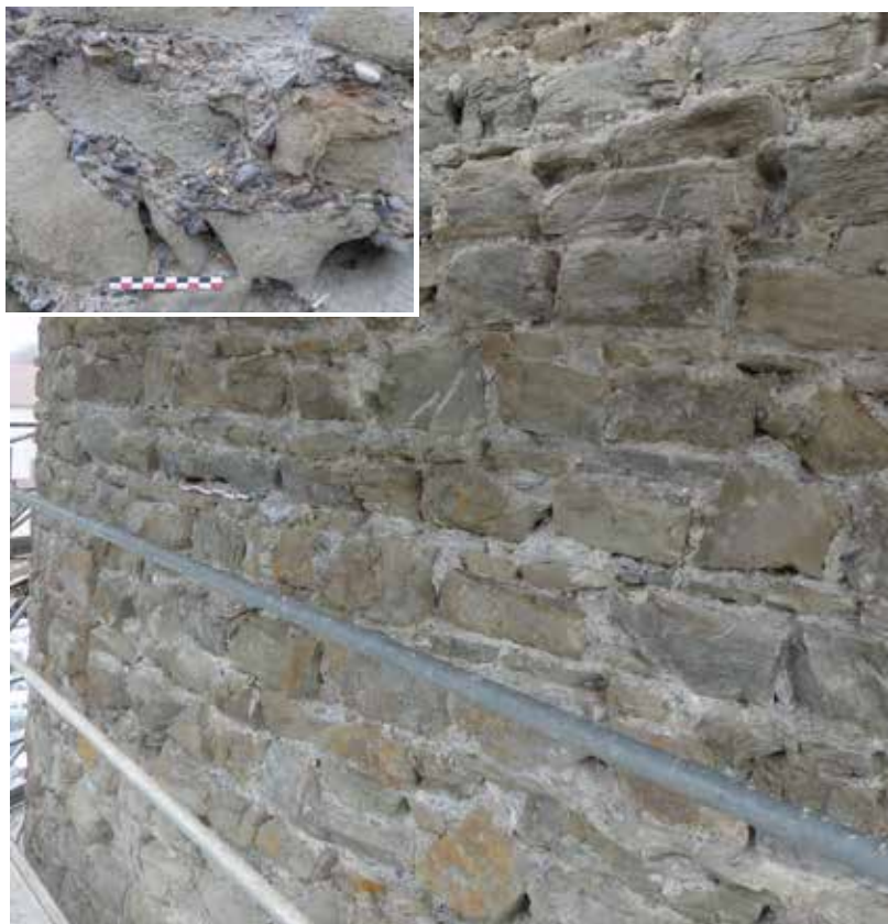
Fig. 5 : Parement de la tour nord-est et détail sur le mortier graveleux utilisé dans les maçonneries de la seconde moitié du XIII e siècle © S. Bocquet - Inrap.
