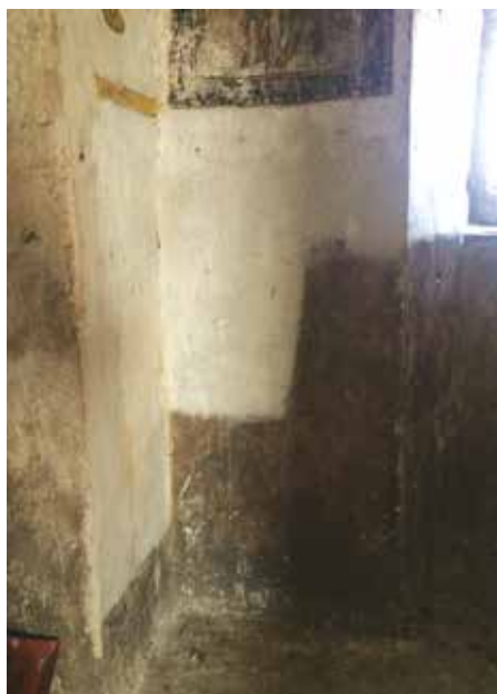
Fig. 17 et 18 : Chapelle des Rubins, nettoyage en cours des peintures murales avec un film d'agar, paroi sud © S. Haberer, 2020.
