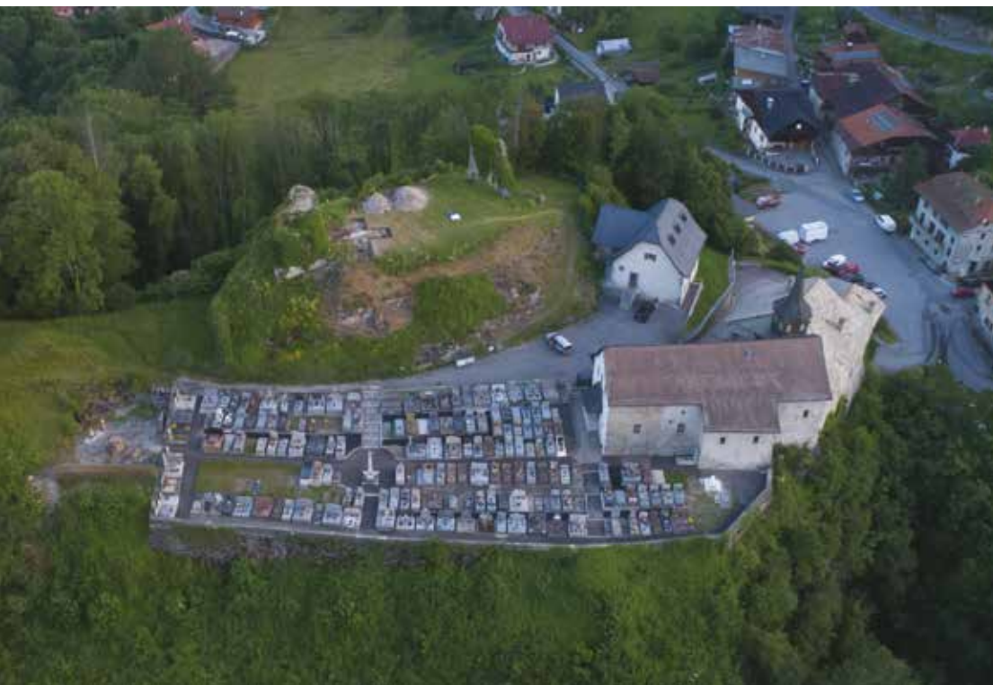
Fig.3 : Église Saint-Martin de Châtillon-sur-Cluses.
