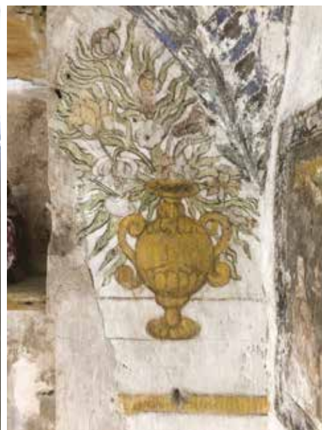
Fig. 19 : Chapelle des Rubins, finalisation du nettoyage des peintures murales avec un film d'agar, paroi ouest. © S. Haberer, 2020.
