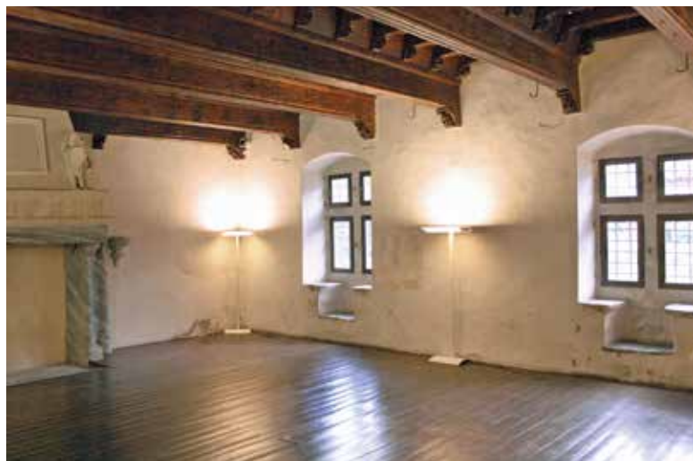
Fig. 13 - Le plafond avec les consoles sculptées de la grande salle © M. Cortelazzo - Région autonome Vallée d'Aoste.
