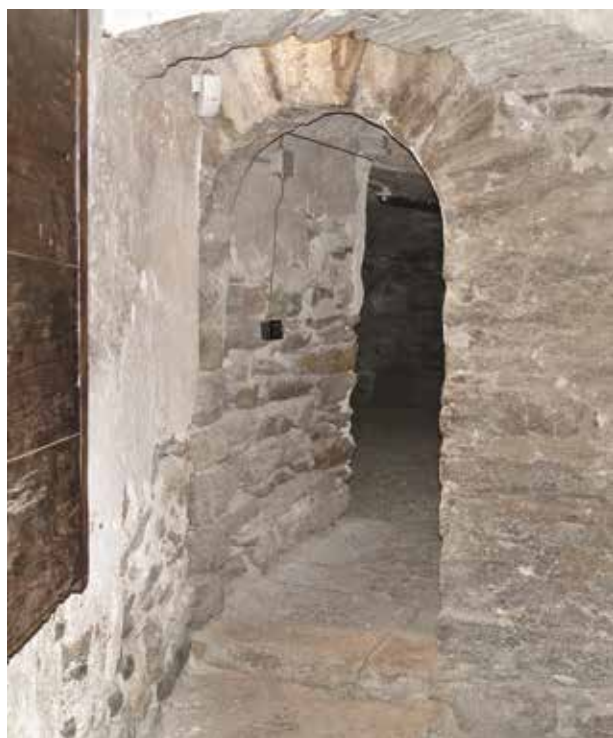
Fig. 5 - La porte d'accès au premier étage de la tour © F. Accordi - Région autonome Vallée d'Aoste.
