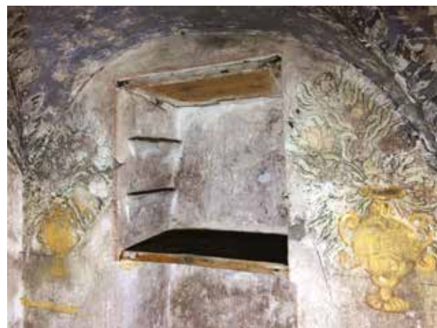
Fig. 6 : Chapelle des Rubins, mur ouest. © S. Haberer, 2019.
