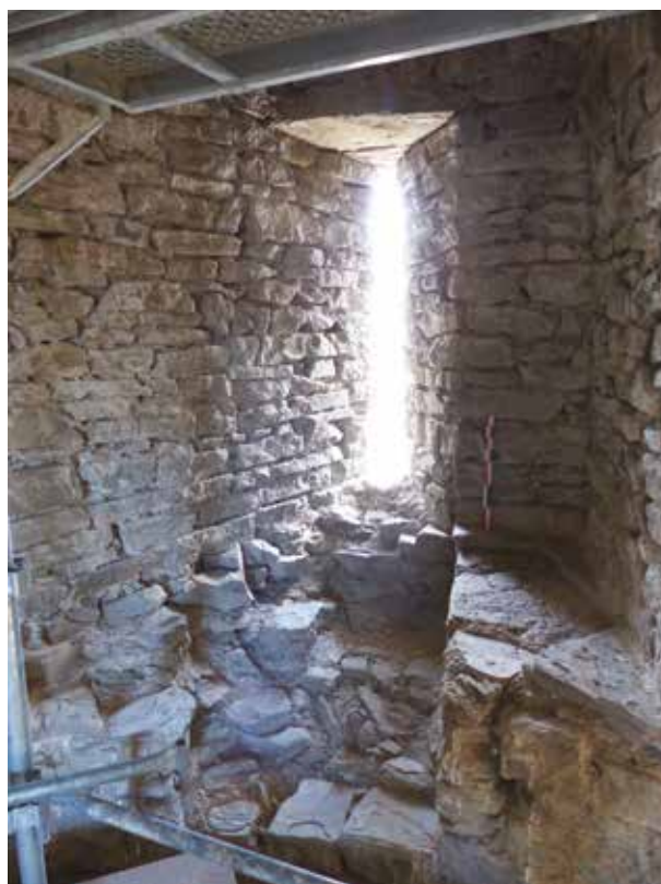
Fig. 10 : Archère sud-est à coussièges du niveau 3 de la tour nord-est © S. Bocquet - Inrap.
