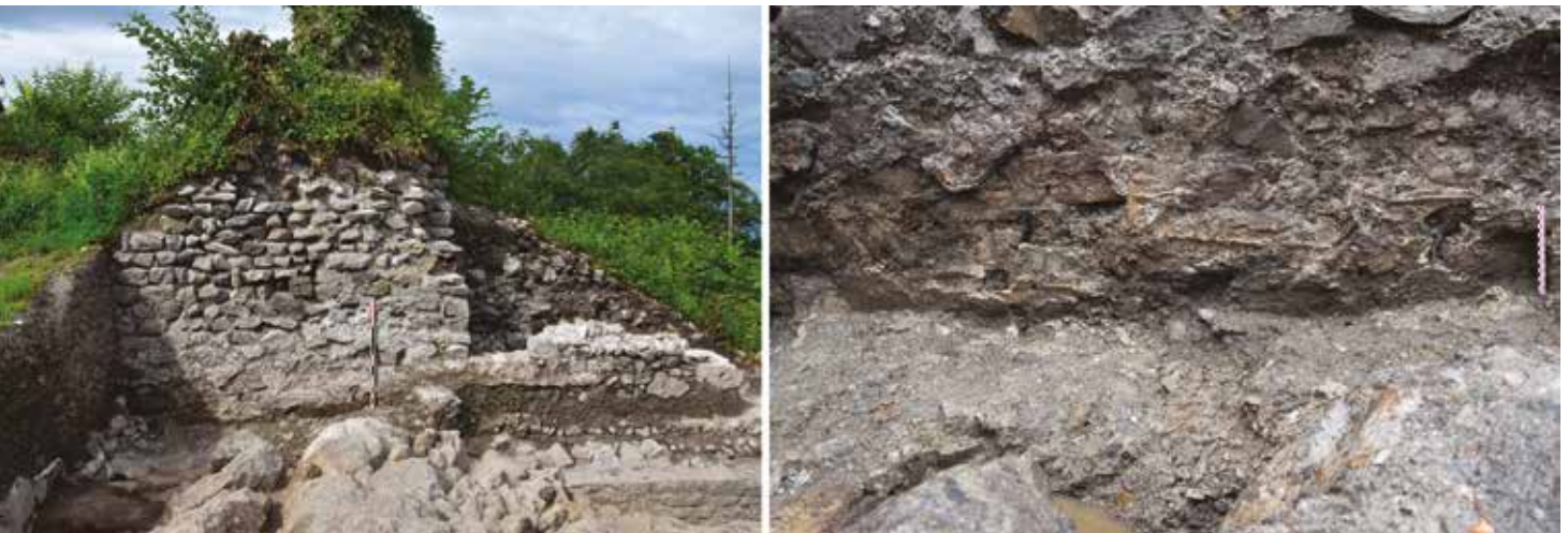
Fig. 12 : La tour maîtresse et détail des négatifs dans l'enduit. © Auriane Lorphelin - 2021.
