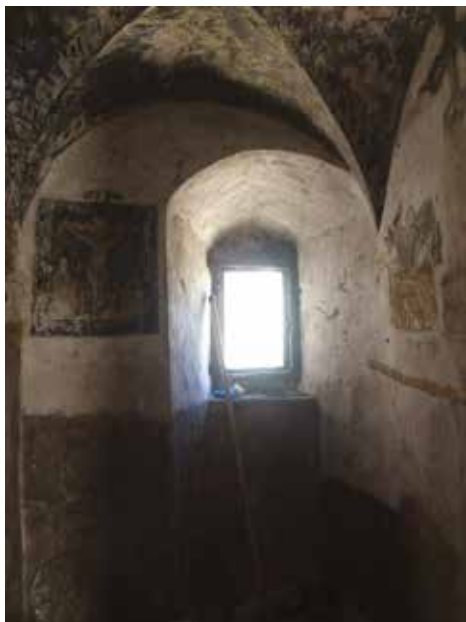
Fig. 17 et 18 : Chapelle des Rubins, nettoyage en cours des peintures murales avec un film d'agar, paroi sud © S. Haberer, 2020.
