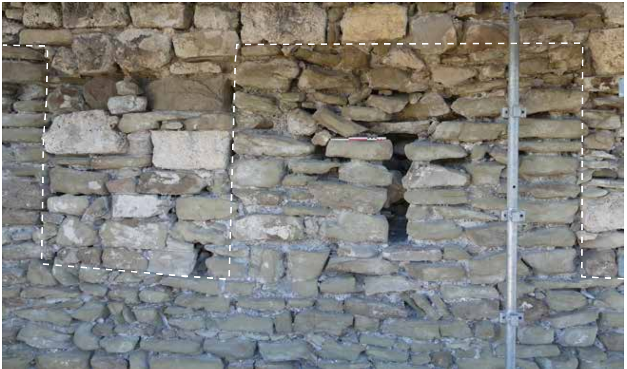
Fig. 6 : Portion du crénelage de la partie centrale de la courtine sud (2020) © S. Bocquet - Inrap.
