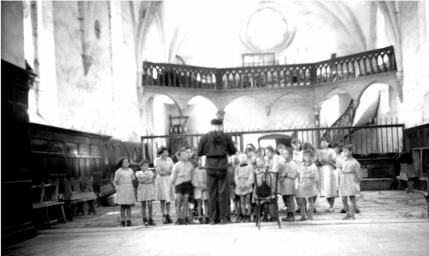
Fig.9 : Photographie du début du XX e siècle sur laquelle apparaissent des vestiges du chœur des moniales chartreuses - tribune et barrière liturgique secondaire entre le chœur des moniales professes et converses © Association des anciens de Mélan.
