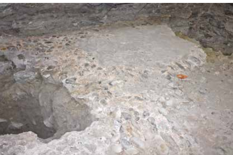
Fig. 8 - Le sol en mortier découvert à l'étage inférieur de la tour © G. Sartorio - Région autonome Vallée d'Aoste.
