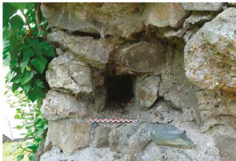
Fig.8 : Tableau et trou de poutre visibles dans le mur nord du logis. © Auriane Lorphelin - 2018.
