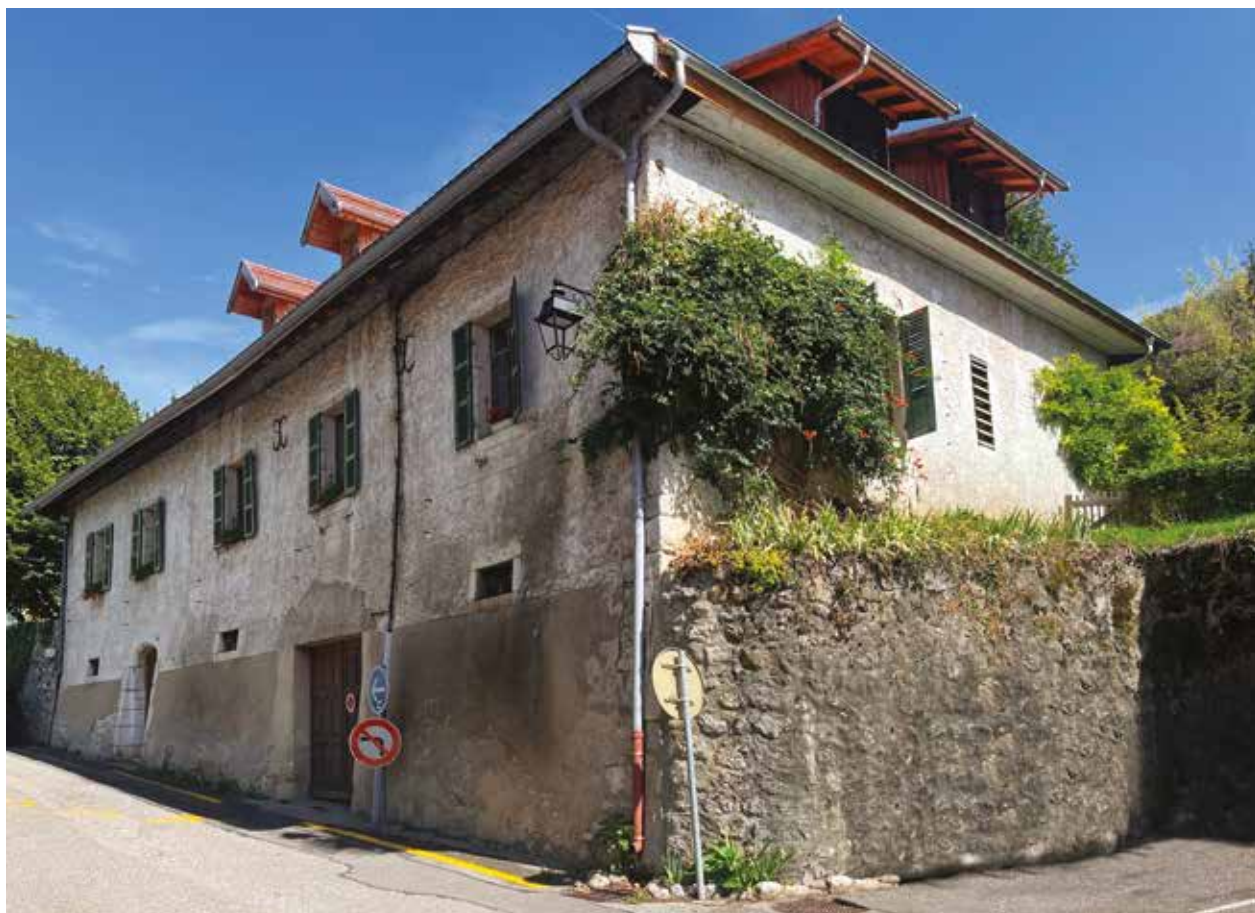
Fig. 6 : Vue d'un cellier identifié à Talloires © S. Mahfoudi - Département de la Haute-Savoie.
