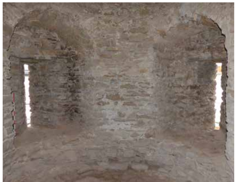
Fig. 12 : Archères à niche ouest et est du niveau 2 (rez-de-chaussée actuel) de la tour sud-est © S. Bocquet - Inrap.
