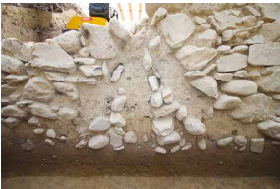
Fig.9 : Détail de l'élévation de la façade ouest: on voit les négatifs de la poutre verticale et des deux jambes de force qui reposent sur une semelle © M. Joguïn Regelin - SA Genève.
