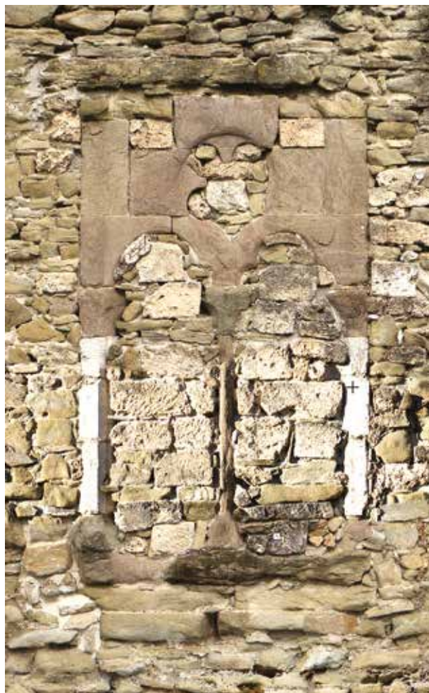
Fig. 24 : Orthophotographie de la baie ouest dans la courtine sud (mars 2017) © 3D Scan Map - Cabestan - Inrap.
