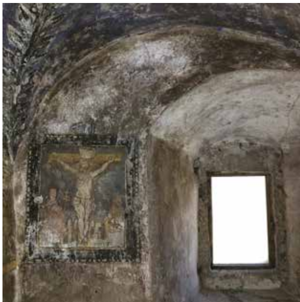
Fig. 7 : Chapelle des Rubins, mur sud. © S. Haberer, 2019
