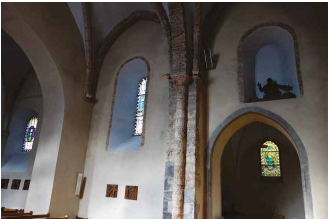
Fig.5 : Mur nord de la nef de l'église des chanoines, ancien mur de séparation (à gauche) © S. Bochaton.
