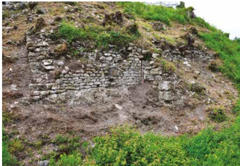
Fig. 5 : Vestiges maçonnés dans les pentes du château. © Auriane Lorphelin - 2019.
