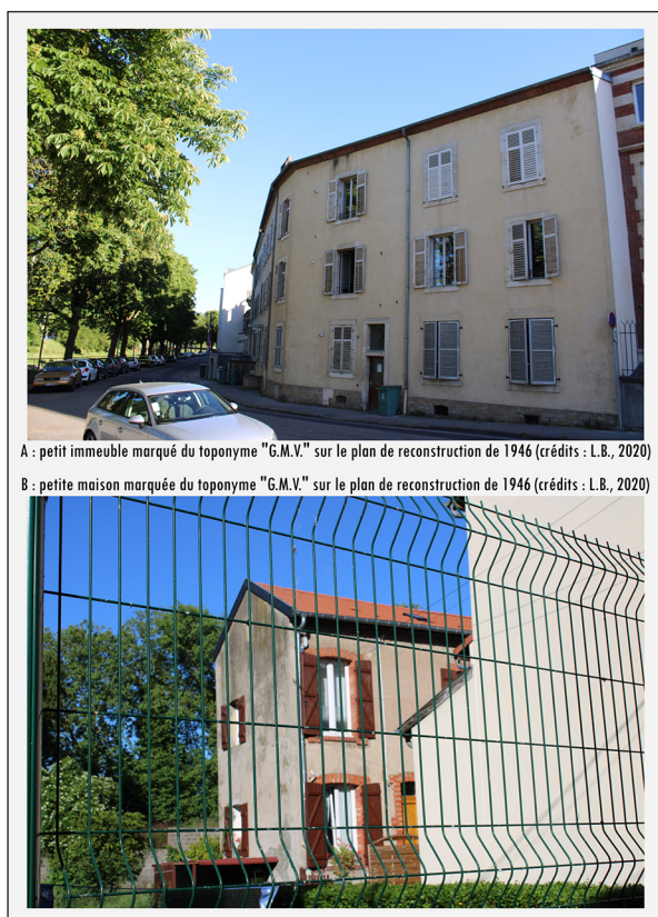
Figure 3. Vues de logements marqués du toponyme « G.M.V. » sur le plan masse de 1946 (crédits : Léopold Barbier, 2023, d'après Léopold Barbier, 2020)
