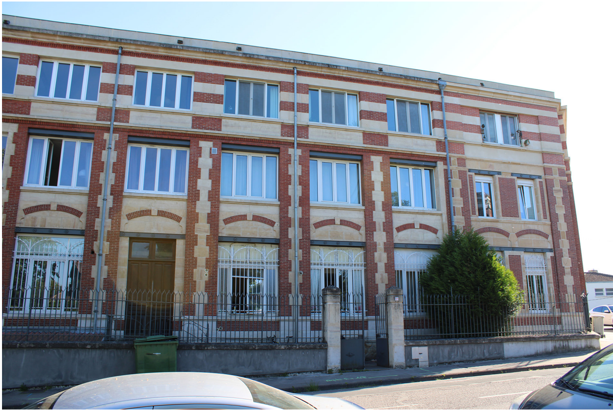
Photo 5. Vue des anciens bureaux de l'entreprise Vilgrain, transformés en appartements. L'esthétique du bâtiment associe des matériaux de l'ère industrielle : brique, verre, fonte (crédits : Léopold Barbier, 2020)
