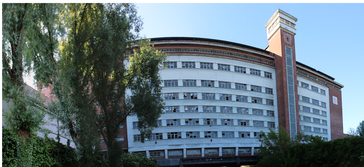
Photo 1. Vue du bâtiment-pont de neuf étages (en grand angle), aujourd'hui coquille vide en cours de dégradation (crédits : Léopold Barbier, 2020)
