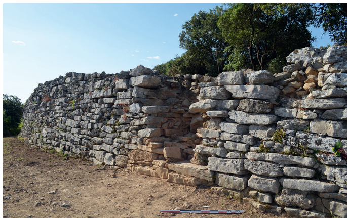
■ 37 Le parement externe en grand appareil de la courtine C (zone 802), vu du nord-ouest (E. Baudouin).
