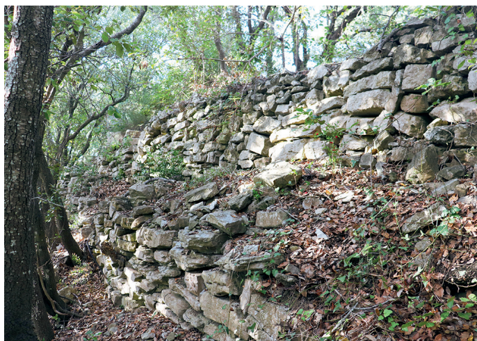
■ 146 La courtine accrochée à la bordure méridionale du plateau du Castellás, en amont de la « muraille intérieure ». Elle appartient vraisemblablement à l'enceinte primitive (A. Beylier).
