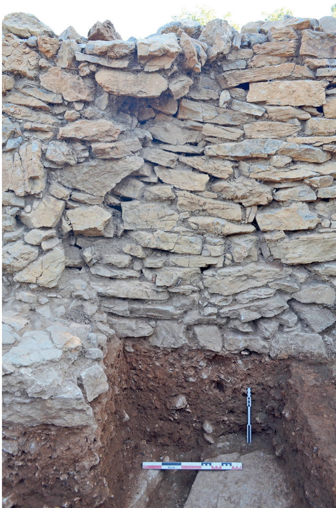
■ 16 Vue en coupe, depuis le sud, des remblais de nivellement installés sur le substrat rocheux avant l'édification de la courtine B (J. Le Bomin).
