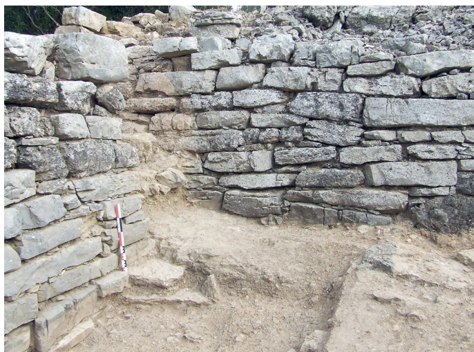
■ 40 L'aménagement du substrat rocheux en avant de la poterne, vu du nord (A. Beylier).
