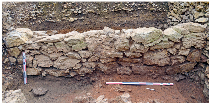
■ 122 L'élevation du mur de séparation des Unités 3 et 4 (MR801216), vue du nord-est (M. Mura).
