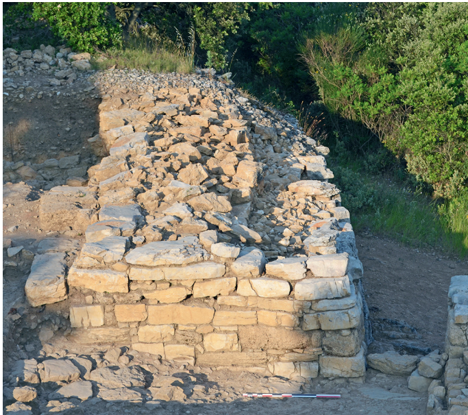
■ 68 Vue, depuis le nord-est, de la cortine A dans son état final (A. Beylier).
