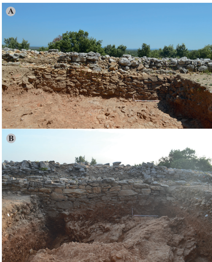
■ 20 Vues depuis le sud de l'élévation du parement interne de l'enceinte primitive en zone 802.
