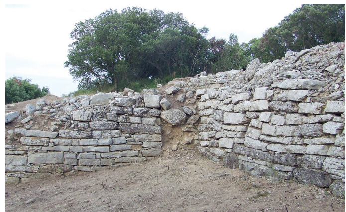
■ 9 La poterne nord-ouest protégée dans le redan de l'enceinte (zone 801), vue de l'ouest au démarrage des fouilles (A. Beylier).
