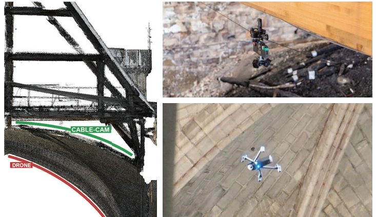
Figure 1. Instrumentation utilisée pour la numérisation de l'intrados et de l'extrados des voûtes de Notre-Dame de Paris après l'incendie.
