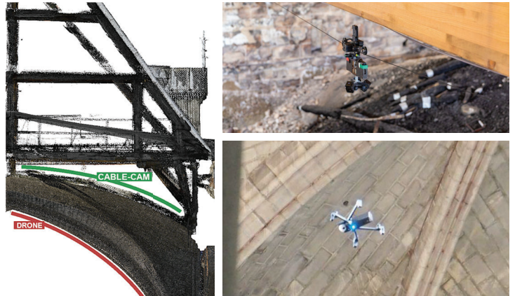
Figure 1. Instrumentation utilisée pour la numérisation de l'intrados et de l'extrados des voûtes de Notre-Dame de Paris après l'incendie.
