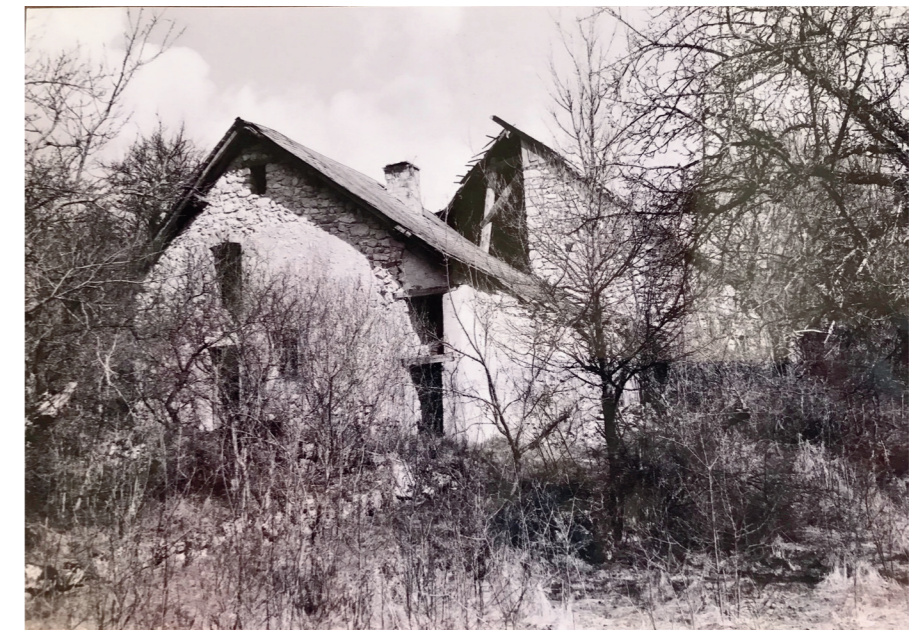
Fig 5 : Photographie noir et blanc prise depuis le chemin, pignon sud – 1972 – archives personnelles des propriétaires.
