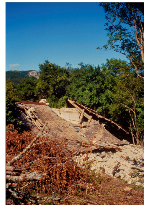
Fig 9 : Photographie en couleur prise depuis le chemin, pignon sud. © Laurence Veillet, juin 1993
